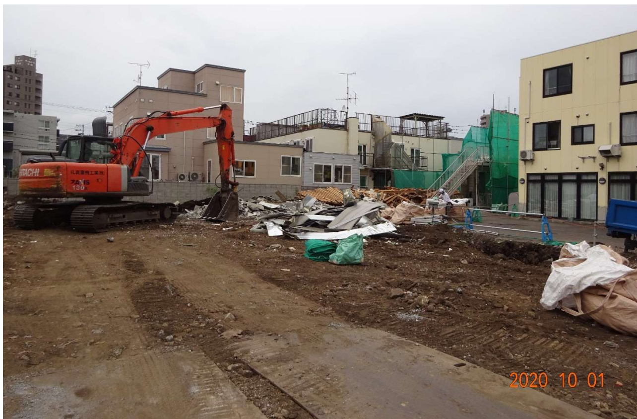
解体はゆうあい施設の一部を残すだけの状況になりました。
