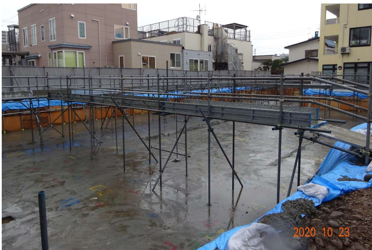
南側から撮影した写真です。
