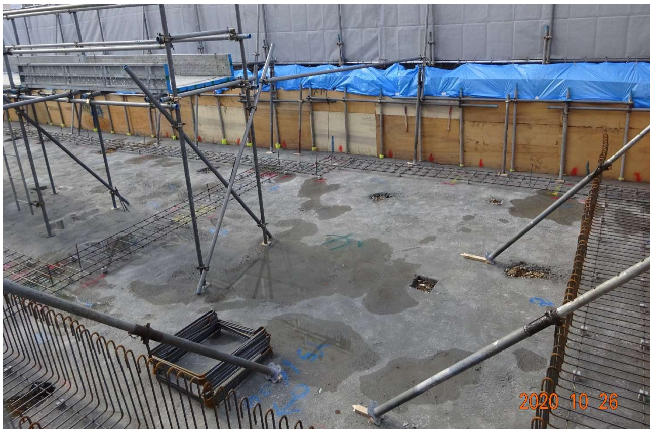
ゆうあい跡地に組まれた鉄筋。
