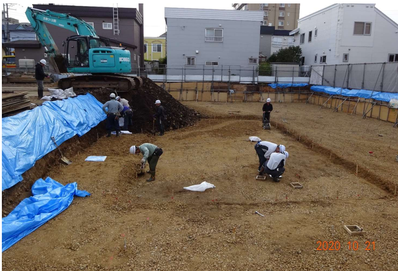
掘削作業を概ね終えた状況です。
