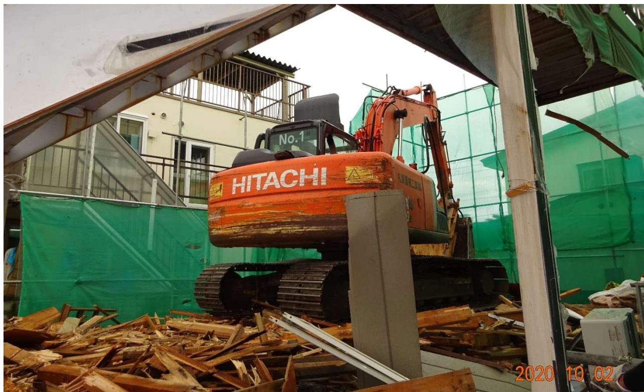
不安定な足場を、ショベルカーは廃材等で穴埋め等をして慎重に作業しています。
