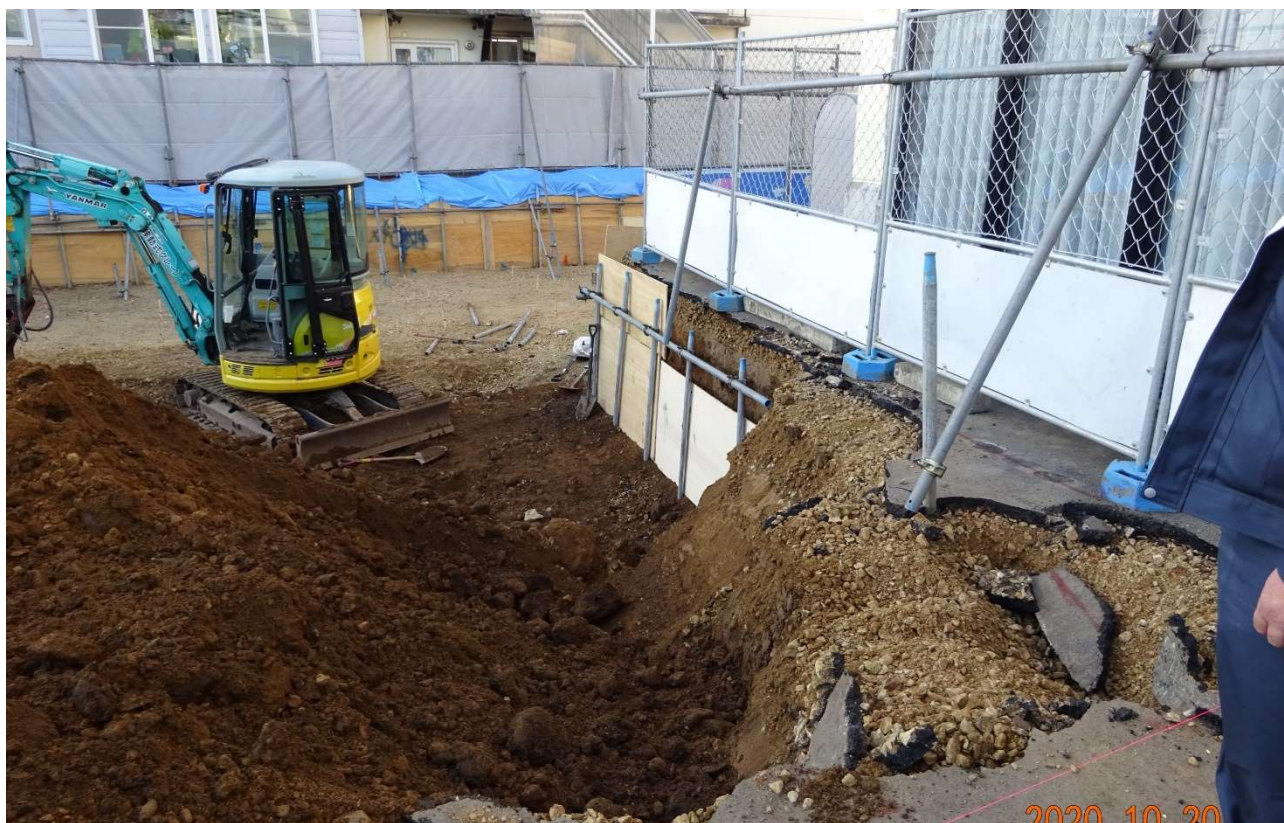
小型ショベルカーで単管を打ち込み土留めをします。
