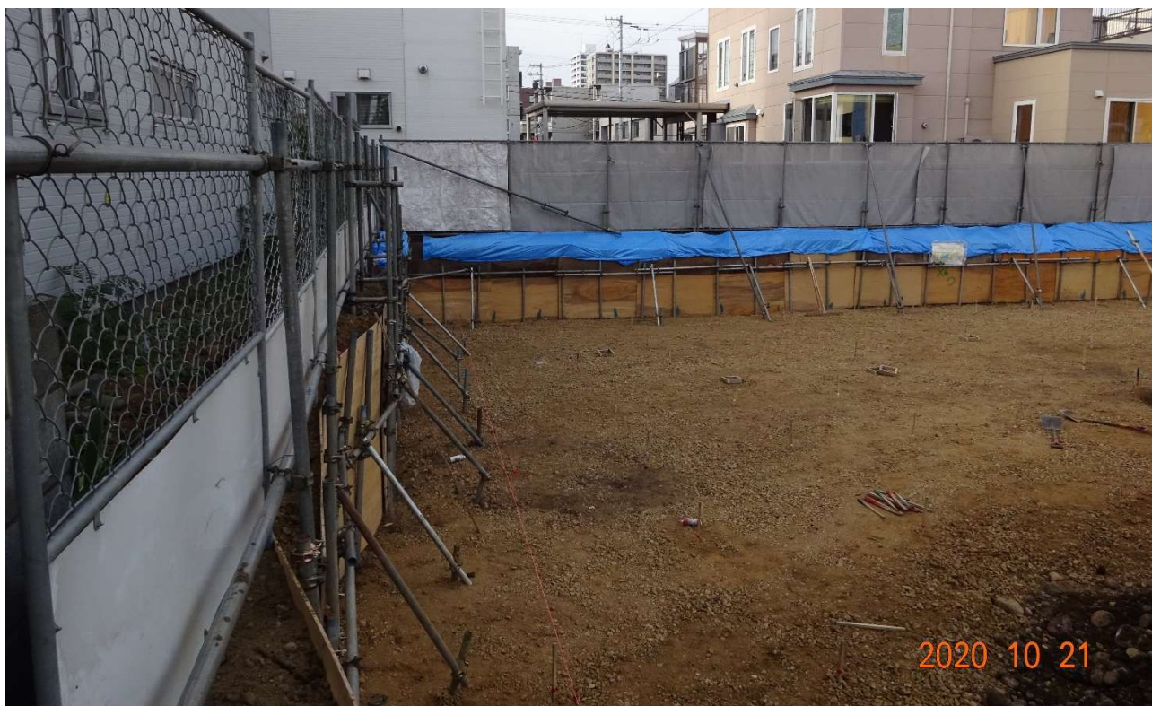
同じ位置でホップの施設跡の整地状態を撮影しています。
