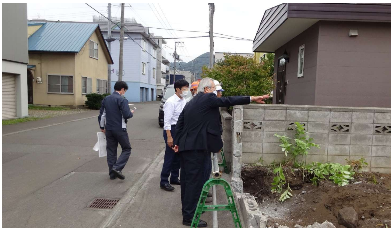
工事関係者が現場の状況を確認しています。
