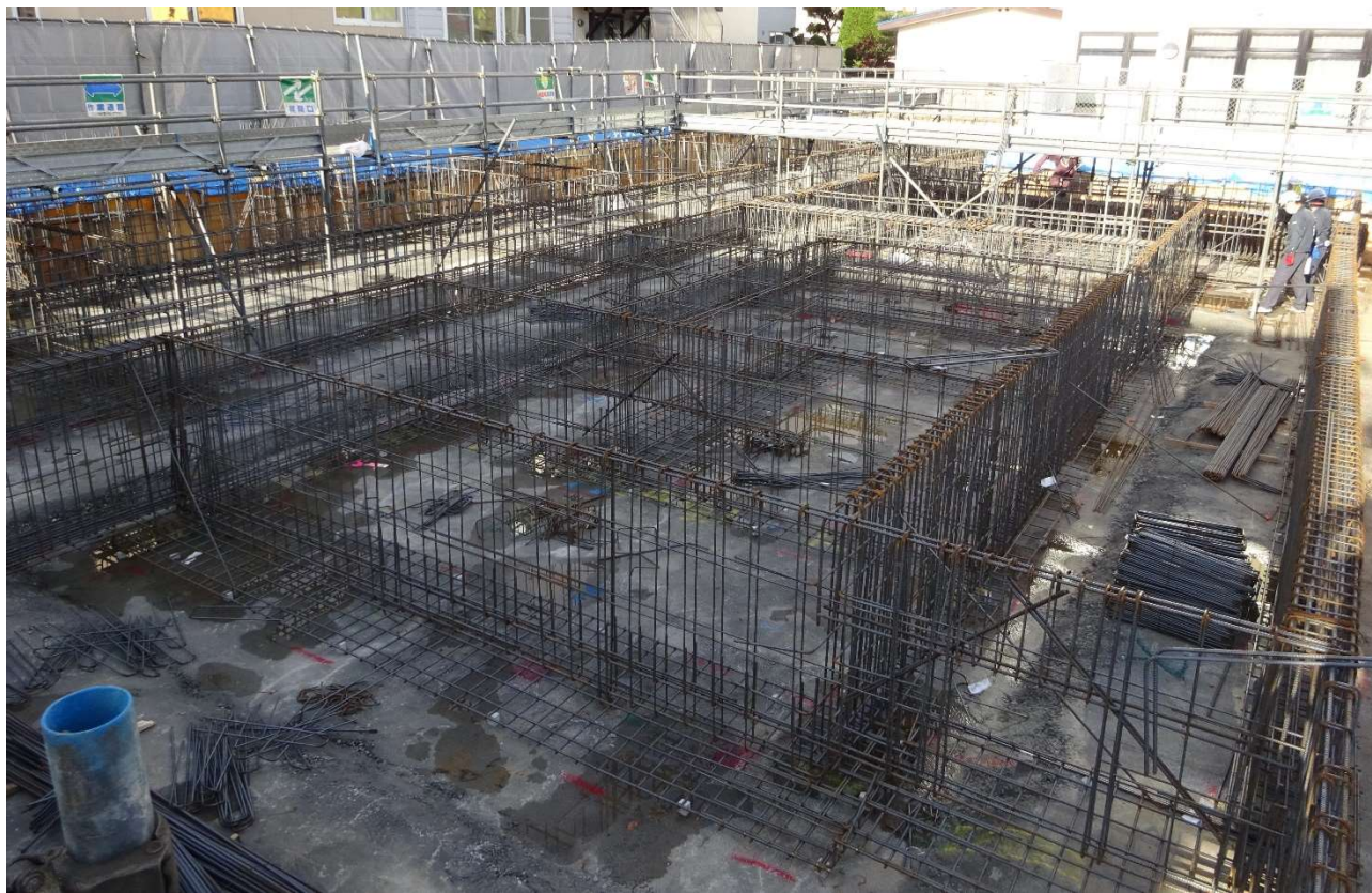
自立ホーム方向を見通した配筋作業の状況です。
