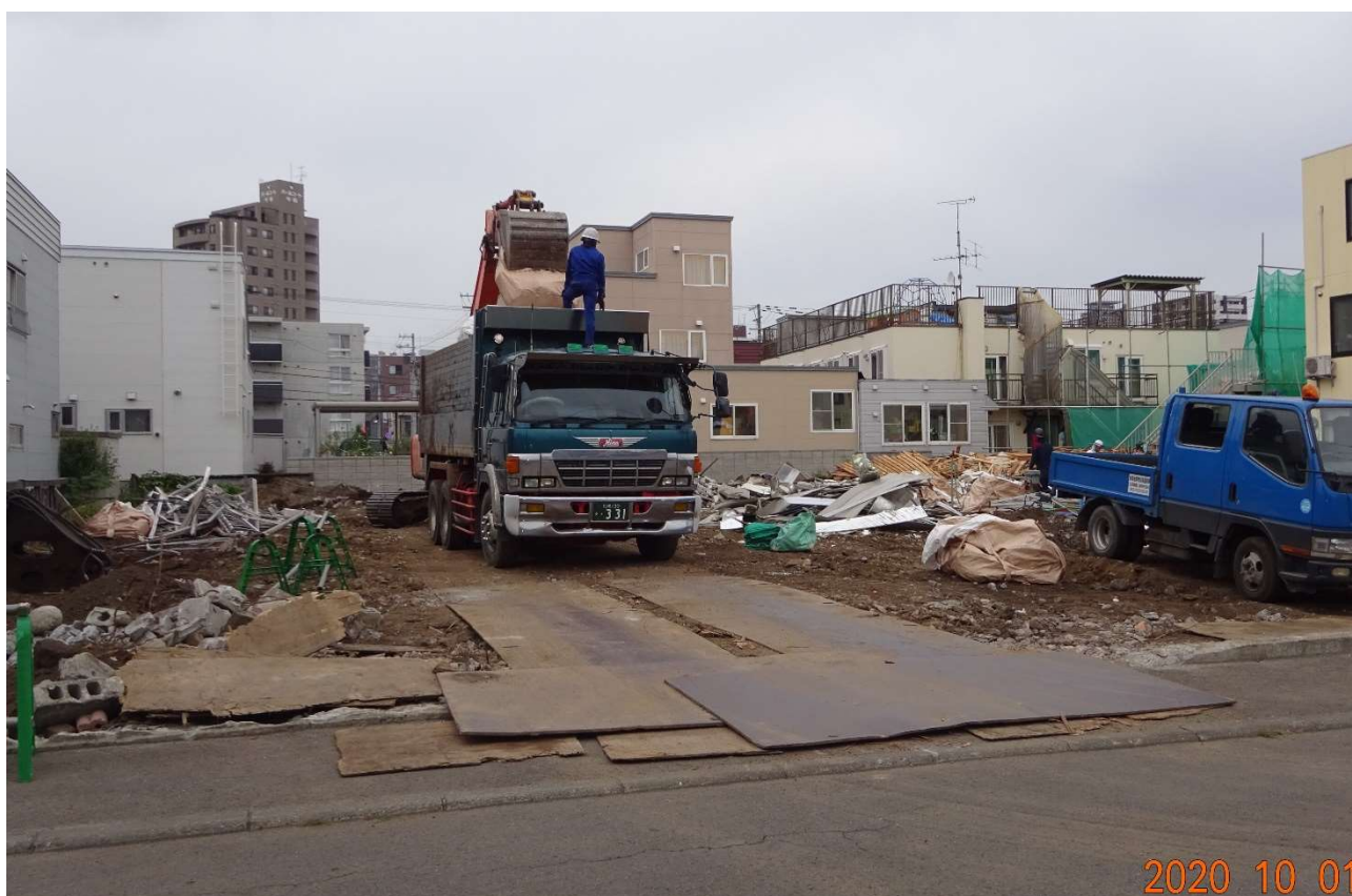
ダンプカーにより逐次廃材を搬送しています。
