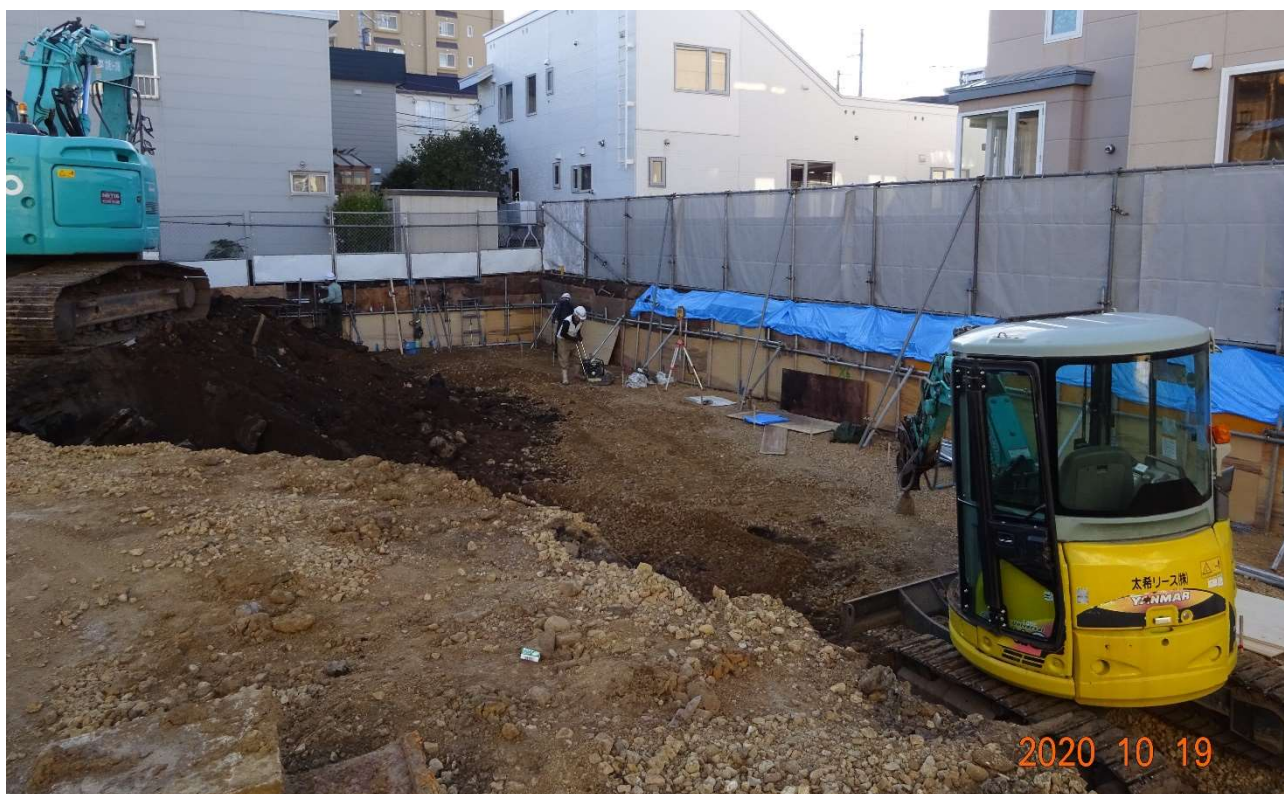
ホップの施設跡から更に南東に掘削を広げています。
