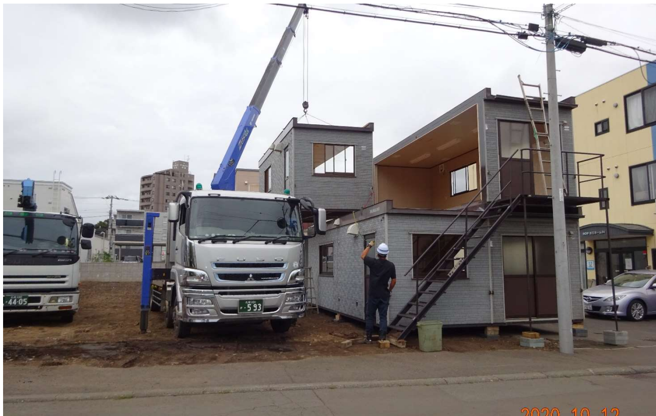
構内にプレハブ事務所を運んでいます。
