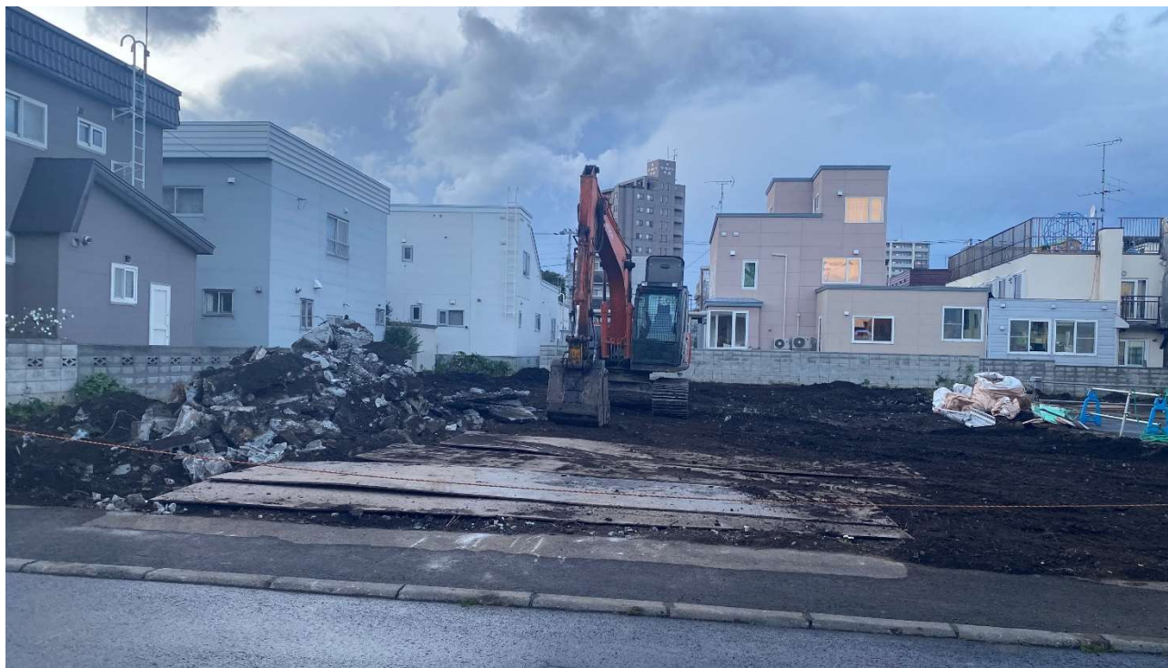
構内には瓦礫が一部残すのみとなりました。
