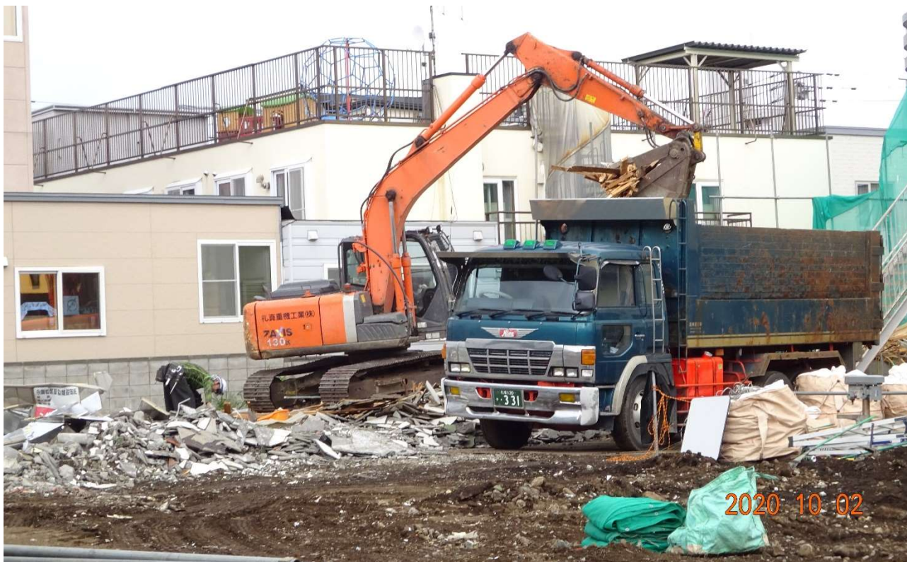
廃材を適時搬出しています。
