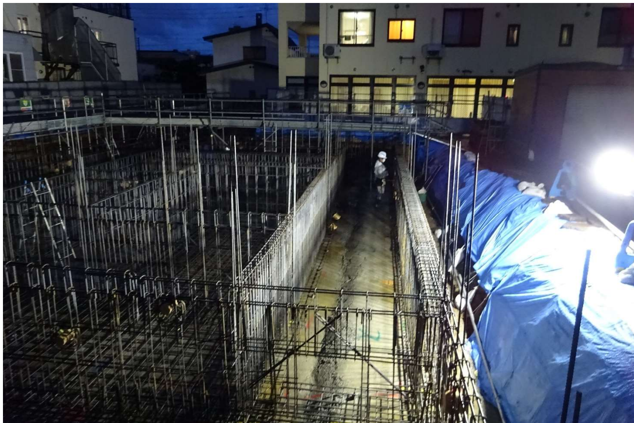
自立ホーム方向を見通した照明下の配筋作業の状況です。
