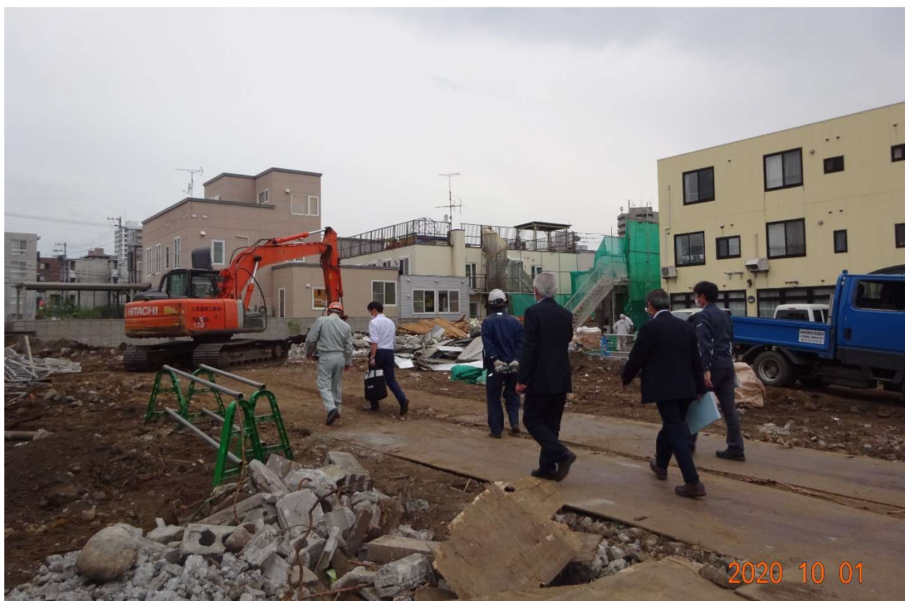
現場構内を確認しています。
