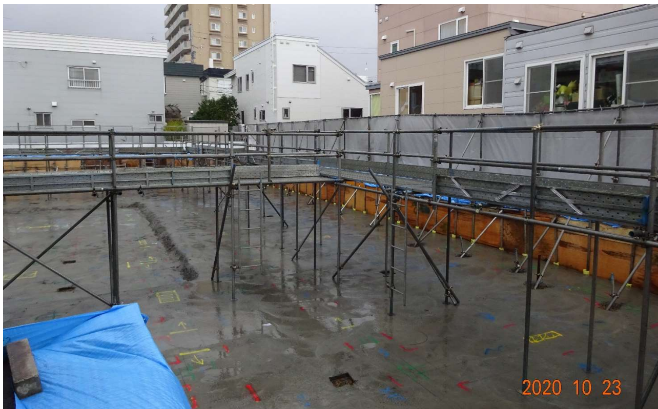
自立ホーム 2 4 から見た通路足場の組立状況です。
