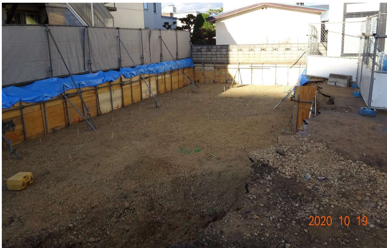
掘削作業を終えたゆうあい跡地の状況です。
