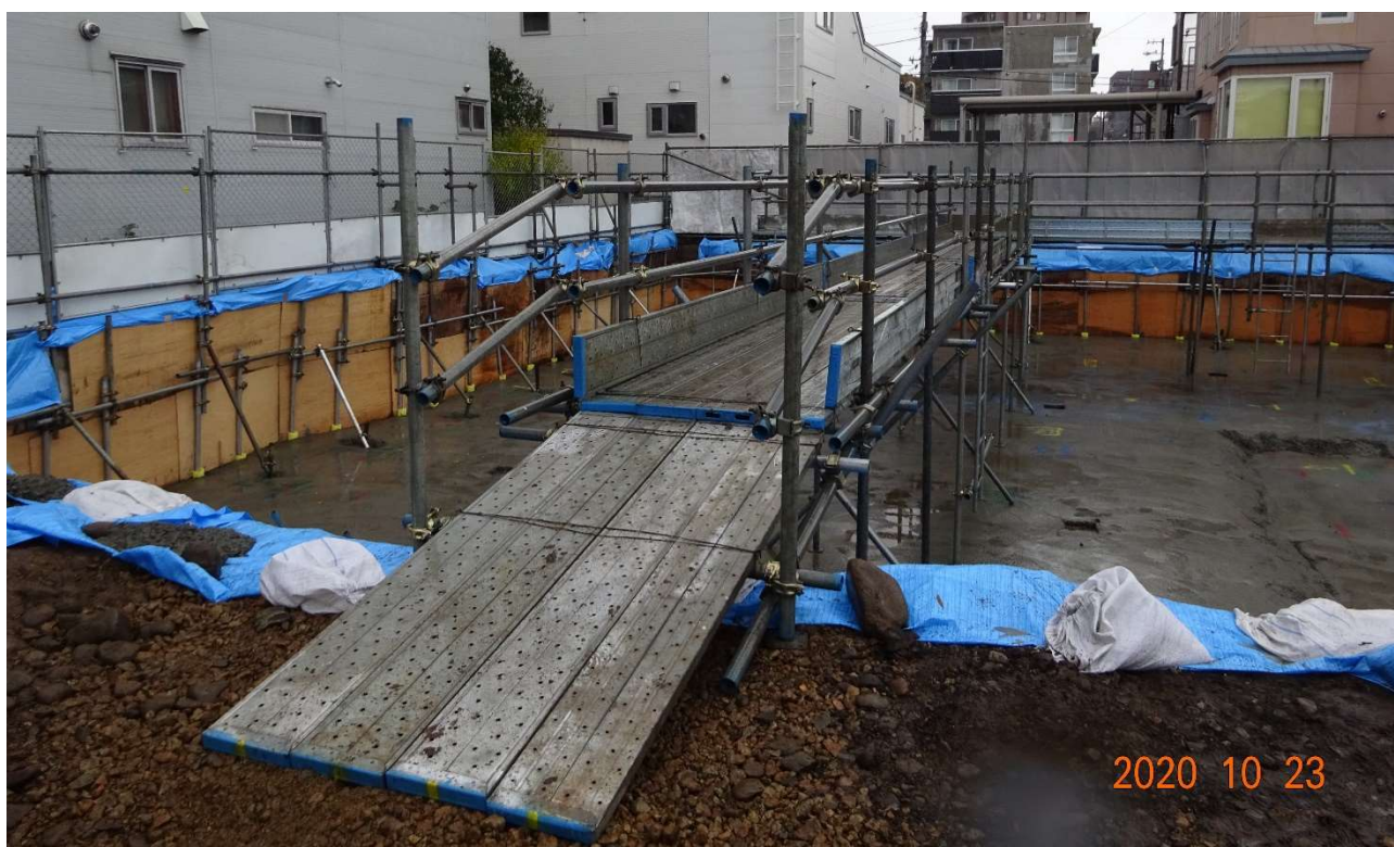
邸宅があった位置に設置された通路足場入り口です。
