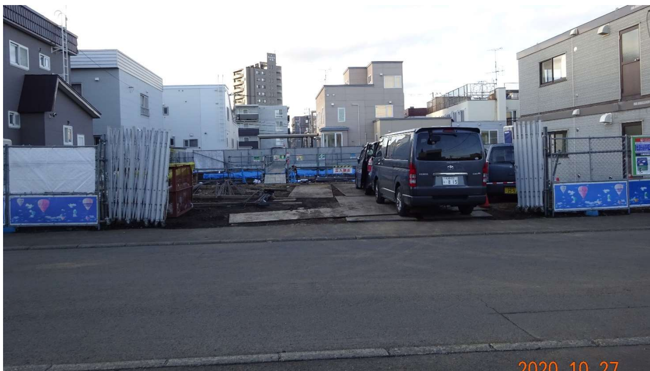
安全の為に敷地周辺には簡易柵を設けて、休業時はアコーディオン式で閉鎖します。
