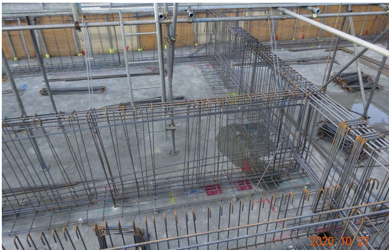
基礎部の配筋作業の状況です。
