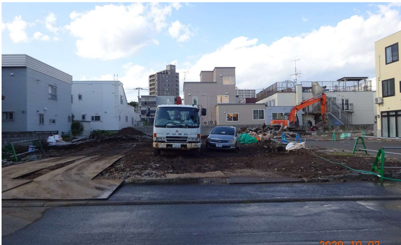
正面からの敷地全体画像、ほぼ更地状態となっています。
