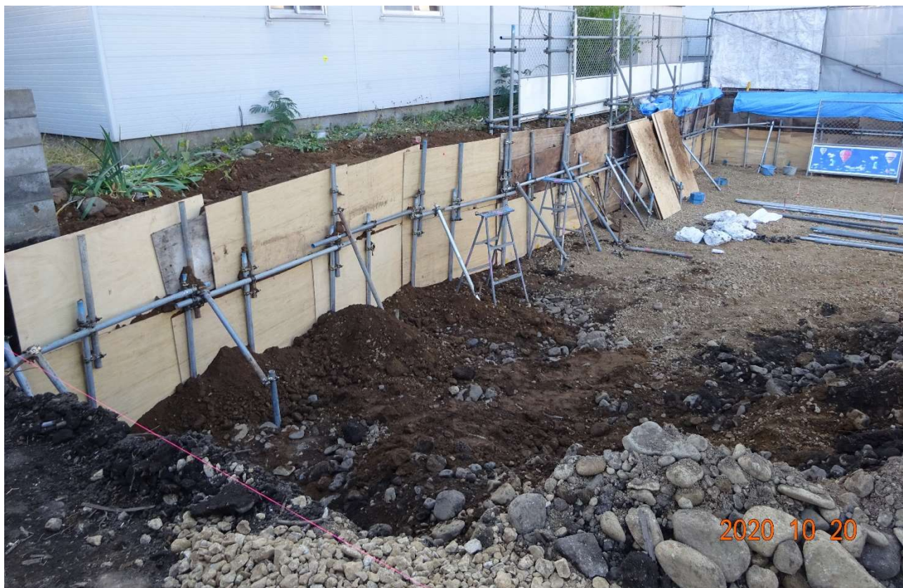
ホップの施設前も掘削と土留めの作業が進んでいます。
