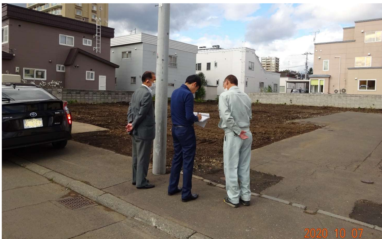
建築に必要なガス管、水道管の位置を記録しました。
