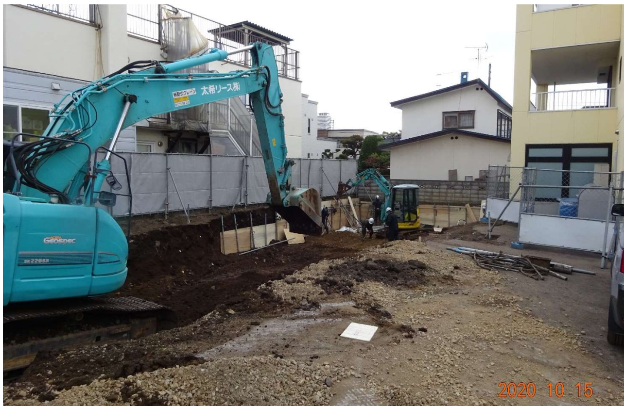
ゆうあい施設跡の掘削状況です。
