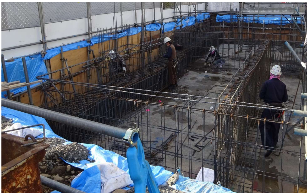
基礎部の配筋作業の状況です。手作業により進めています。
