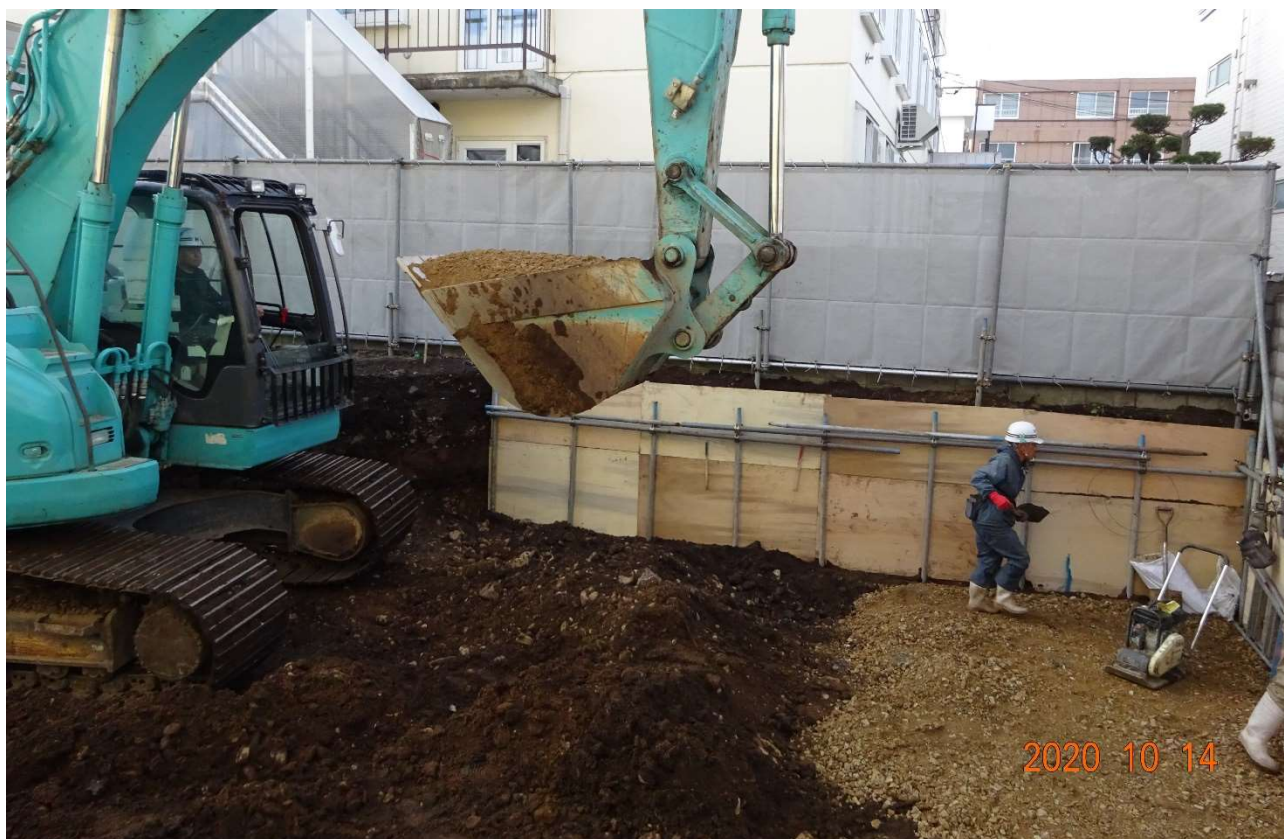
ショベルカーにより砂利を掘削底面に敷き詰めています。
