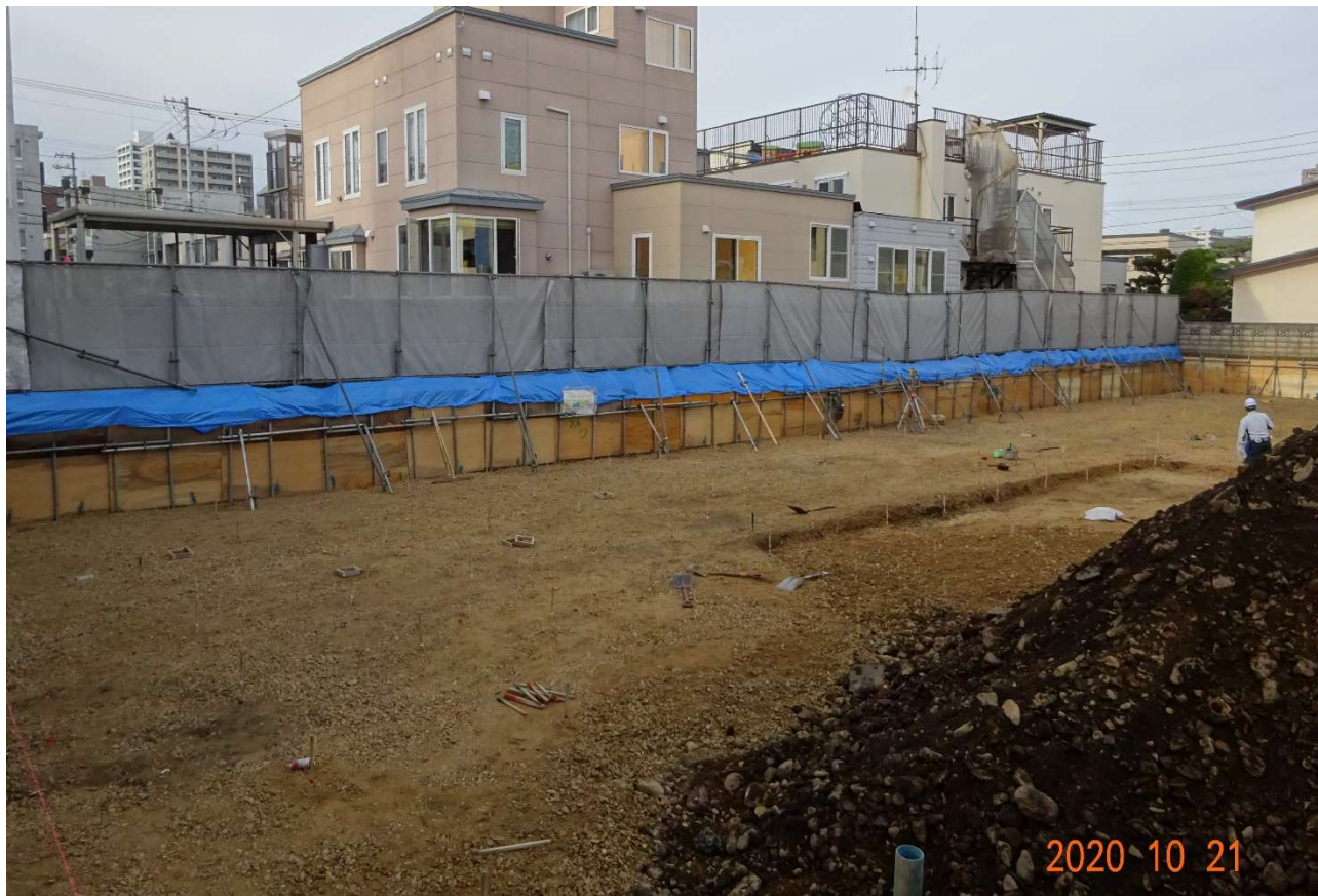
南側から見た構内の状況です。綺麗に整地がされています。
