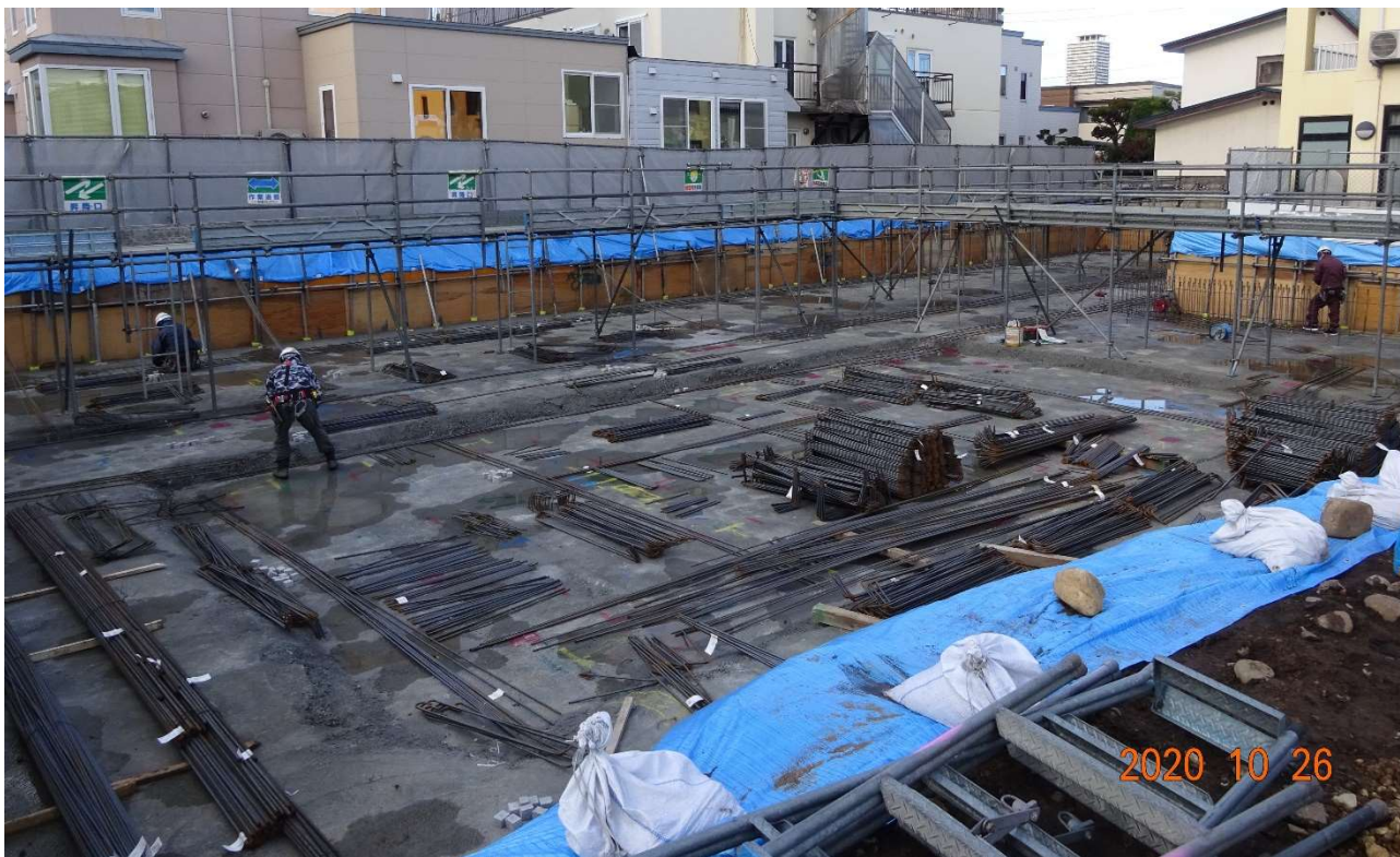
作業員が配筋作業を行っている様子です。
