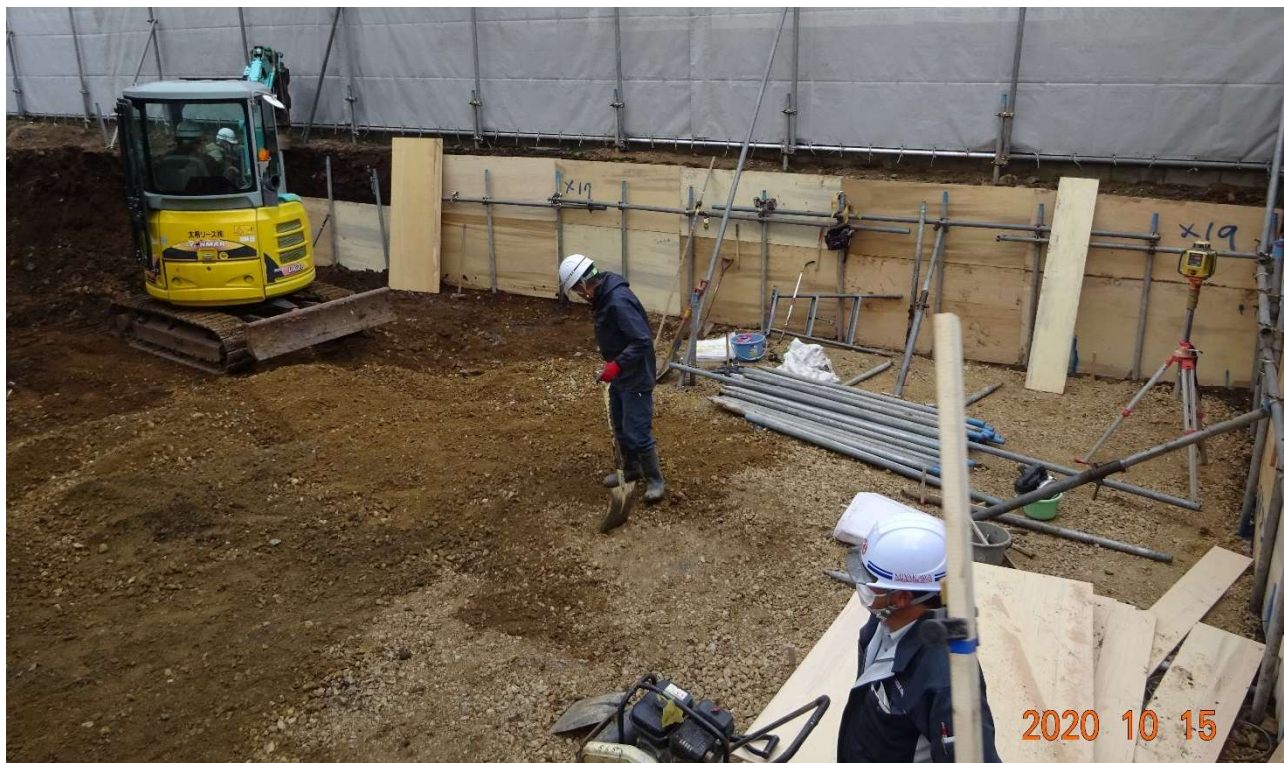
小型ショベルカーにより、砂利が敷設されています。
