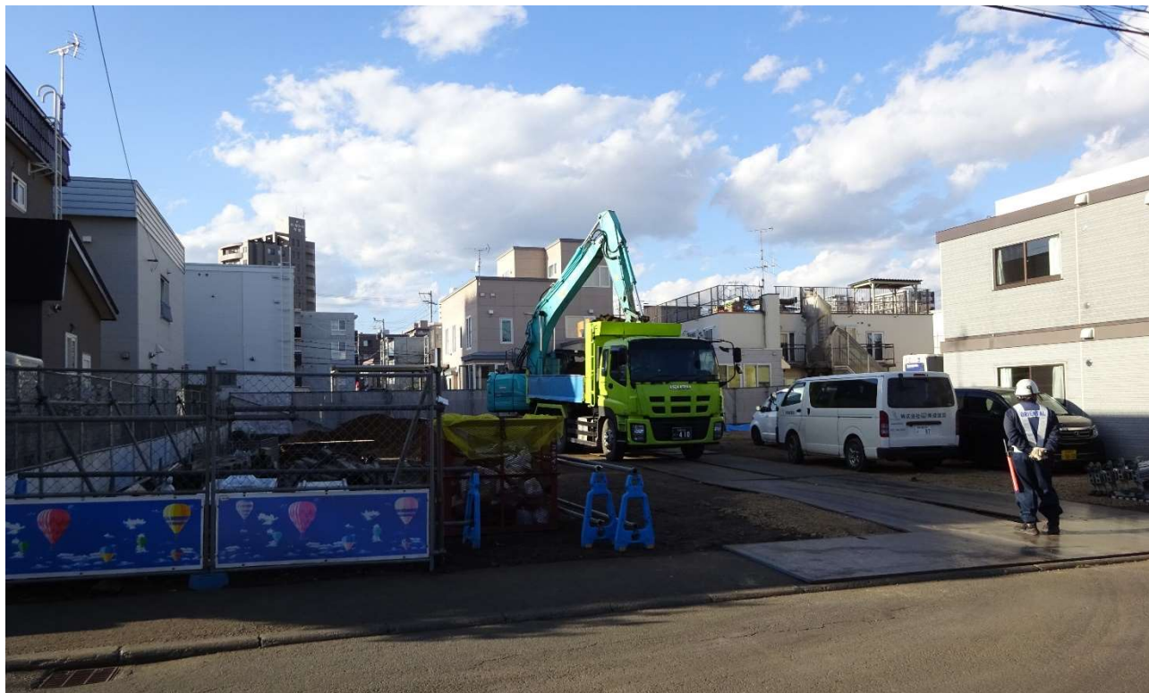
南側から見た構内の状況です。ダンプカーで排土を搬出しています。
