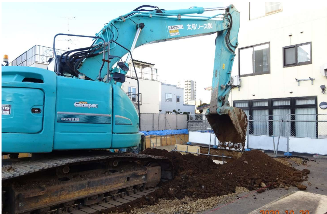
自立ホーム24の正面が掘削されています。
