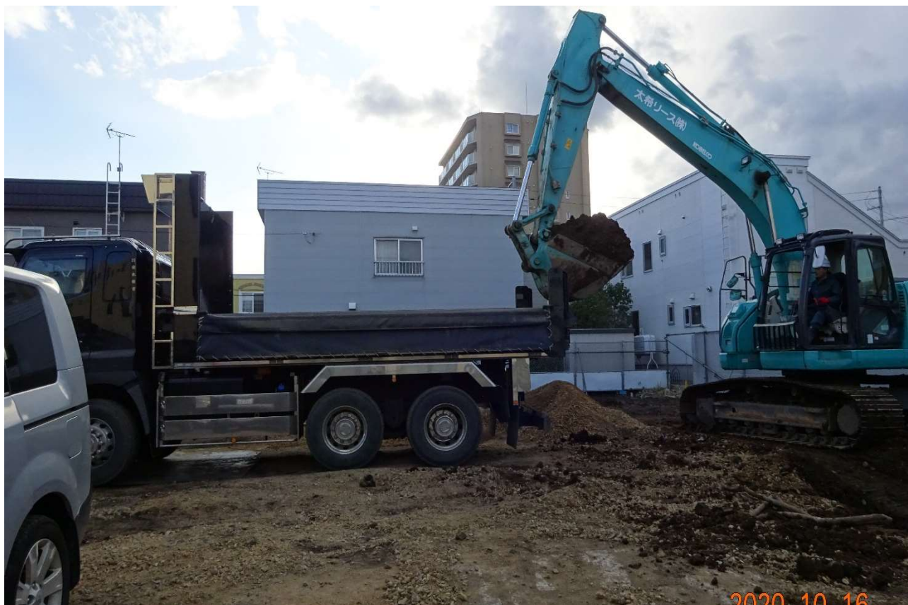
排土をダンプカーにより排出しています。
