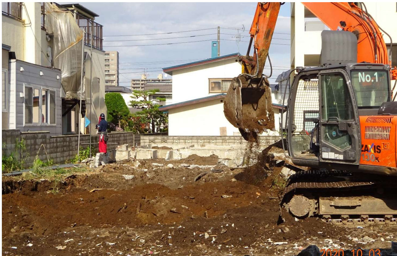
コンクリート片が残土内にはないか確認しながら作業しています。
