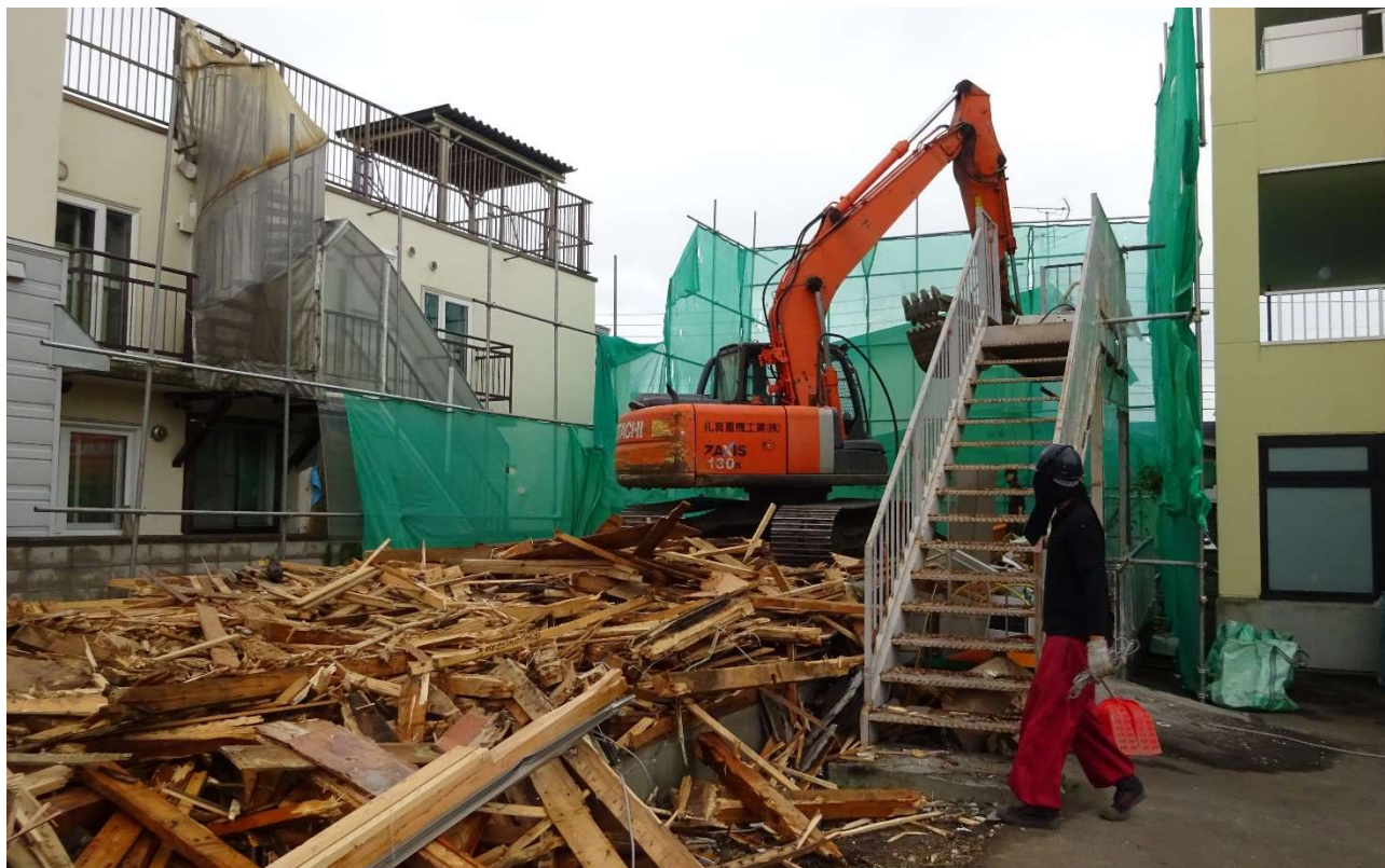
ショベルカーと安全係により、狭い区域にて木材構造物を解体しています。
