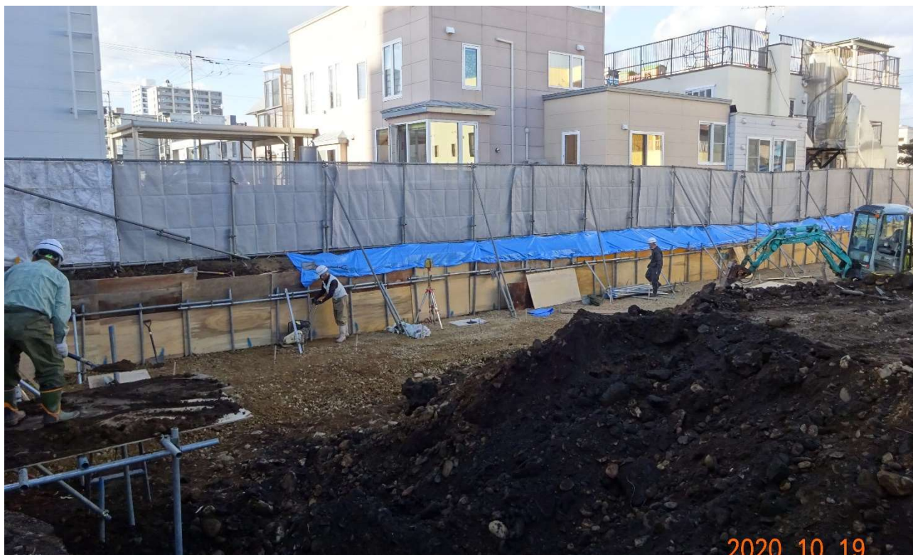
ビニールシートでのり面を覆い保護しています。
