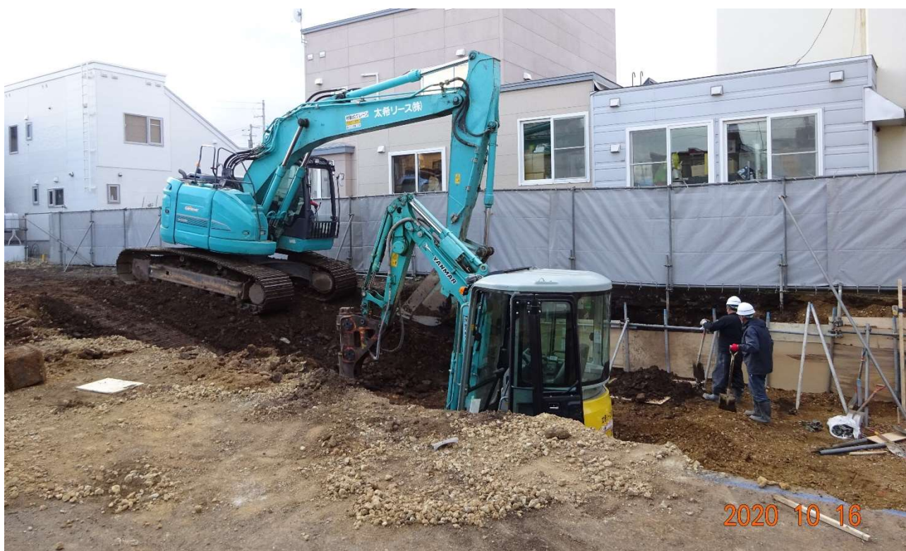
大型と小型のショベルカーによる掘削が進んでいます。
