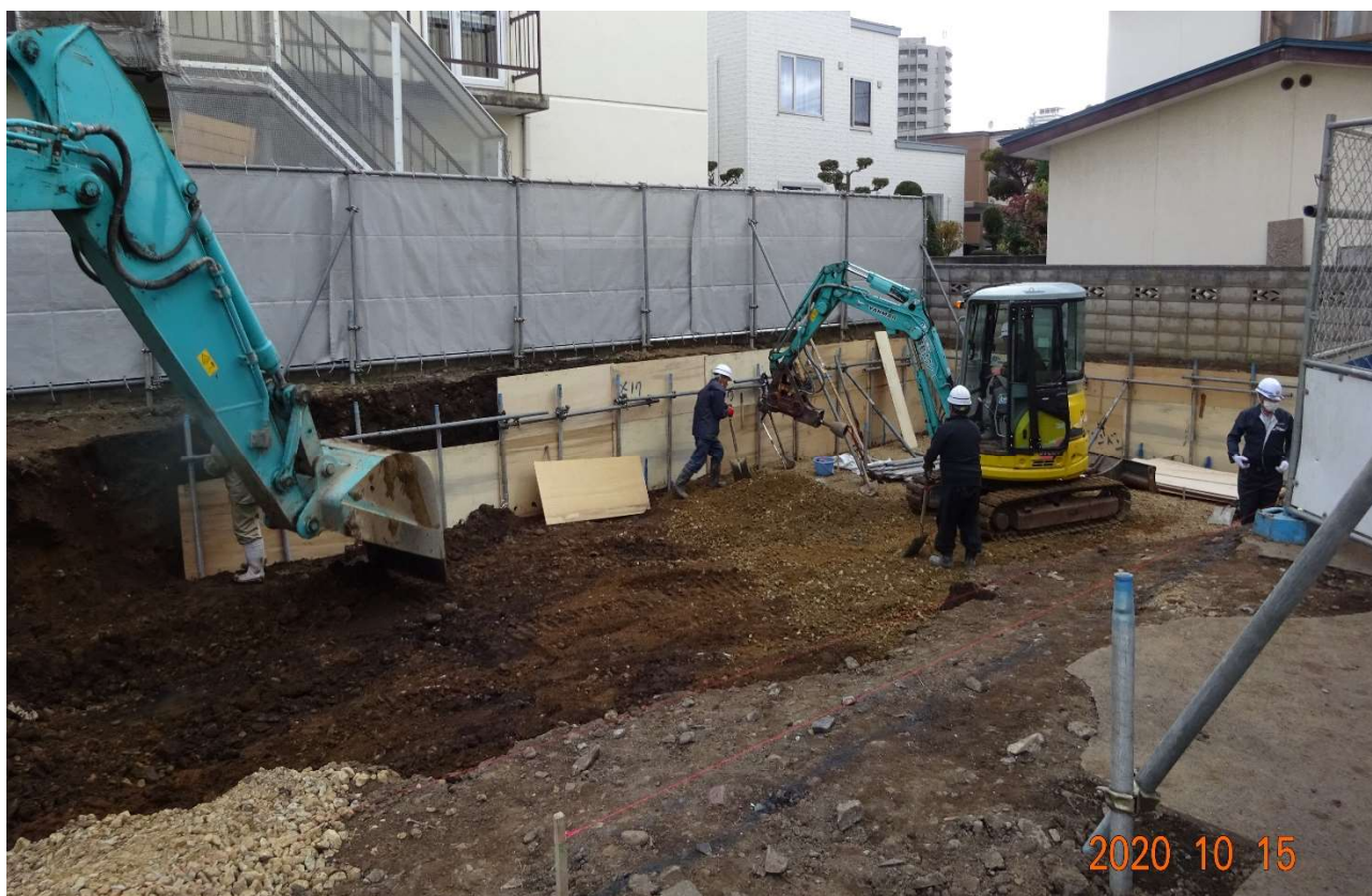
2台のショベルカーの特長を組み合わせた掘削作業が行われています。
