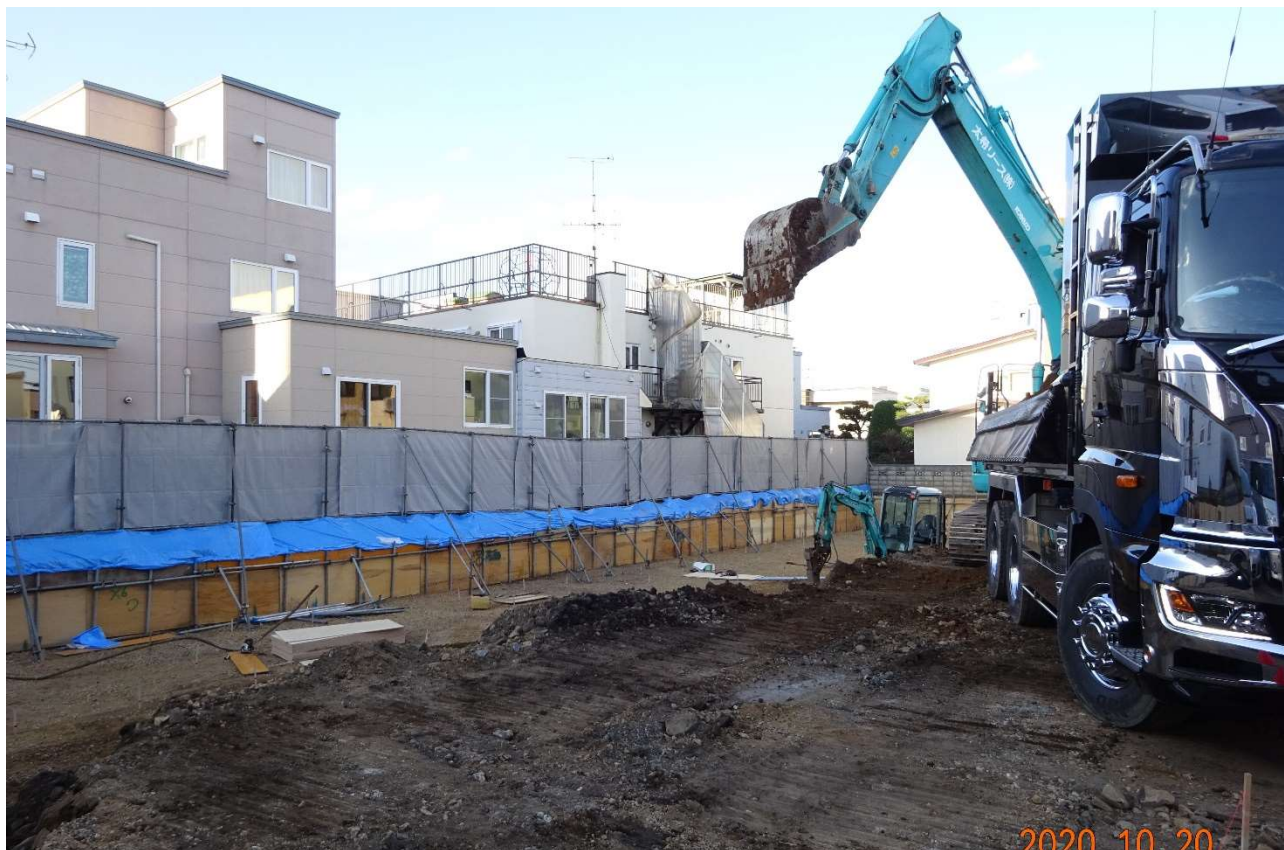
ダンプカーはピストンで排土を運搬しています。
