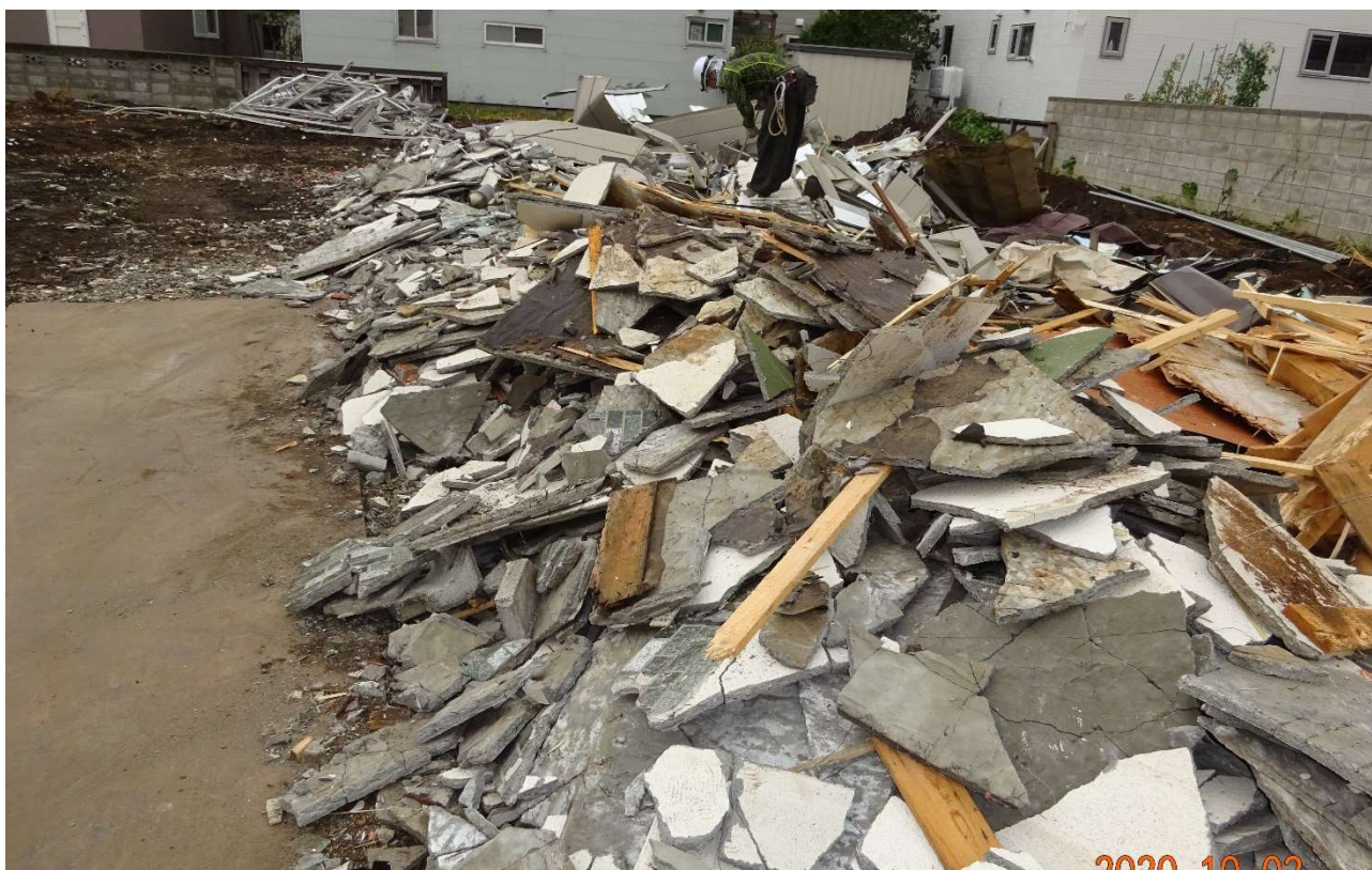
再利用できない網等が混入したコンクリート片。
