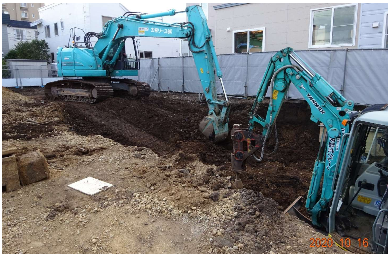
2台のショベルカーにより、ホップ施設跡の掘削を行っています。
