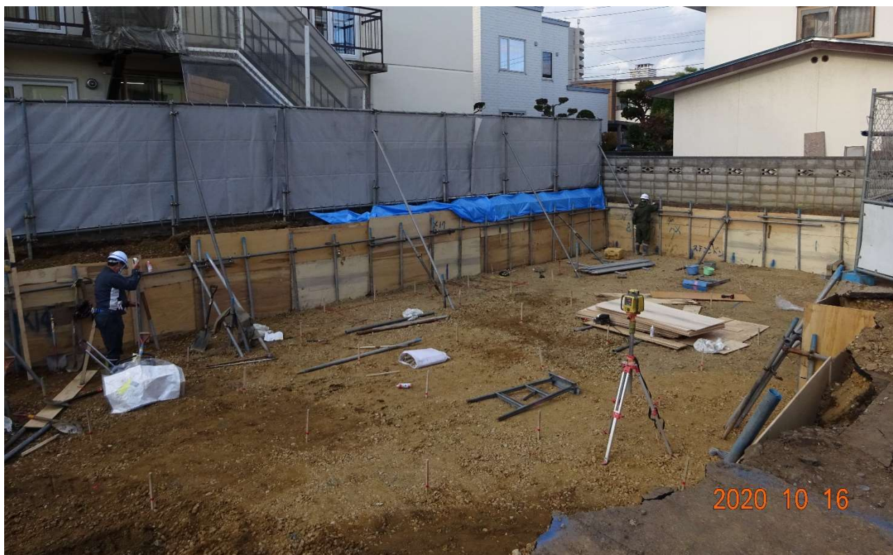
ゆうあい施設跡の掘削状況です。
