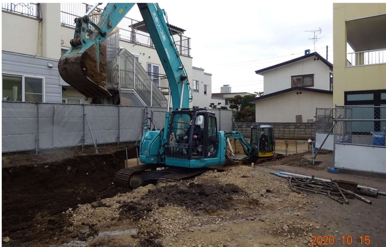
大型と小型のショベルカーによる掘削が進んでいます。
