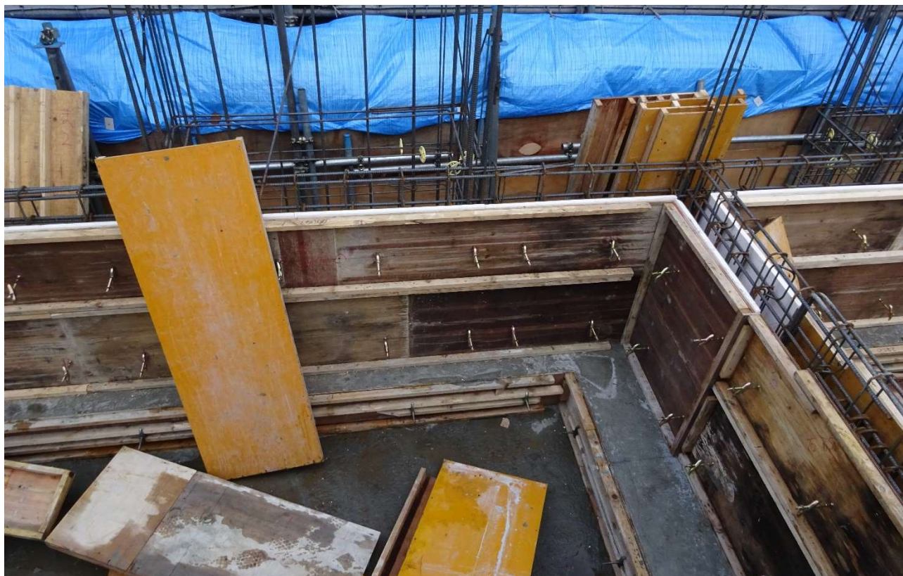
この板の間の配筋の中にコンクリートを入れて鉄筋コンクリート造とします。
