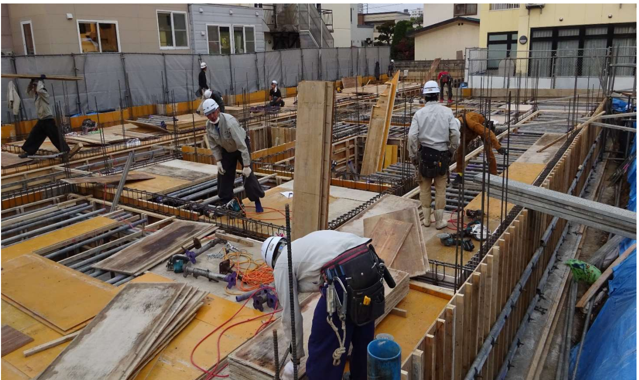
床材を切断して貼りつけています。
