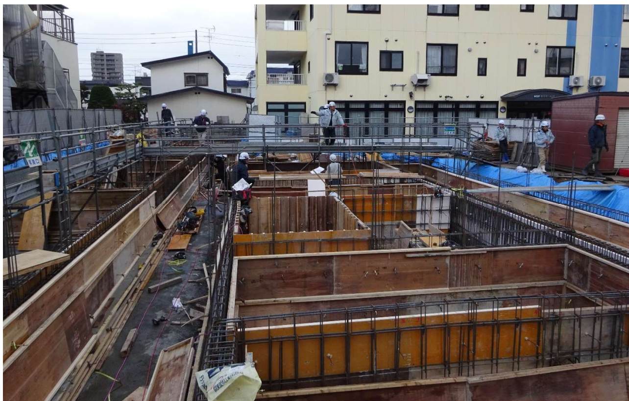
型枠内部の配筋状況が確認できます。基礎部の高さは 180 c m です。
