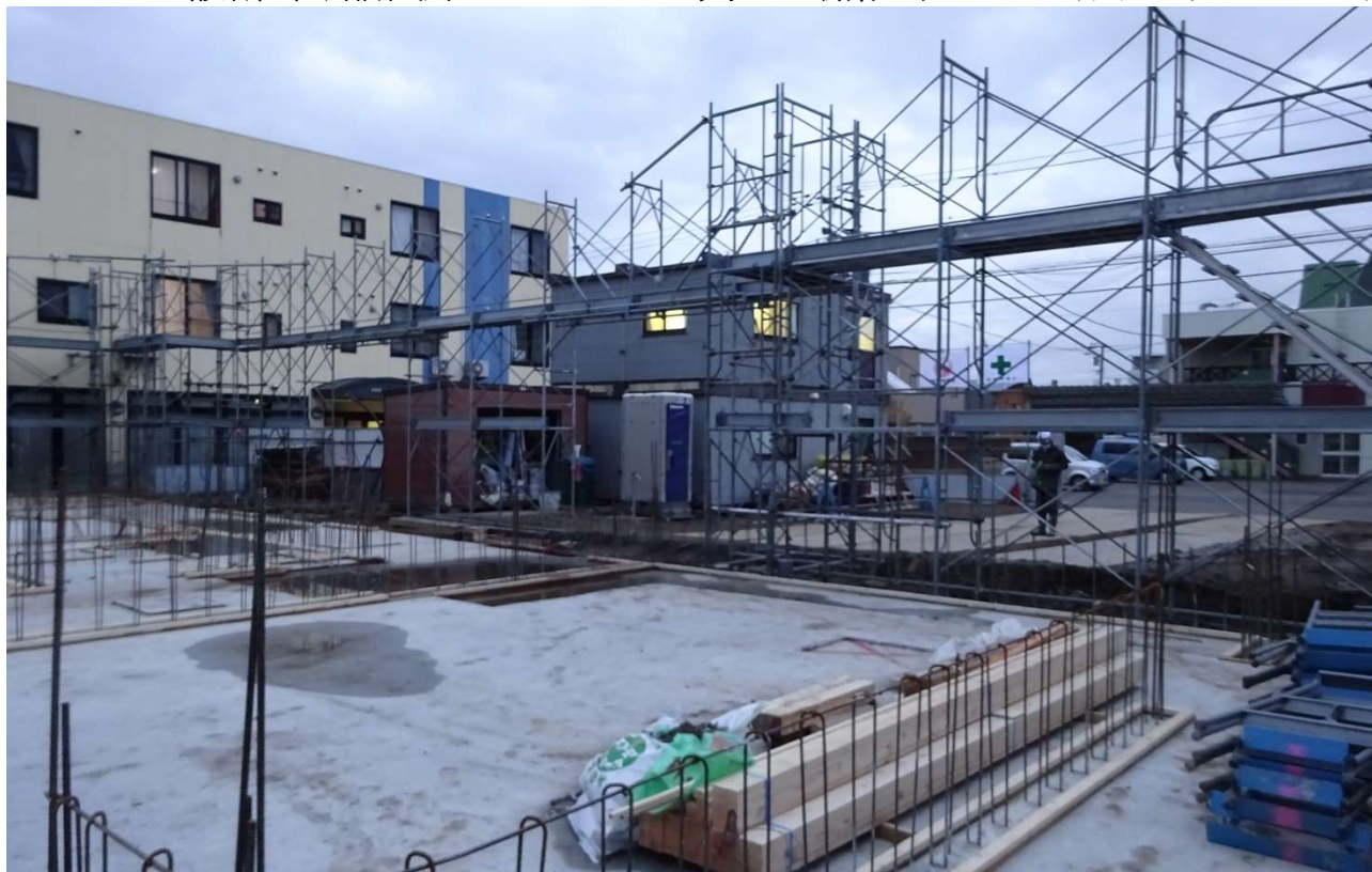
建物左奥に立ち、自立ホーム 2 4 を見通して撮影しました。
