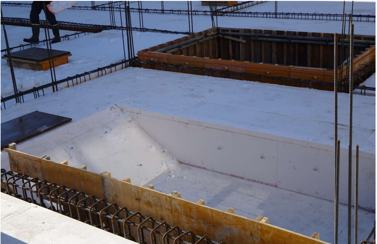
奥の長方形の型枠はエレベーター用であり、エレベータの大きさが理解できる画像です。
