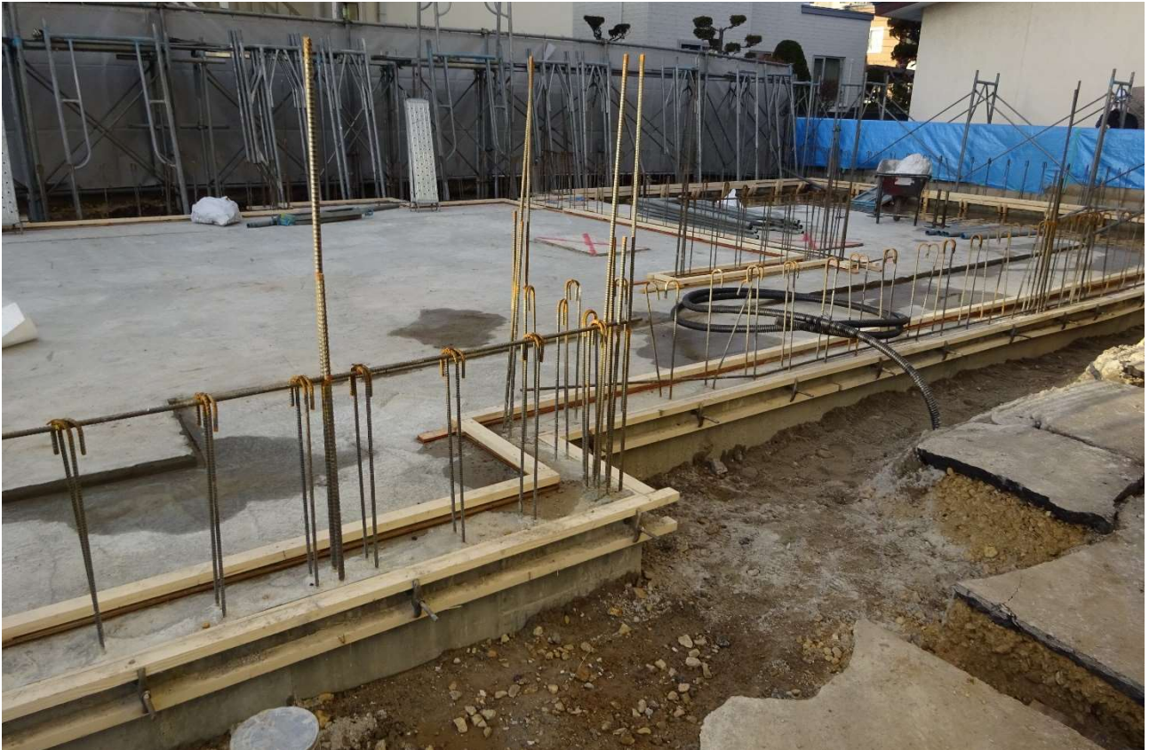
外壁を作る為の木枠 2 本が、床の周りに取り付けられています。
