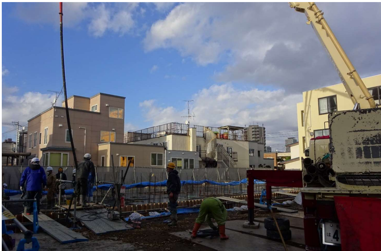
コンクリートミキサー車から運ばれた生コンを型枠内にいれています。
