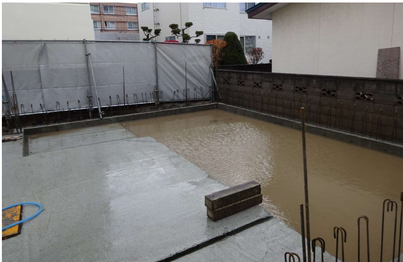
機械浴槽は右端の部分、奥の四角い凹みはユニットバスが配置される予定です。
