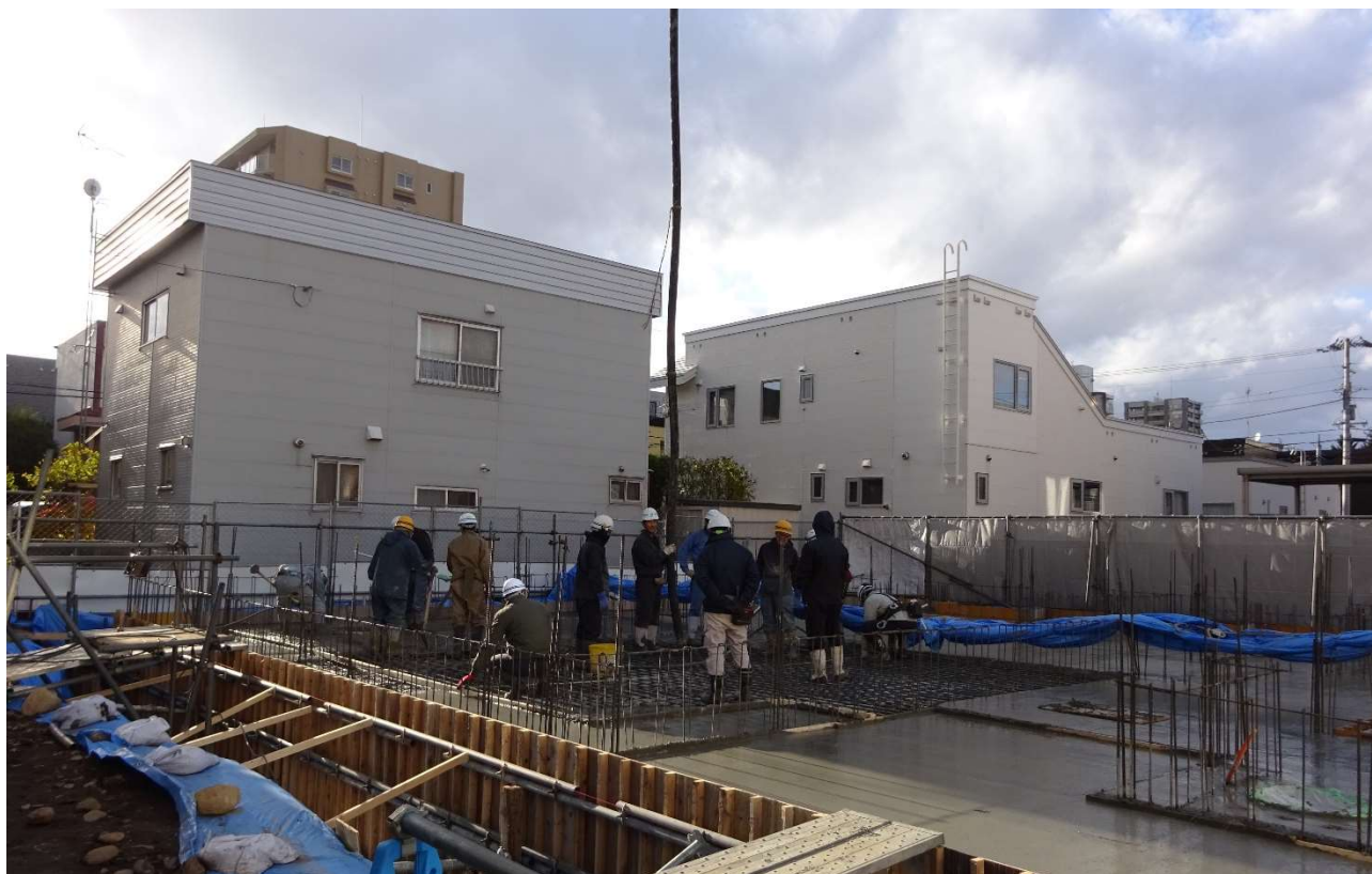
ホースが圧で踊らないように1名が保持して、作業員数人にて充填していきます。
