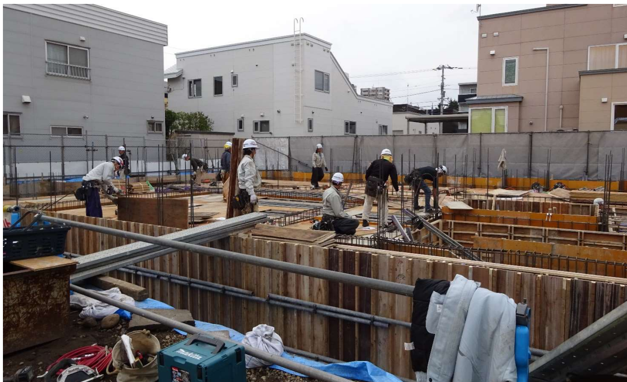
西側から見通した型枠作業の状況です。
