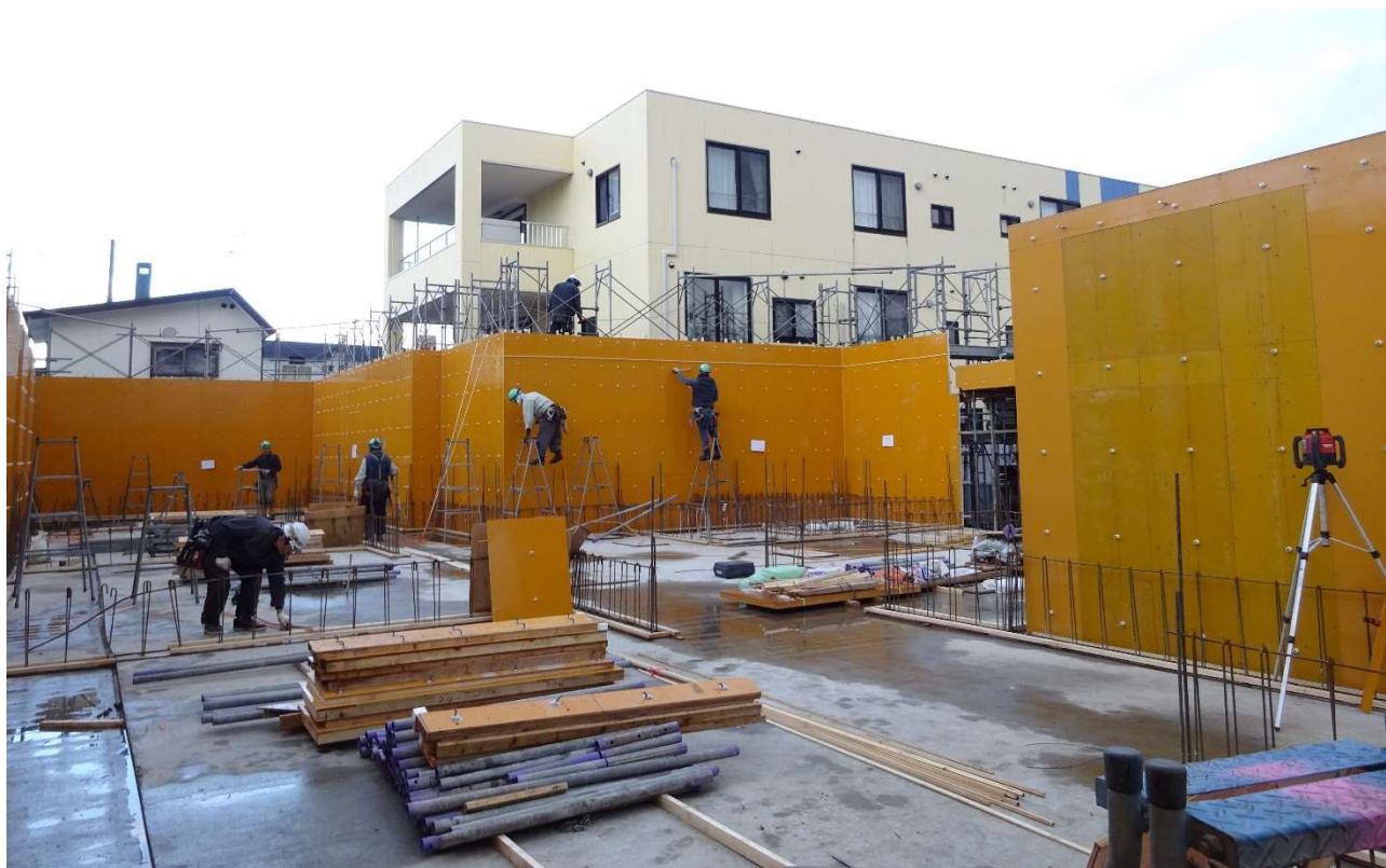
多くの型枠工員が作業にかかっています。
