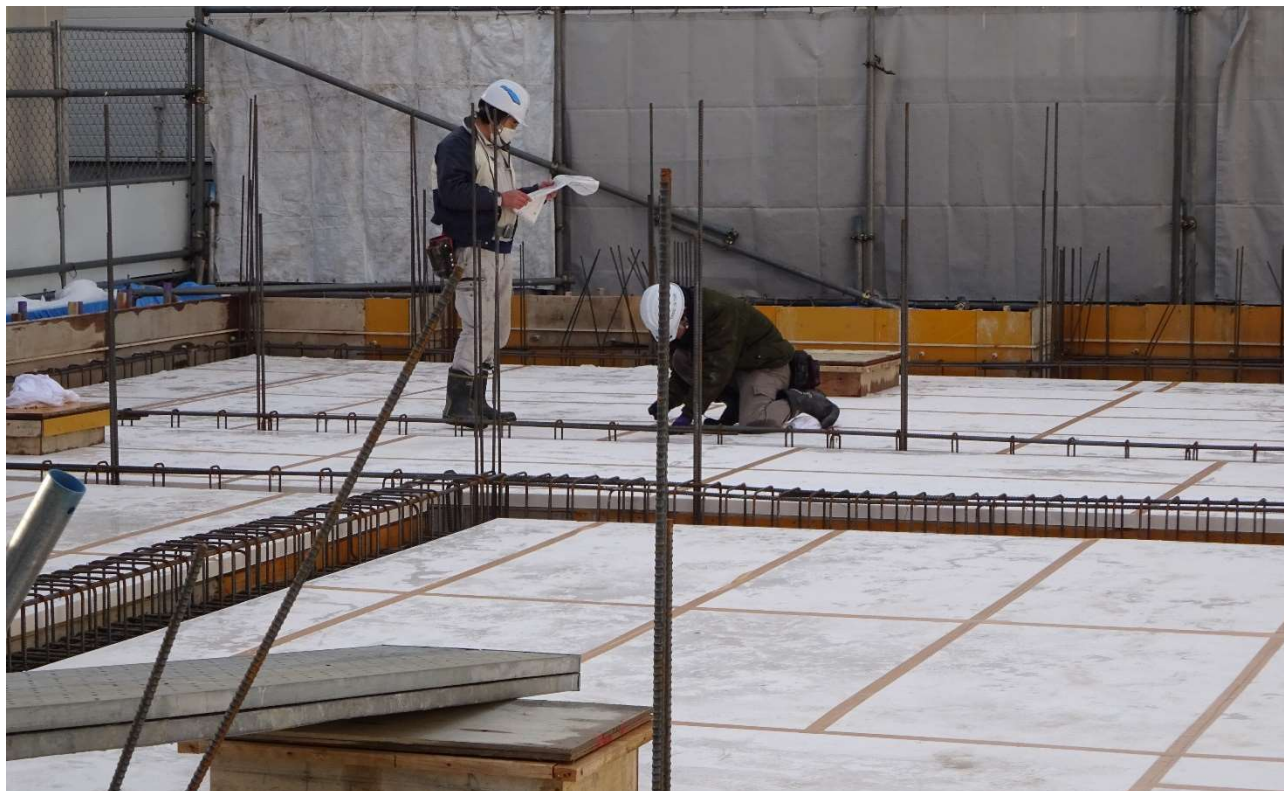
水回りの設備用スリーブ作業の状況です。
