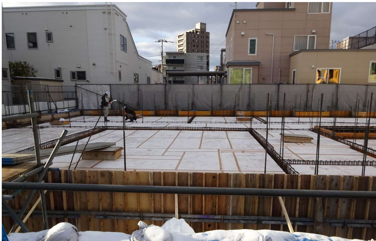
ホップ跡地側のスリーブ入作業の状況です。
