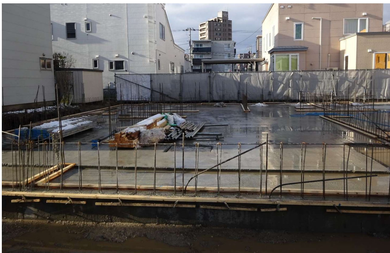
洗浄後の土台です。
