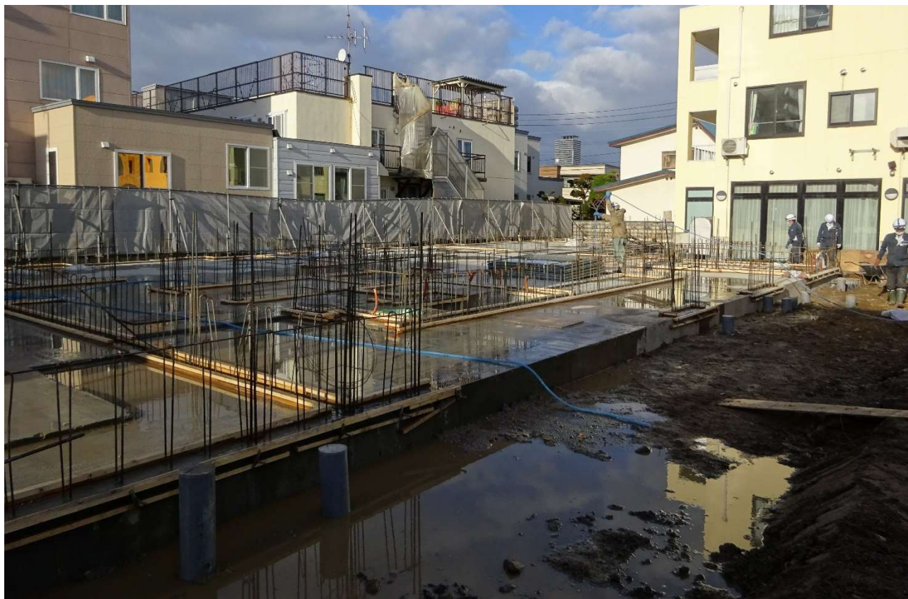
南からの撮影です、水で泥等を洗い流しました。
