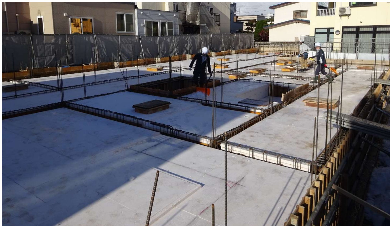
自立ホーム方向を見通した除雪の状況です。
