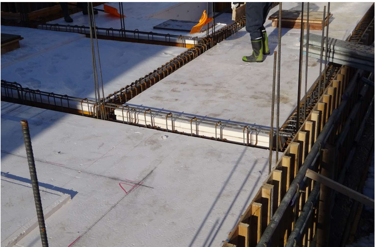
作業員が墨出し作業を行っています。
