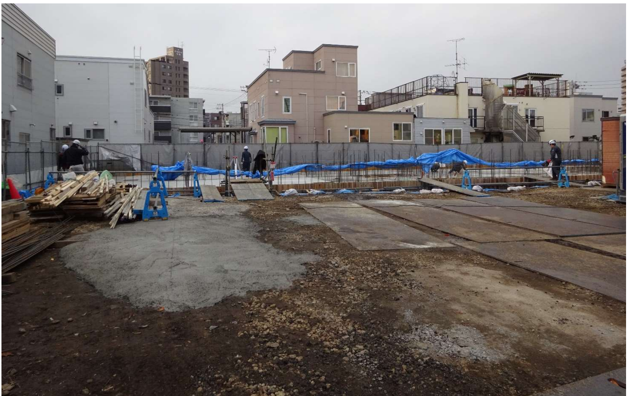
作業中の構内の状況です。
