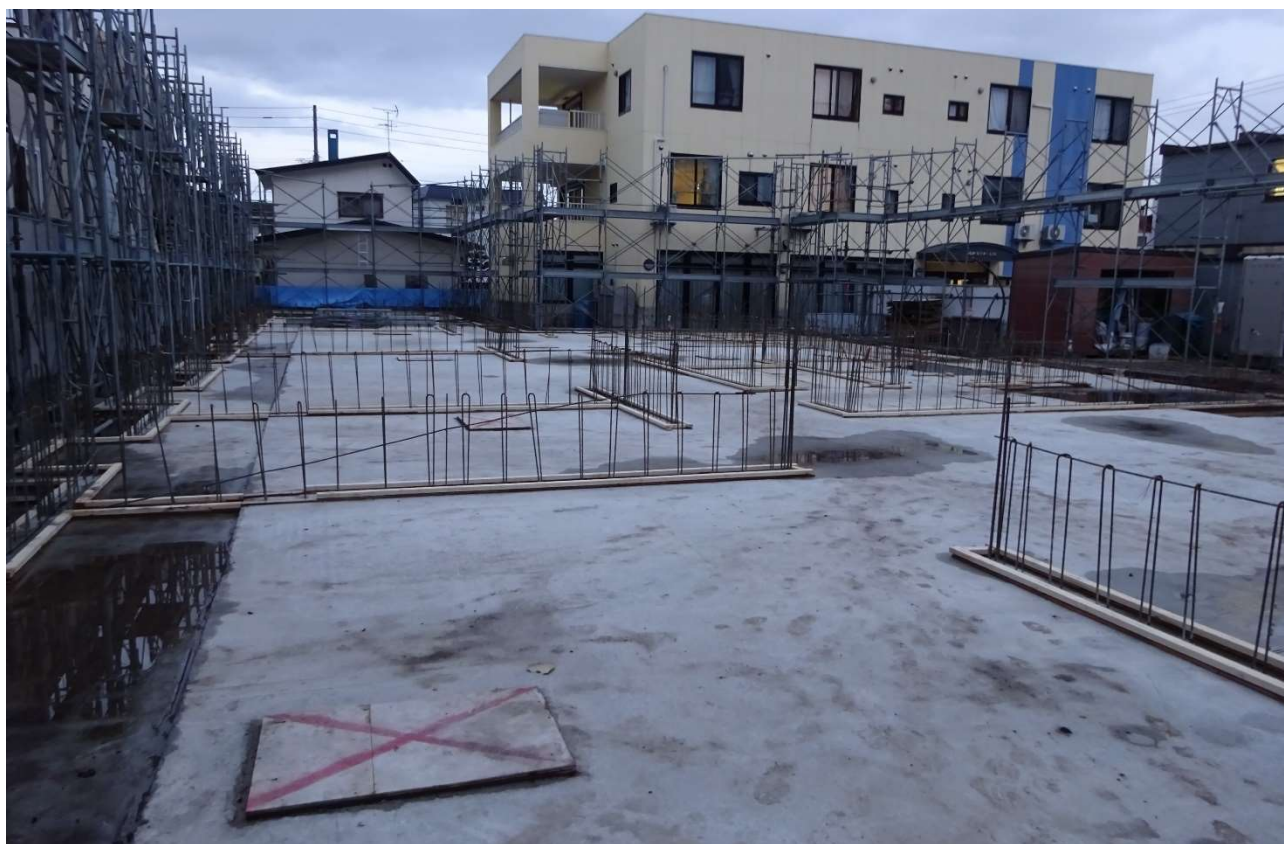
奥の自立ホーム 2 4 と比較するとかなり大きな建物である事がわかります。
