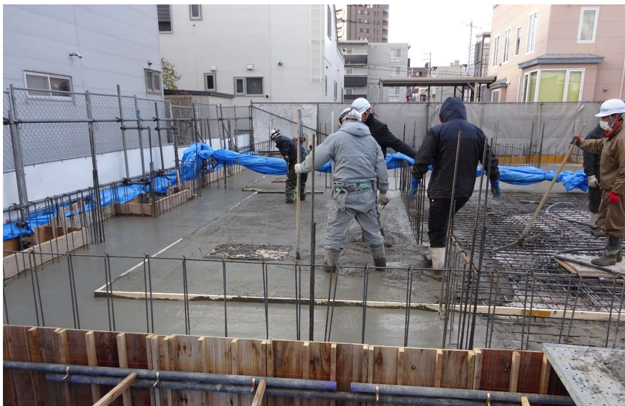
コンクリートの表面はレーキにて均されて平らになります。
