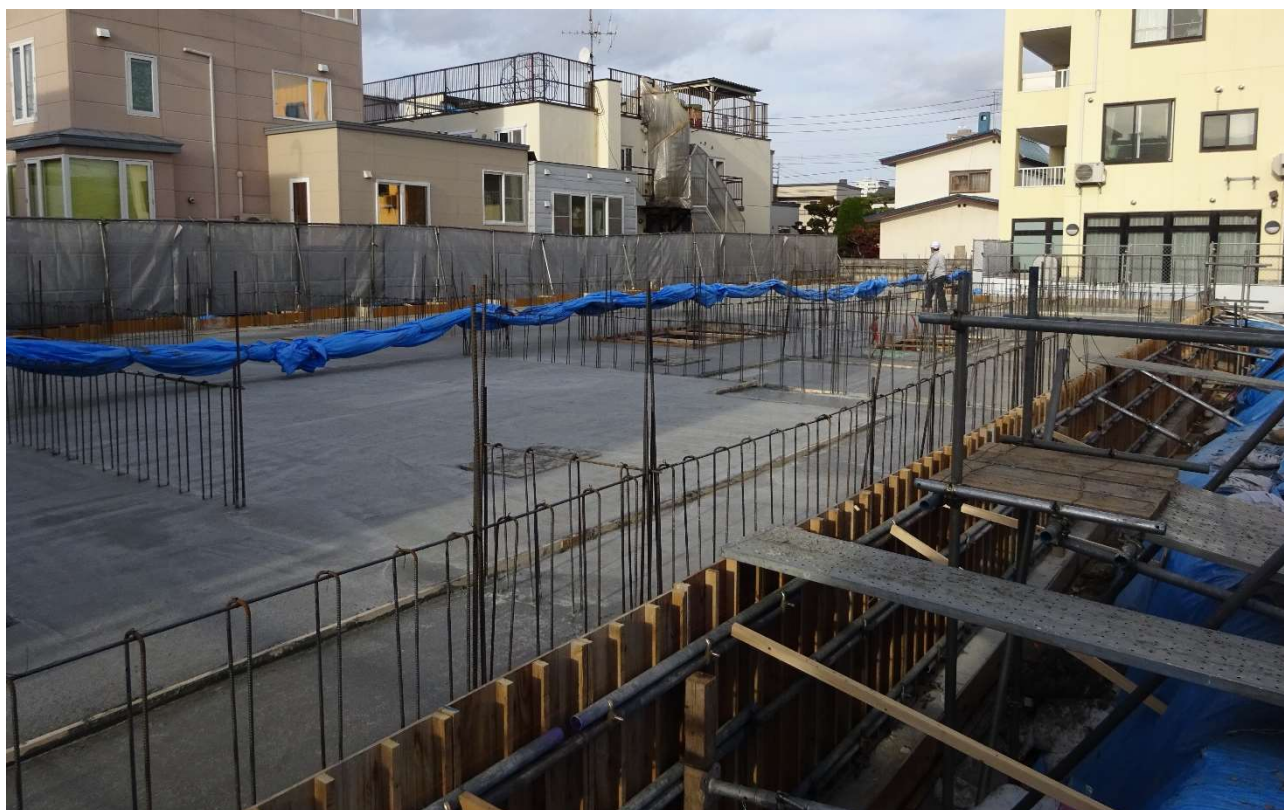
南から見通した1階部（床）です。
