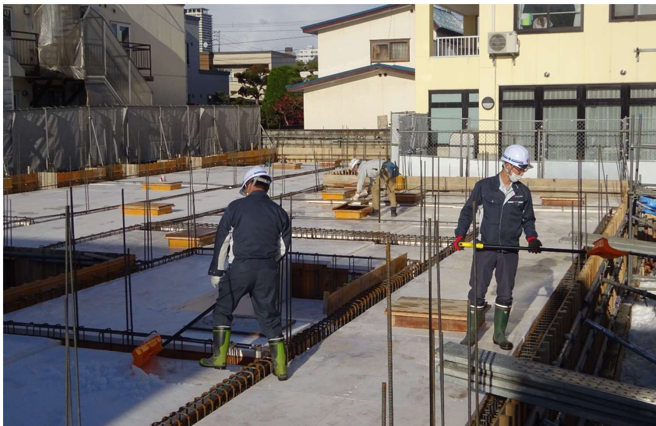
配筋作業等の為の墨出し作業も同時に行われています。
