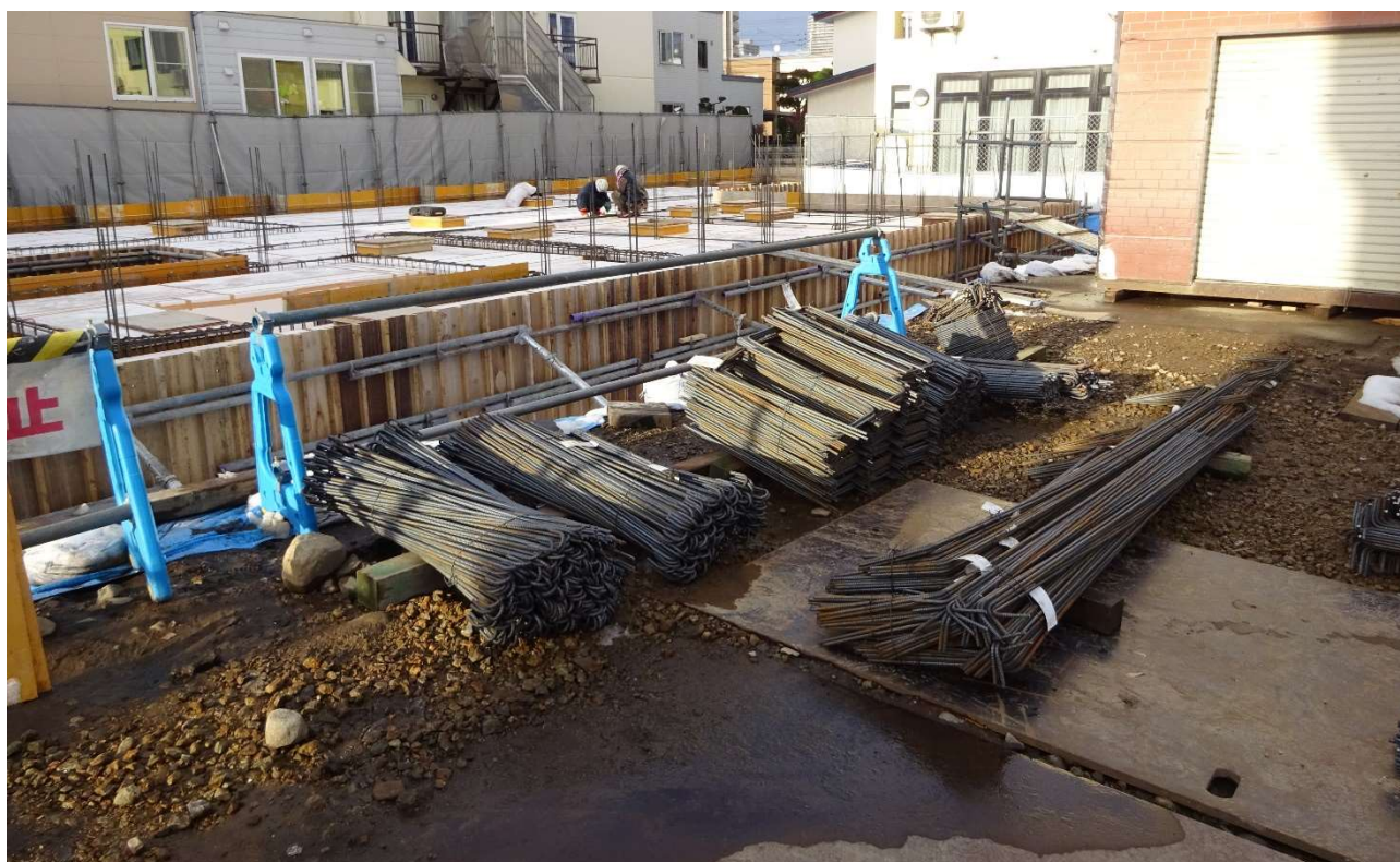
配筋の一部が配達されており、明日から配筋作業が始まります。
