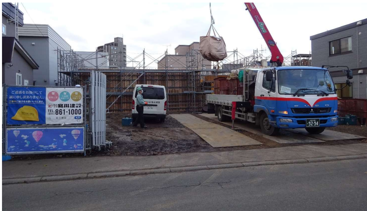
構内を南から撮影しました。1 階の壁用の型枠が設置されています。
