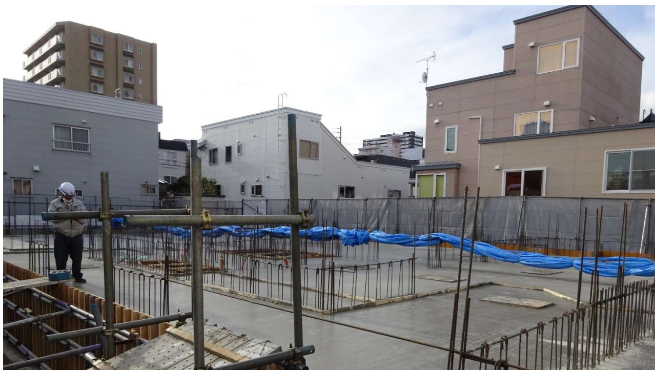
コンクリートの状態を確認しています。
