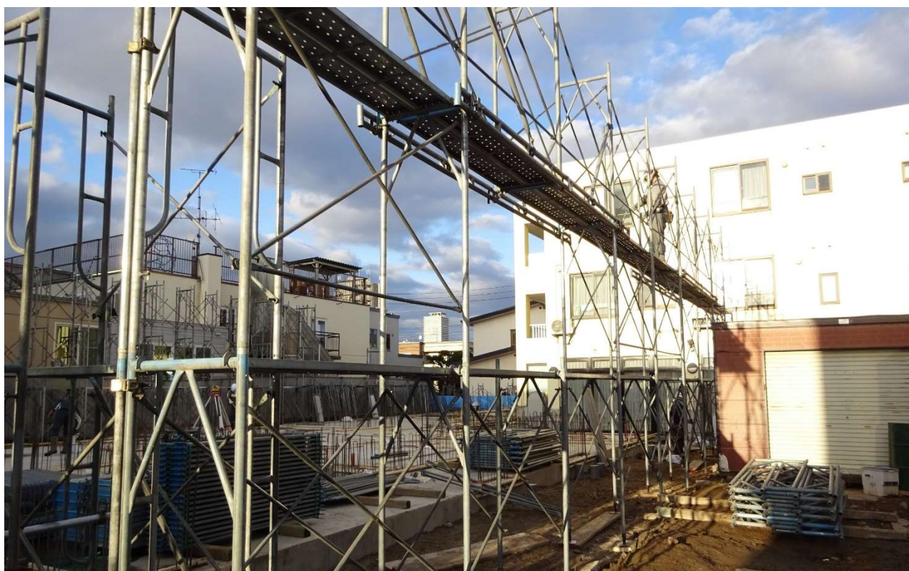
躯体部作成の為に高い足場が組まれていきます。
