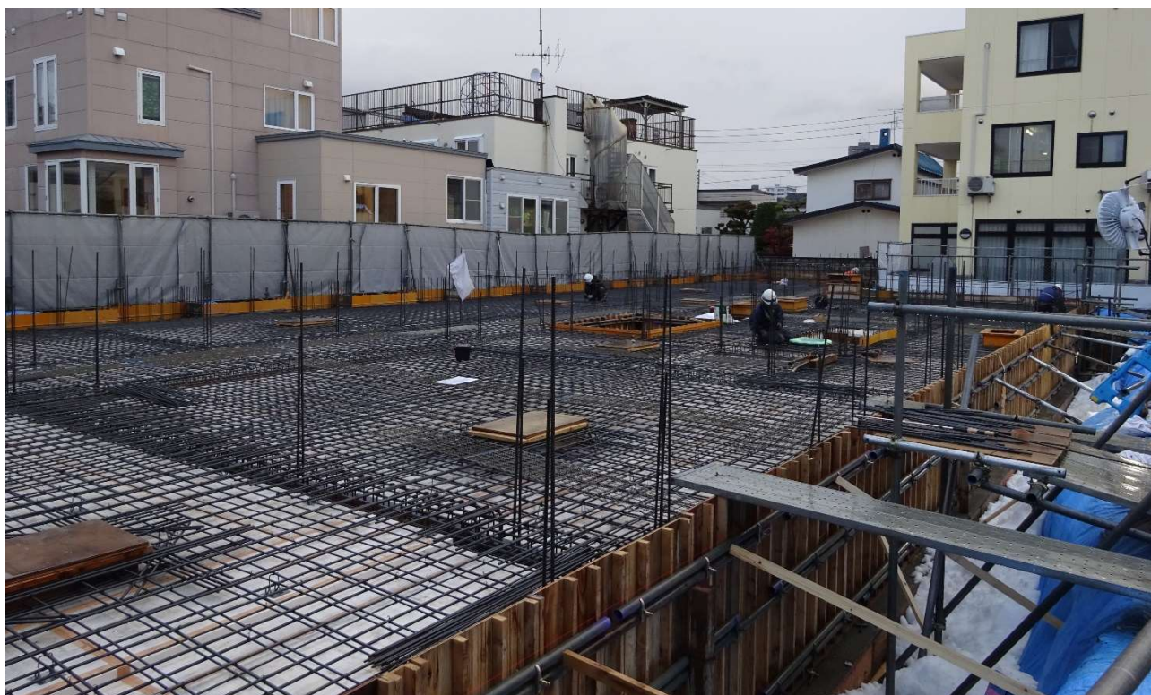
自立ホーム方向を見通した床面に配筋を組んだ状況です。
