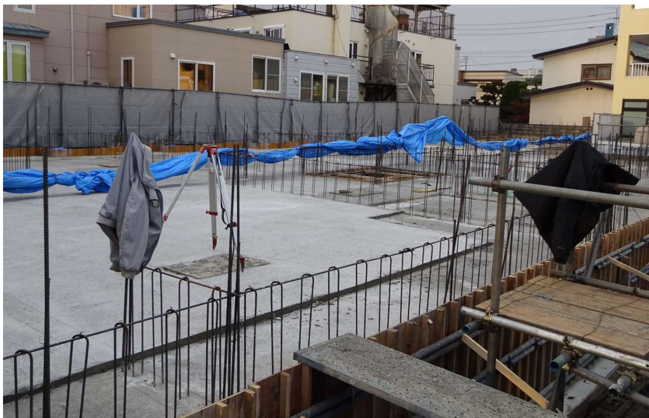
墨出し作業用の機械が配置されています。
