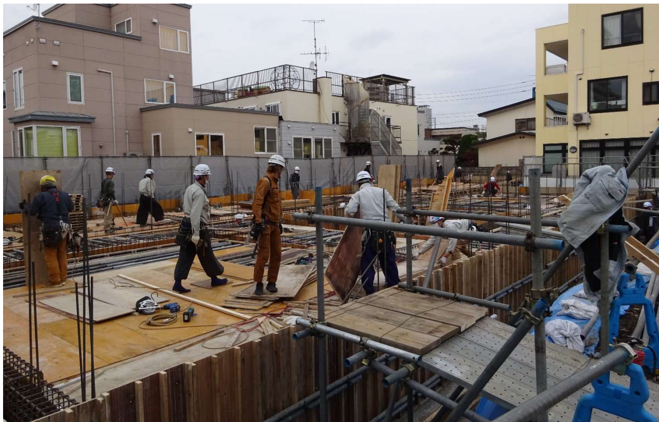
南から見通した型枠作業の状況です。
