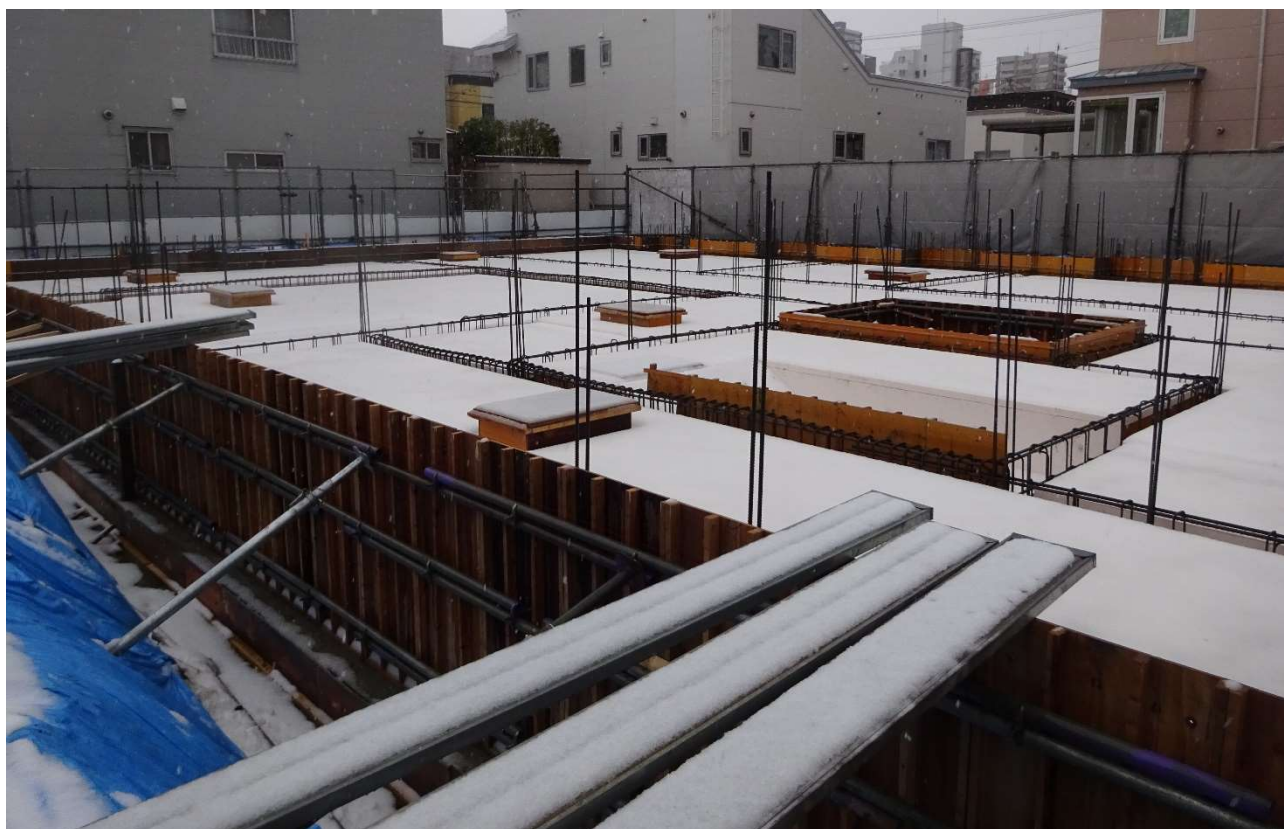
基礎と 1 階床面の高さがわかります。この外側部分は後に埋め戻されます。
