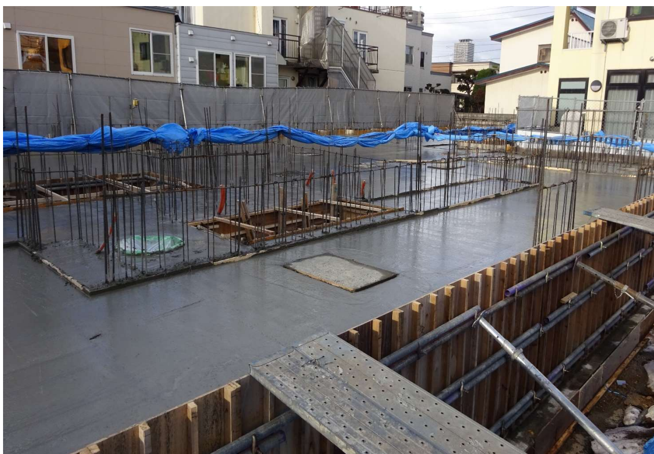
自立ホーム24側は綺麗に仕上がっています。
