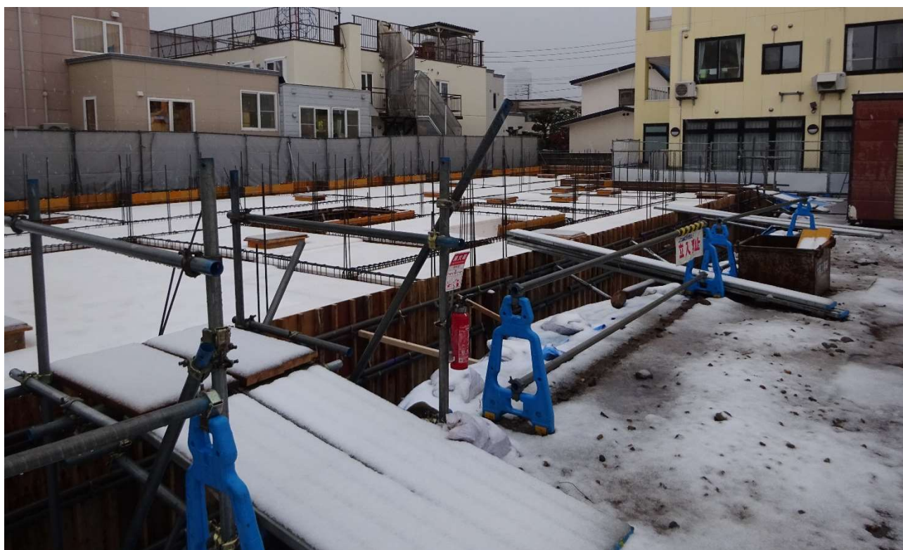
1階床部分に雪が残っており建物の全般的な大きさがわかります。
