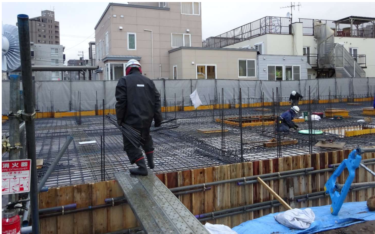
配筋用鉄筋は人力搬送です。
