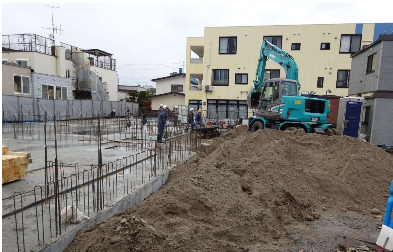
ショベルカーでの埋め戻し作業の状況です。
