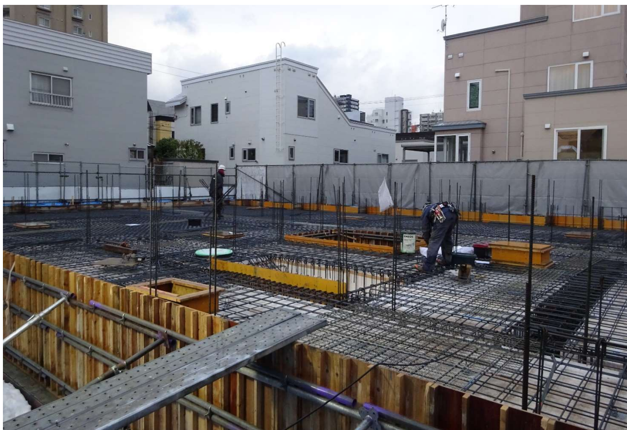
配筋作業等を東側から撮影しました。
