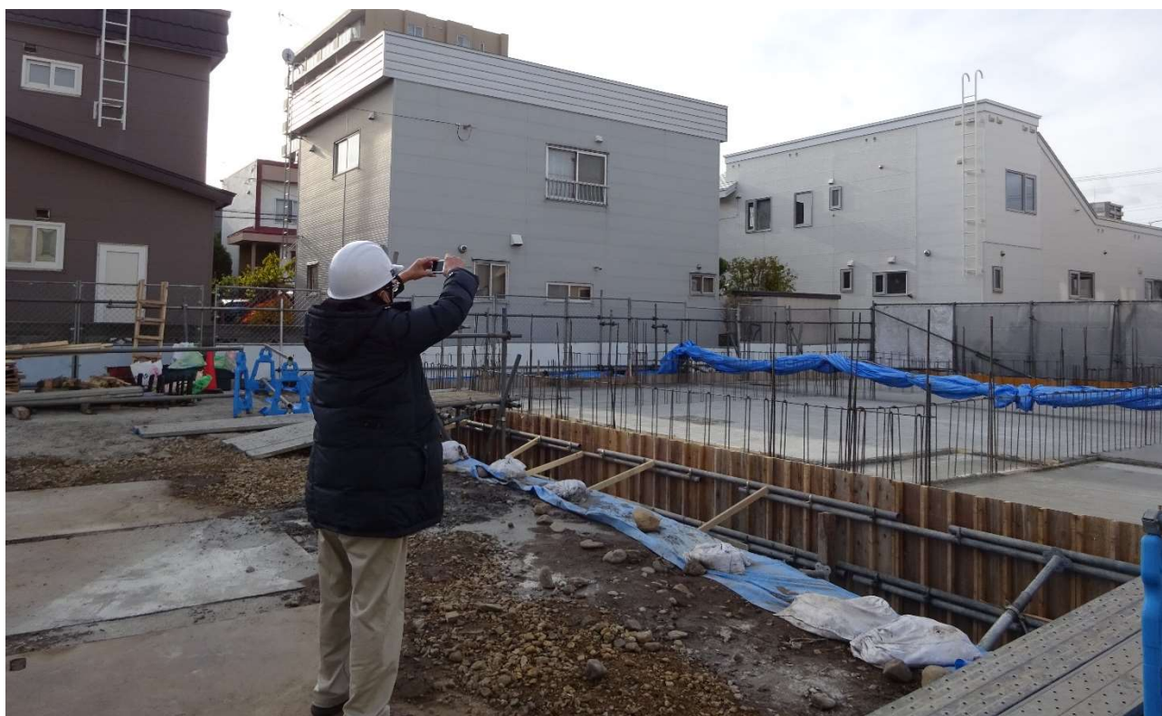
工事構内に入る際は必ず安全帽をかぶります。
