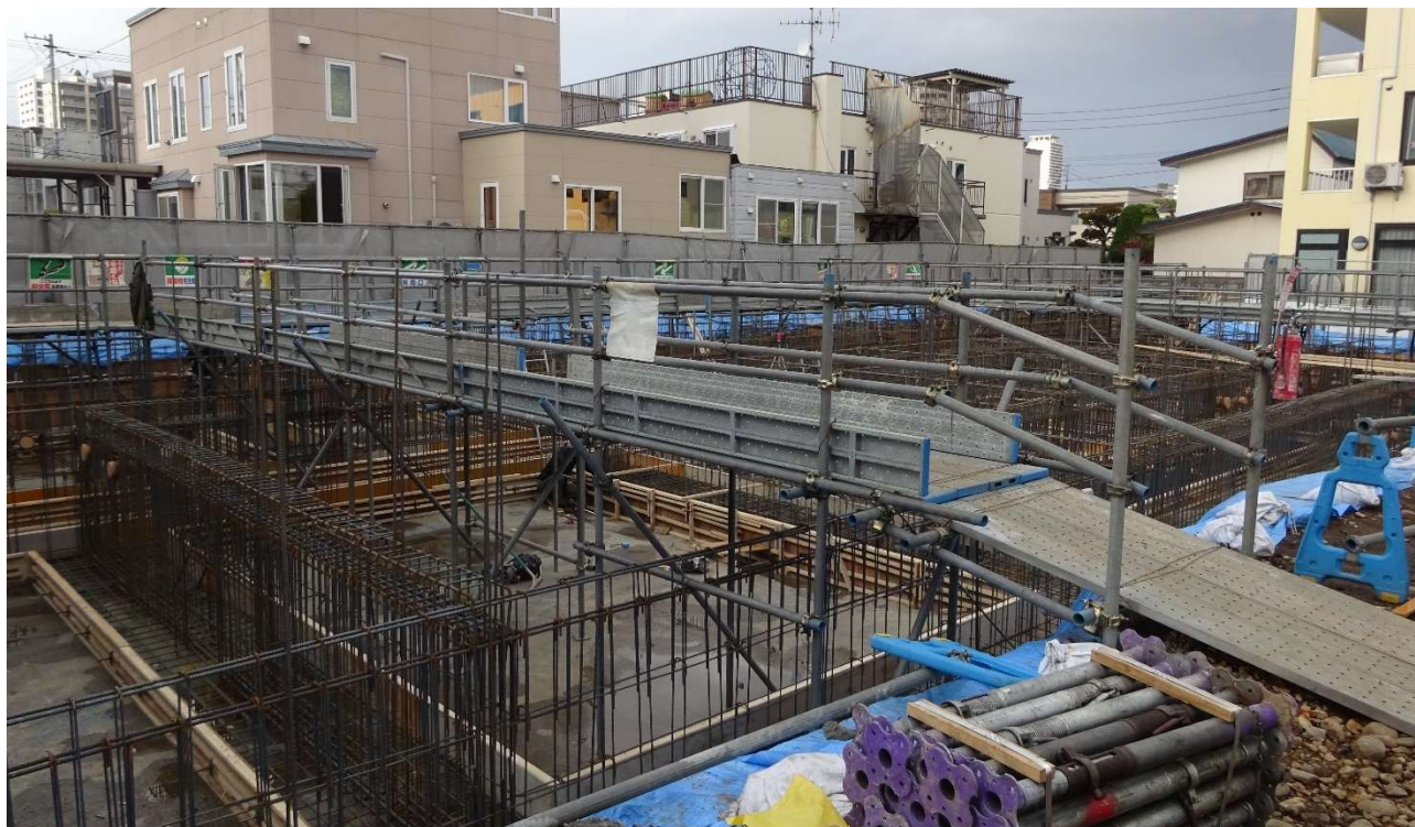
南から見通した型枠作業の状況です。
