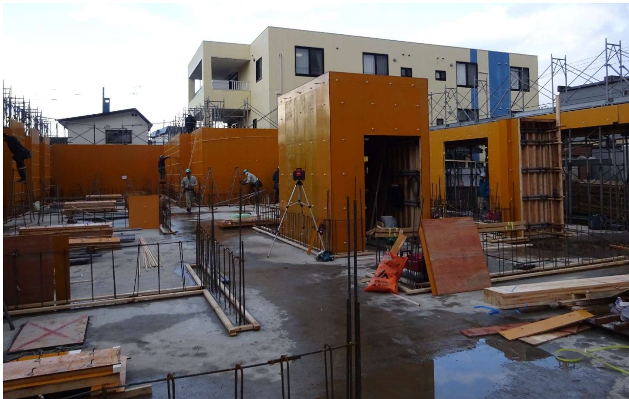
中心部はエレベータの部分です。。
