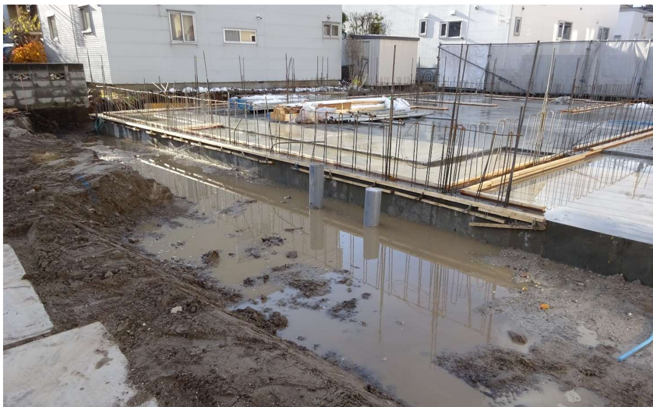
時間をかけて埋戻しを行い、地盤を固めました。
