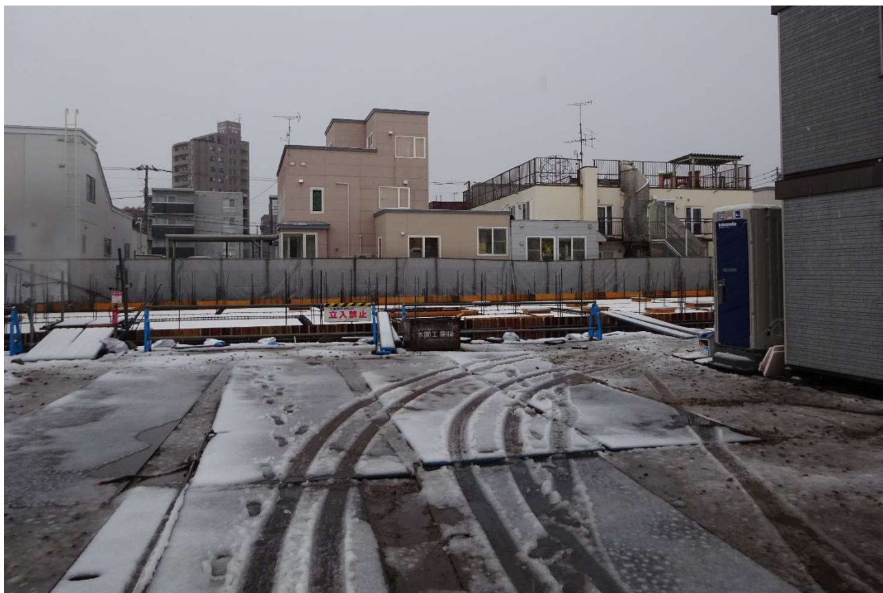
型枠工事が終わった構内全般状況です。
