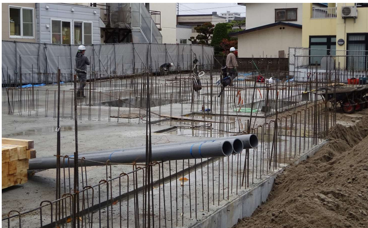
床の部分まで土砂が満たされていきます。
