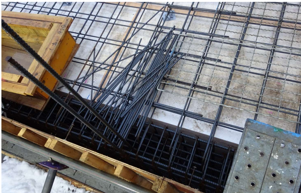
手前基礎部の深いスリットの様子と鉄筋の組立要領がわかります。
