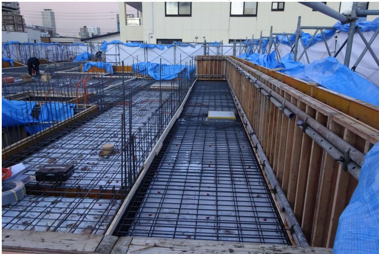
配筋が終了した床です。
