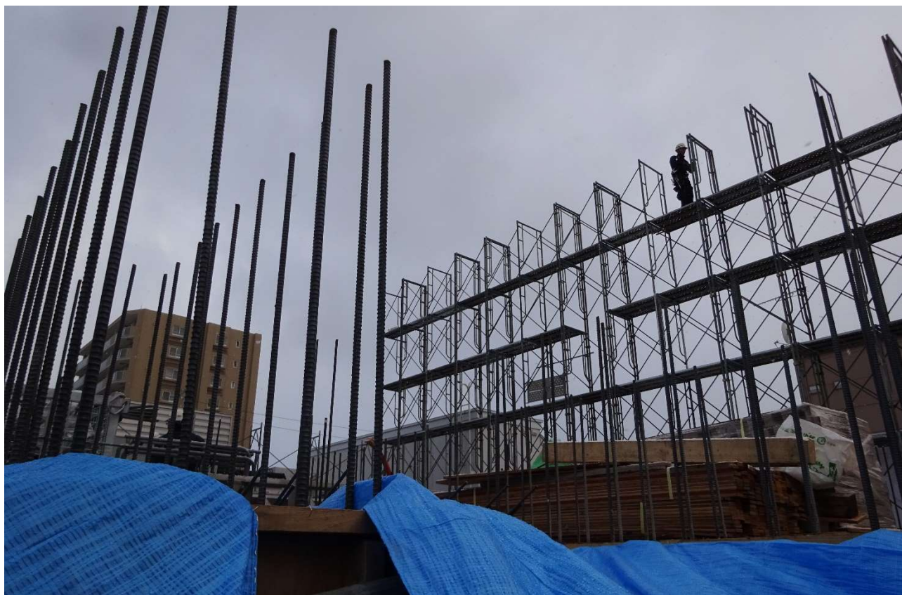
高所での足場組作業です。
