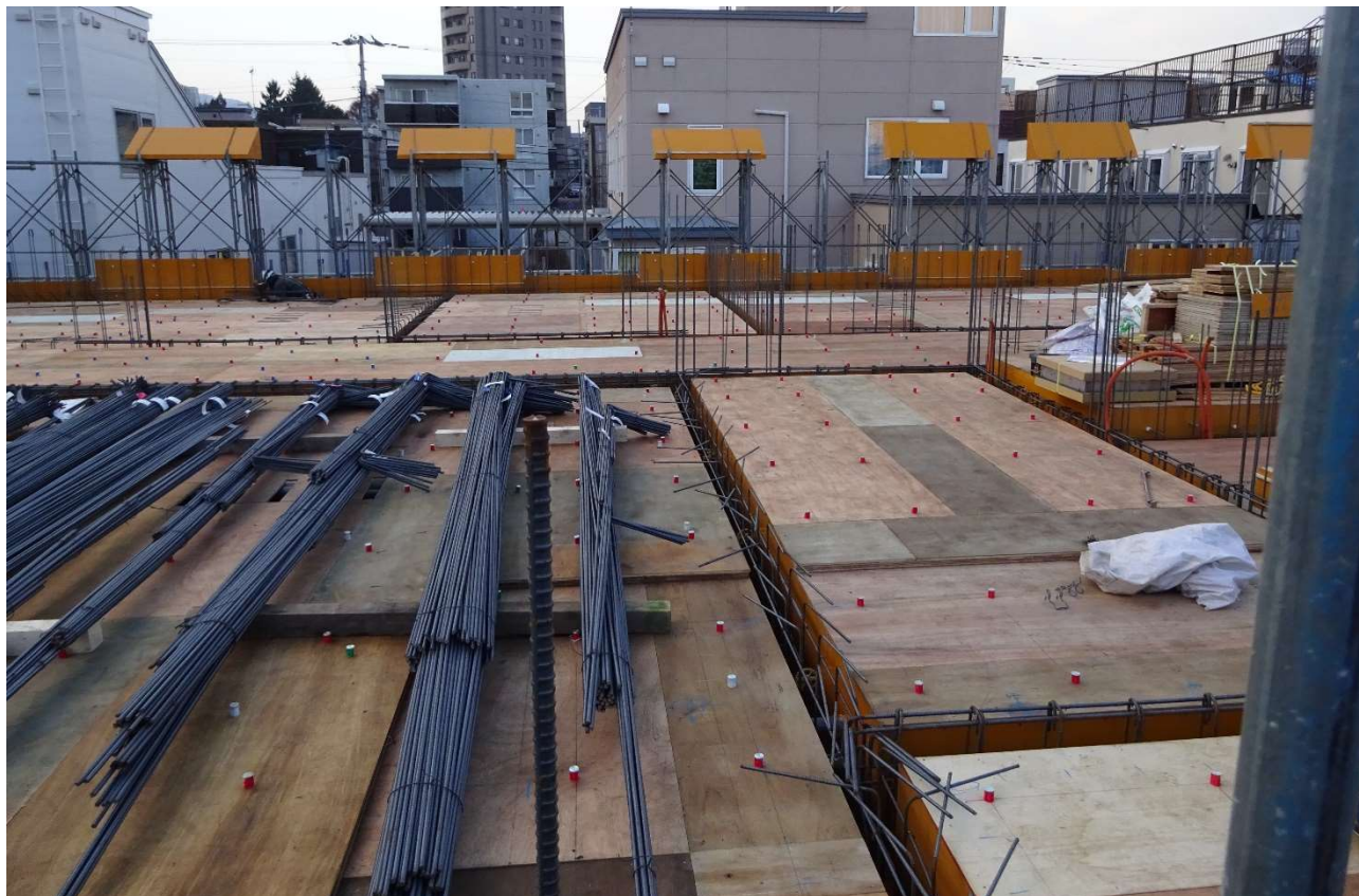
2階床部分に集積された配筋用の鉄筋が確認できます。
