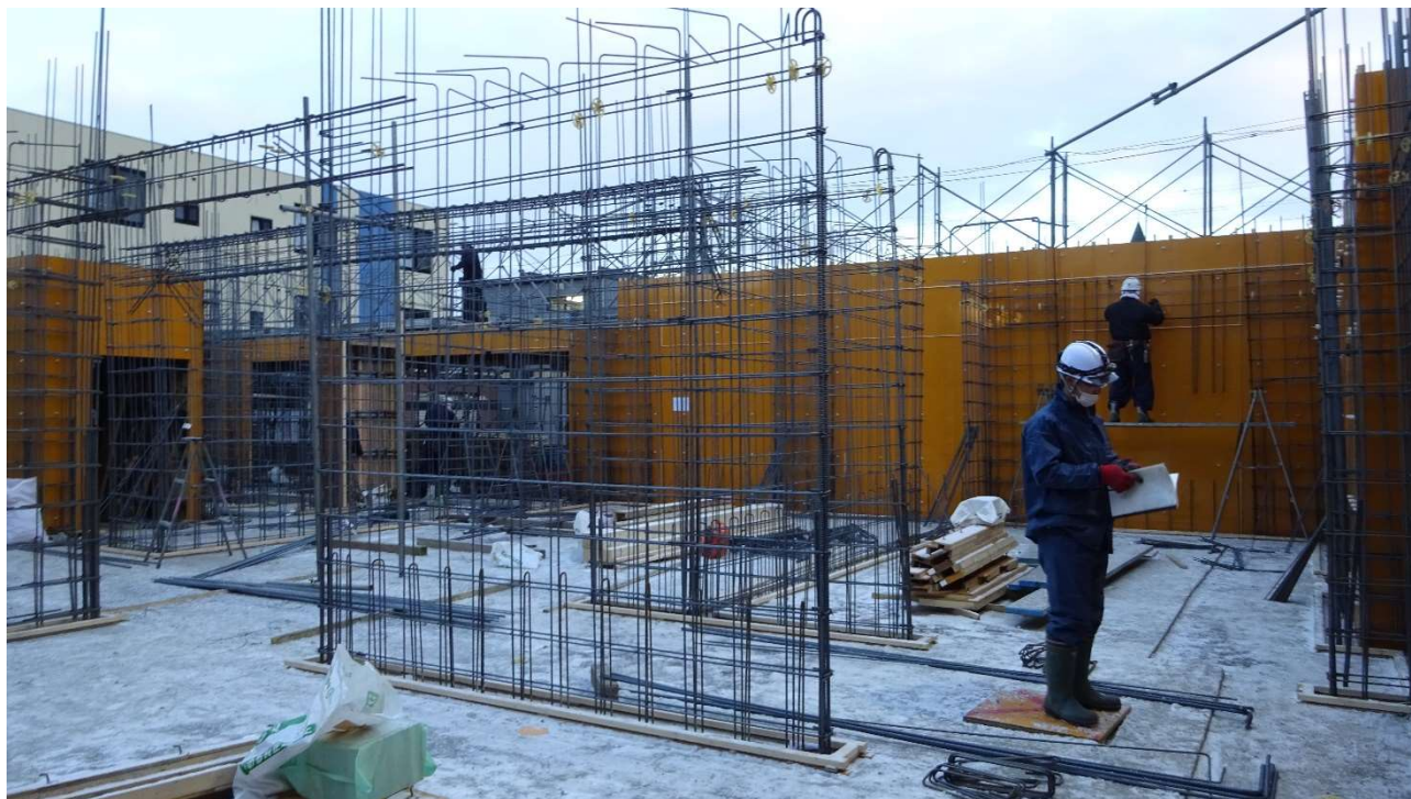
配筋の状態を設計図を基に点検しています。
