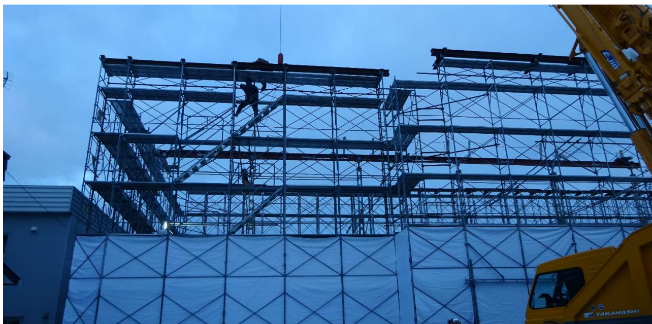
大型クレーンで足場と上屋架けの資材を上げています。
