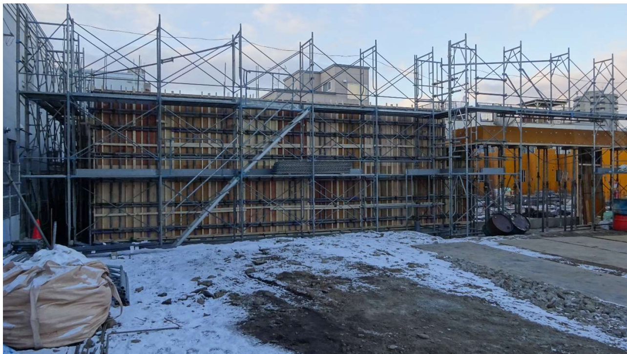
構内を南側から撮影しました。1階の壁用の型枠が設置されています。
