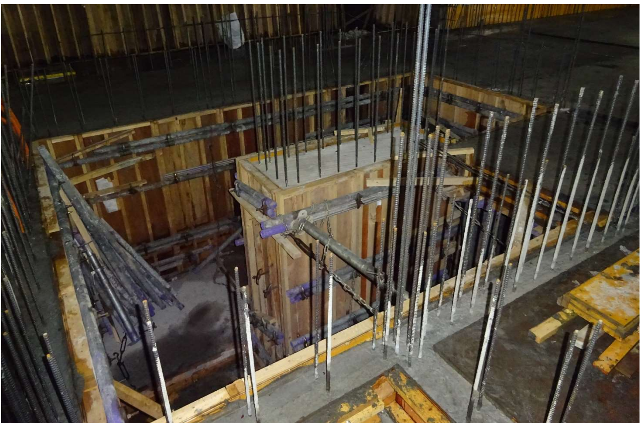
階段室の状況です。
