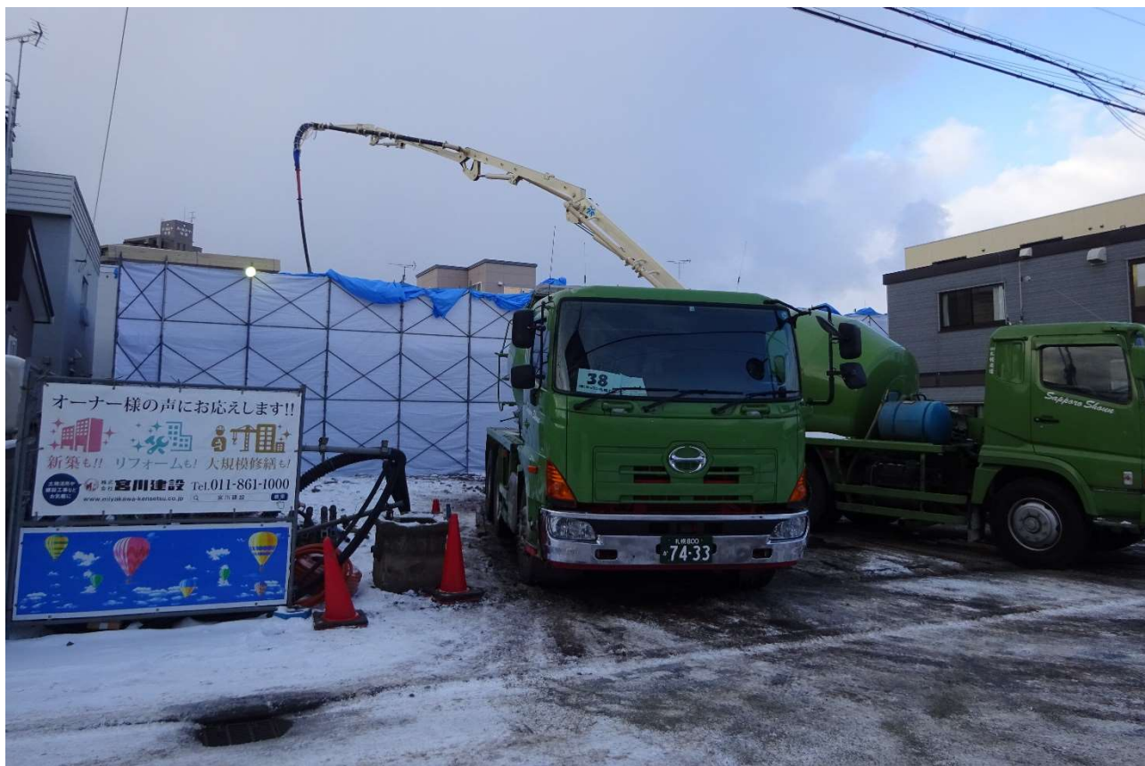
ミキサー車が次々と生コンクリートを運んできます。
