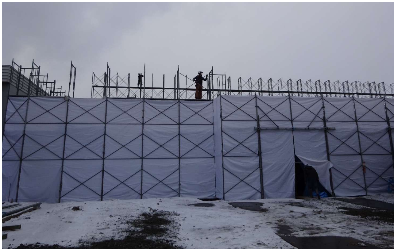
建物の白い幕の上部に足場を組んでいます。
