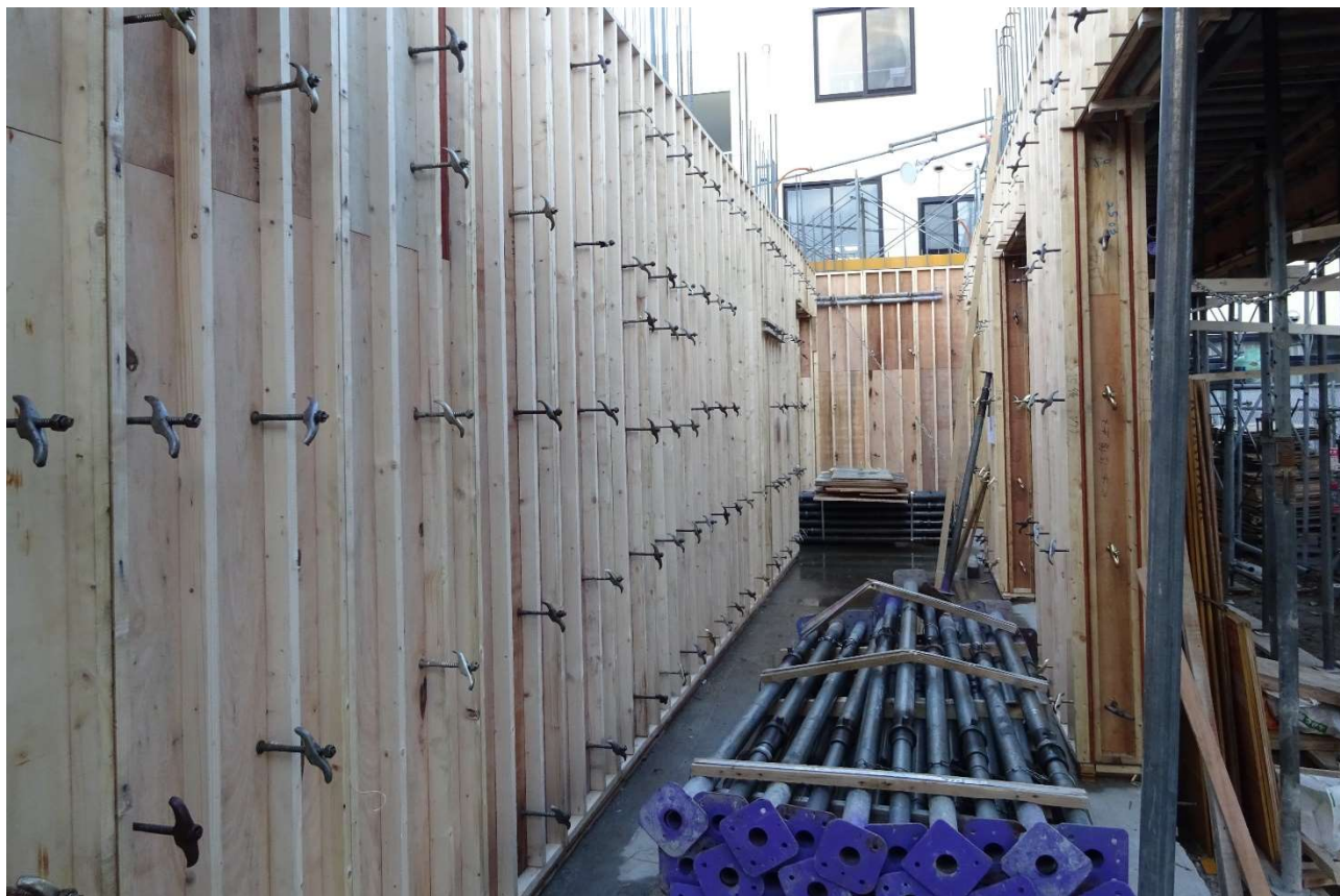
建物の中心を走る廊下の型枠の状況です。
