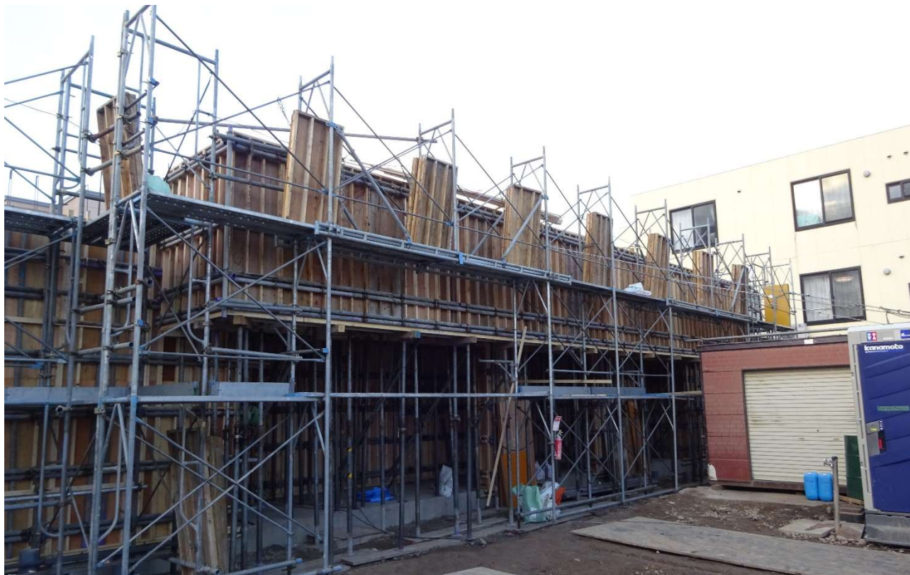
1階部分の壁外枠を南方向から撮影しました。
