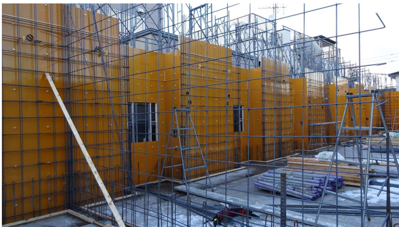
北側の個室の壁（出窓）の形状が確認できます。
