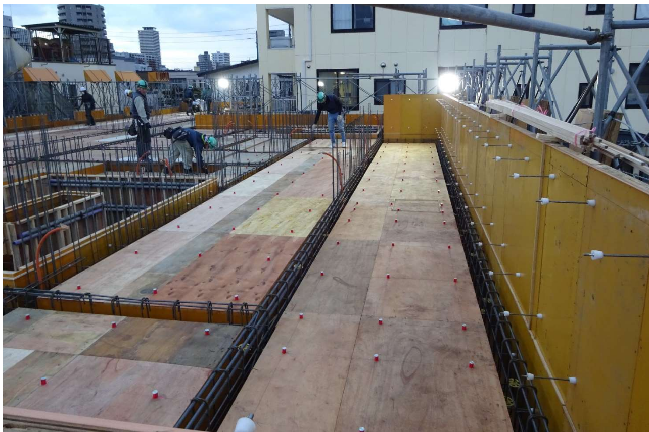
スラブの状況が良く確認できます。
