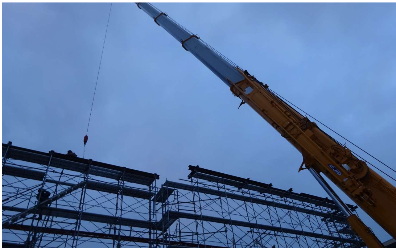
クレーンで丁寧に上部へ資材を移動させています。
