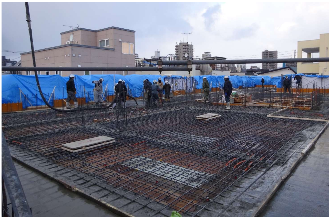
2階床の部分にコンクリートを打設している状況です。
