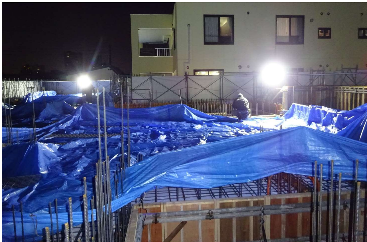
建物上部は降雪対策として青いシートで覆います。
