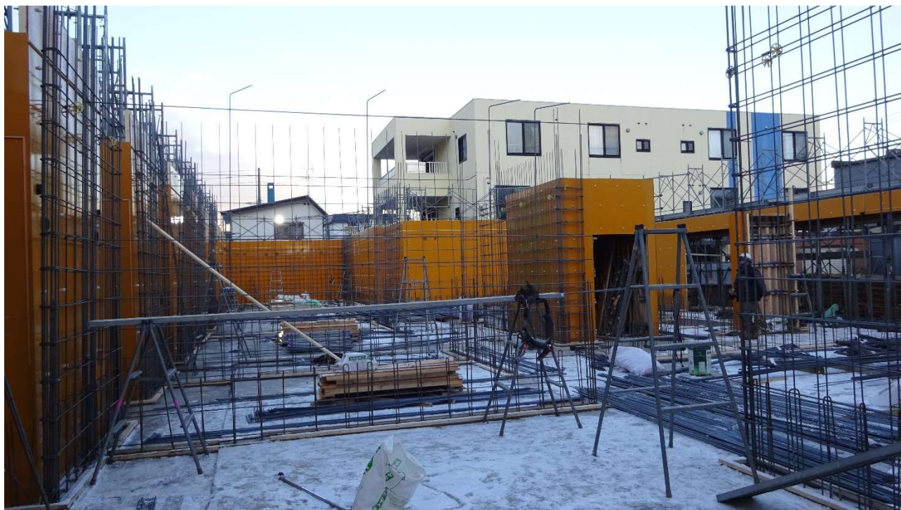
中心部はエレベータの部分です。建物内の区画にも鉄筋が組まれています。
