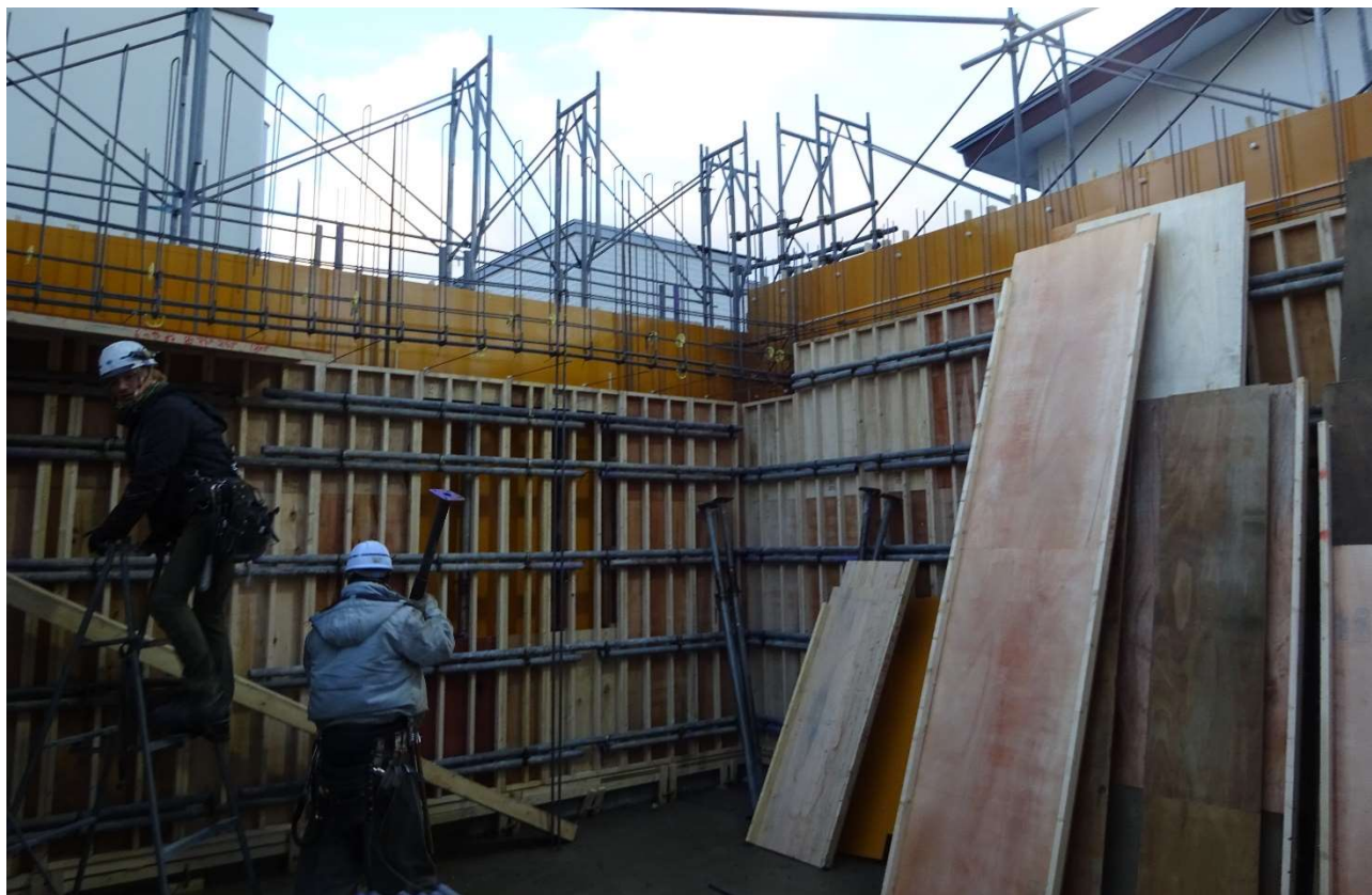
床材を渡すために壁上部の淵を作成しています。
