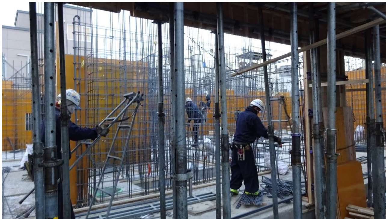
20名程にて鉄筋配筋工事を行っています。
