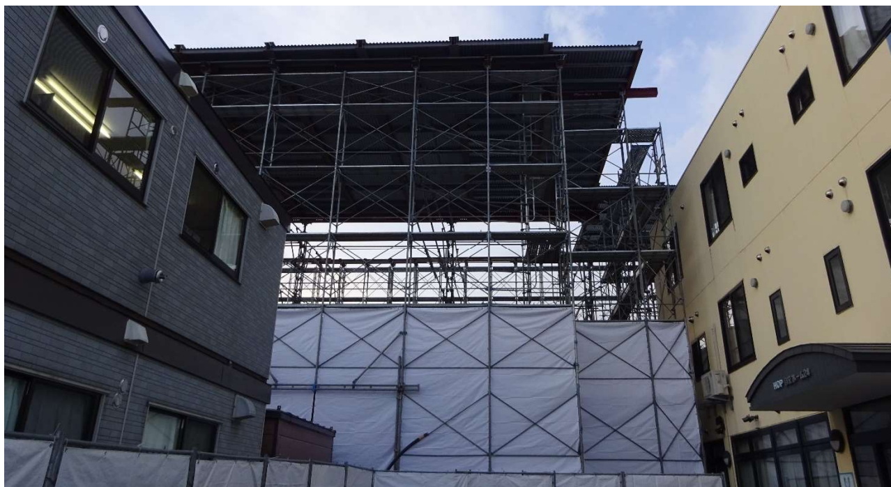
クレーンで資材を上げて屋根を構成しています。
