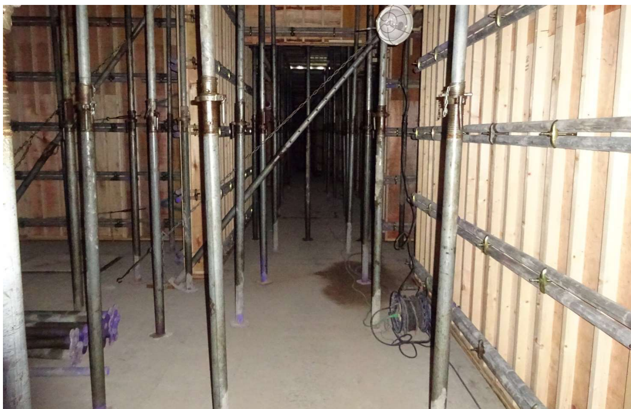
床の部分は綺麗に清掃されています。
