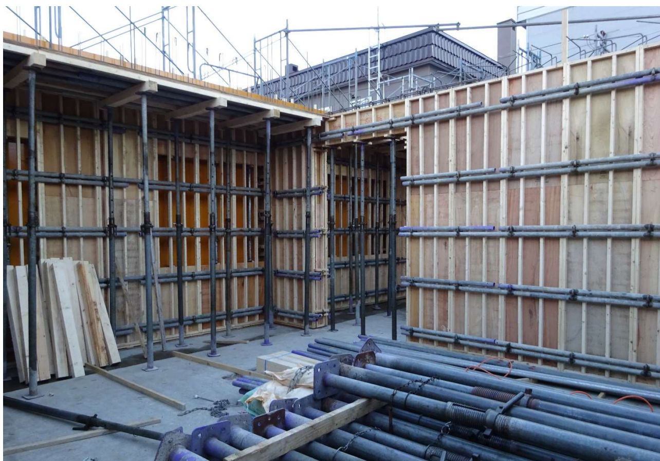
スラブをパイプで支えています。
