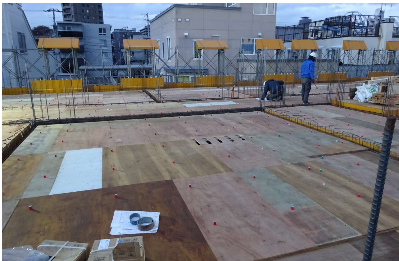
スリーブ等の配置が一部行われています。
