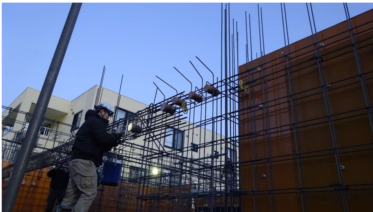
ライトの明かりでスリーブを配筋に取り付けます。
