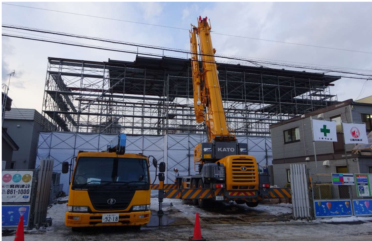
作業の状況が確認できます。
