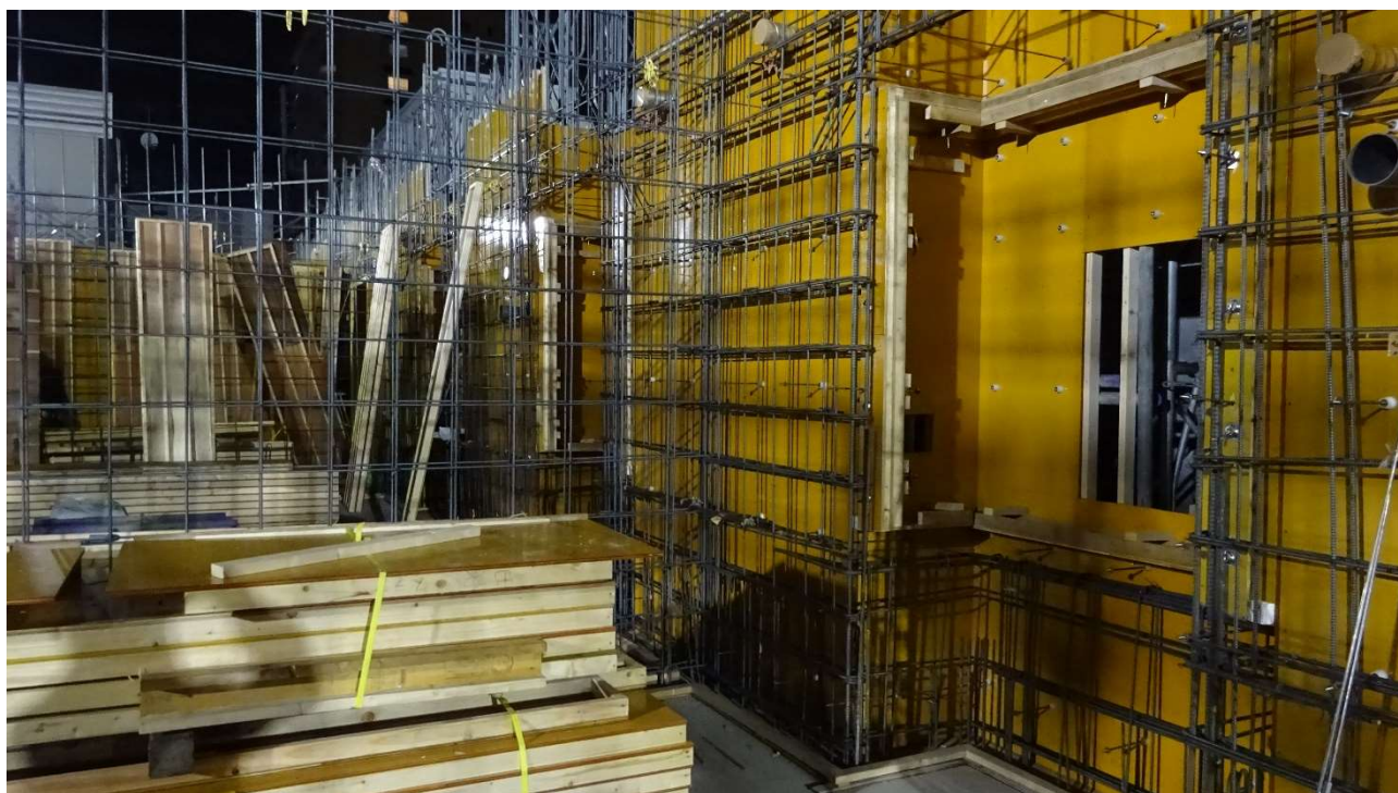
壁の内枠を取り付ける場所です。
