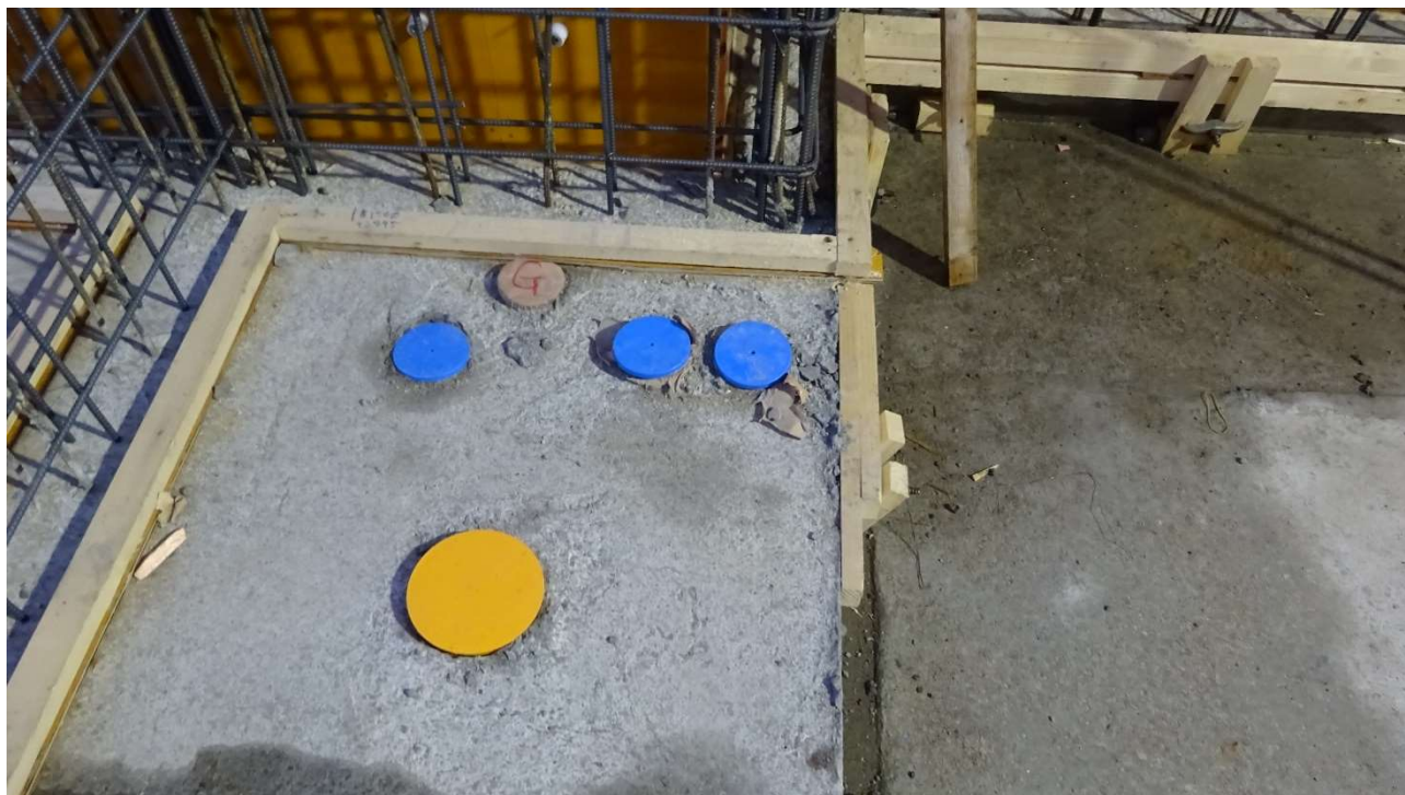
床に設けられたスリーブを覆う蓋です。
