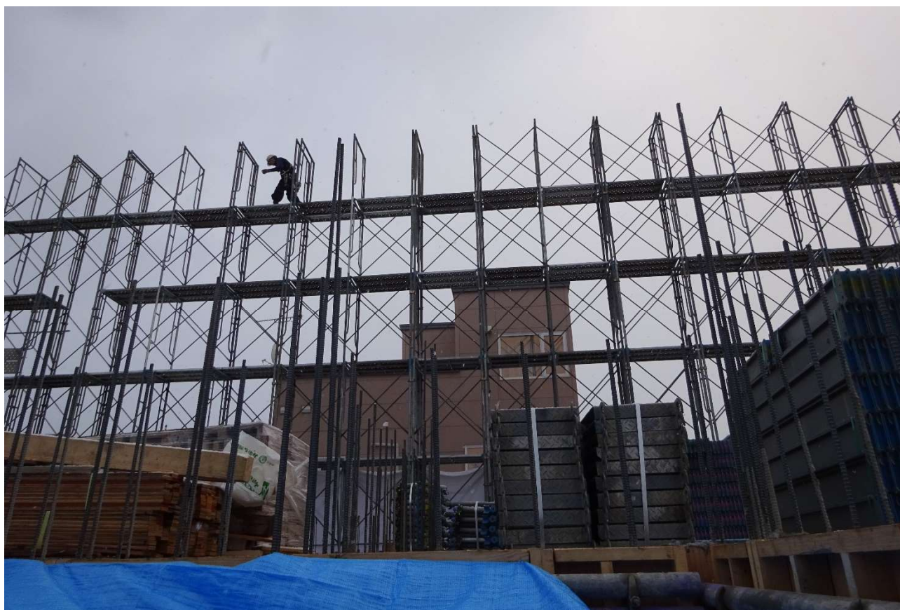
南東から高所作業を撮影しました。
