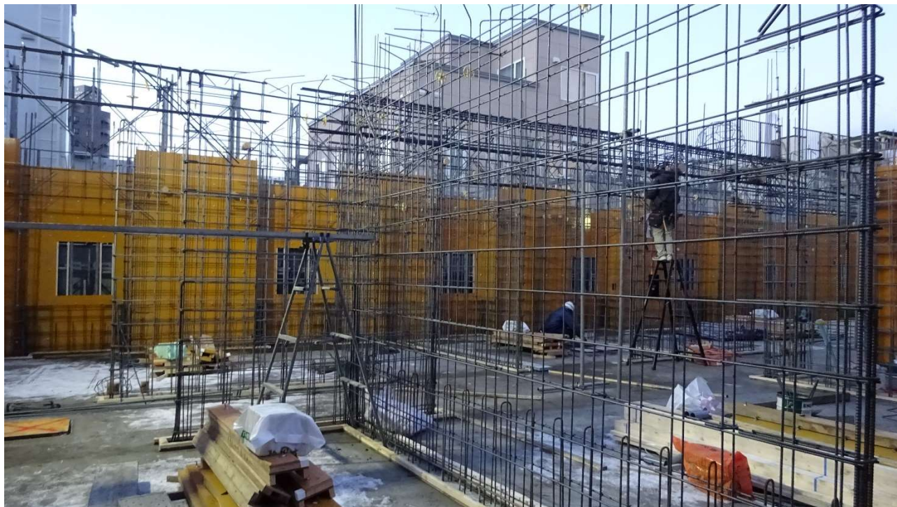
南からの撮影です、組み終わった配筋から鉄筋の多さが理解できます。
