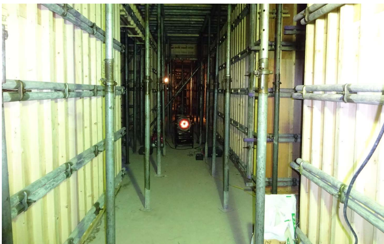
1階の廊下部分にはジェットヒーターが数台配置され建物内の保温をしています。
