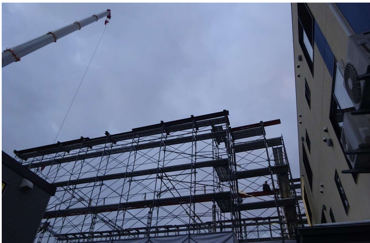
作業の状況が確認できます。
