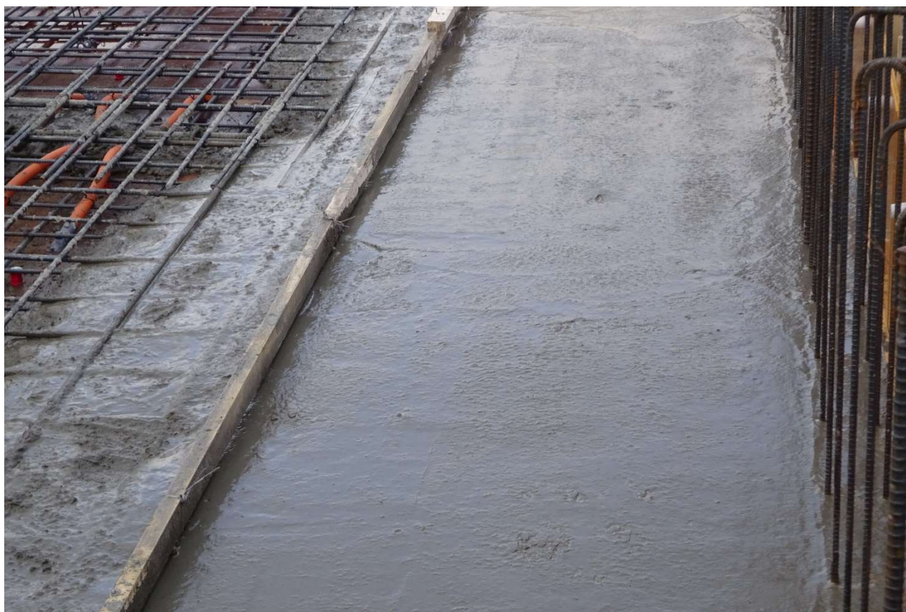
外壁部型枠内に打設された大量のコンクリートです。
