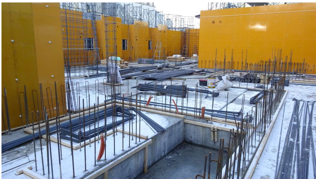
大量の鉄筋が運搬されています。
