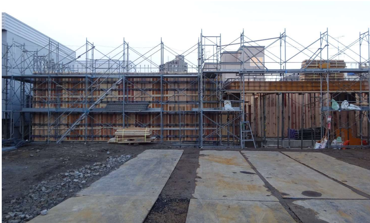
1階型枠作業が終了した構内全体の状況です。
