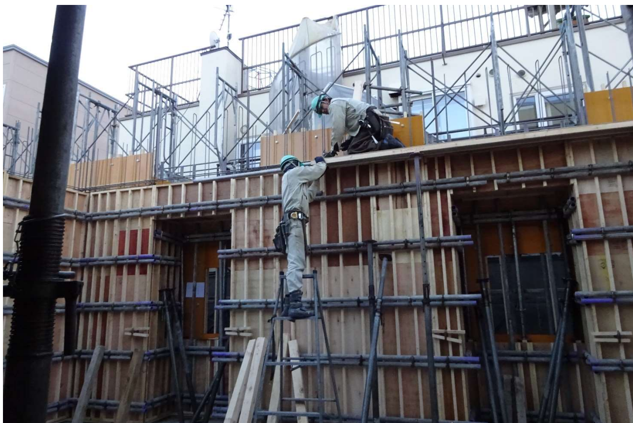
様々な場所で組みになって作業しています。
