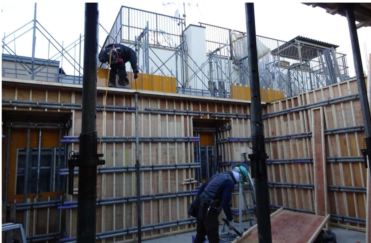
型2階床に型枠板を正確に敷きつめる為に下で加工します。
