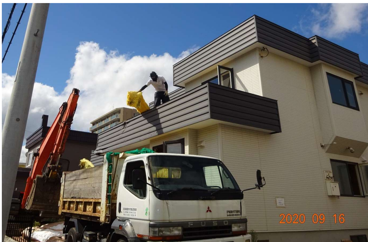
グラスウール排出は手作業にて行われています。
