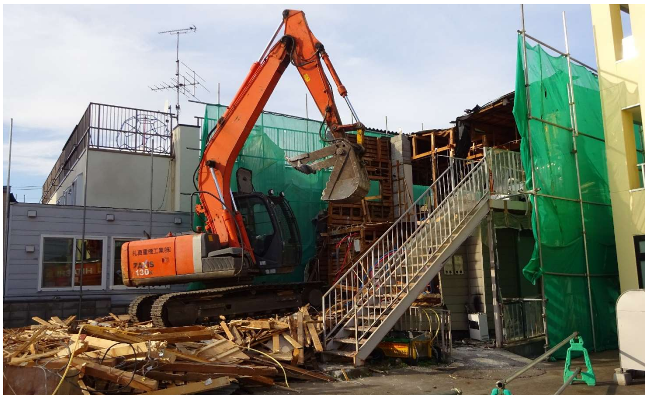
両サイドの隣家に注意を払いながら、ゆうあい施設解体の状況です。
