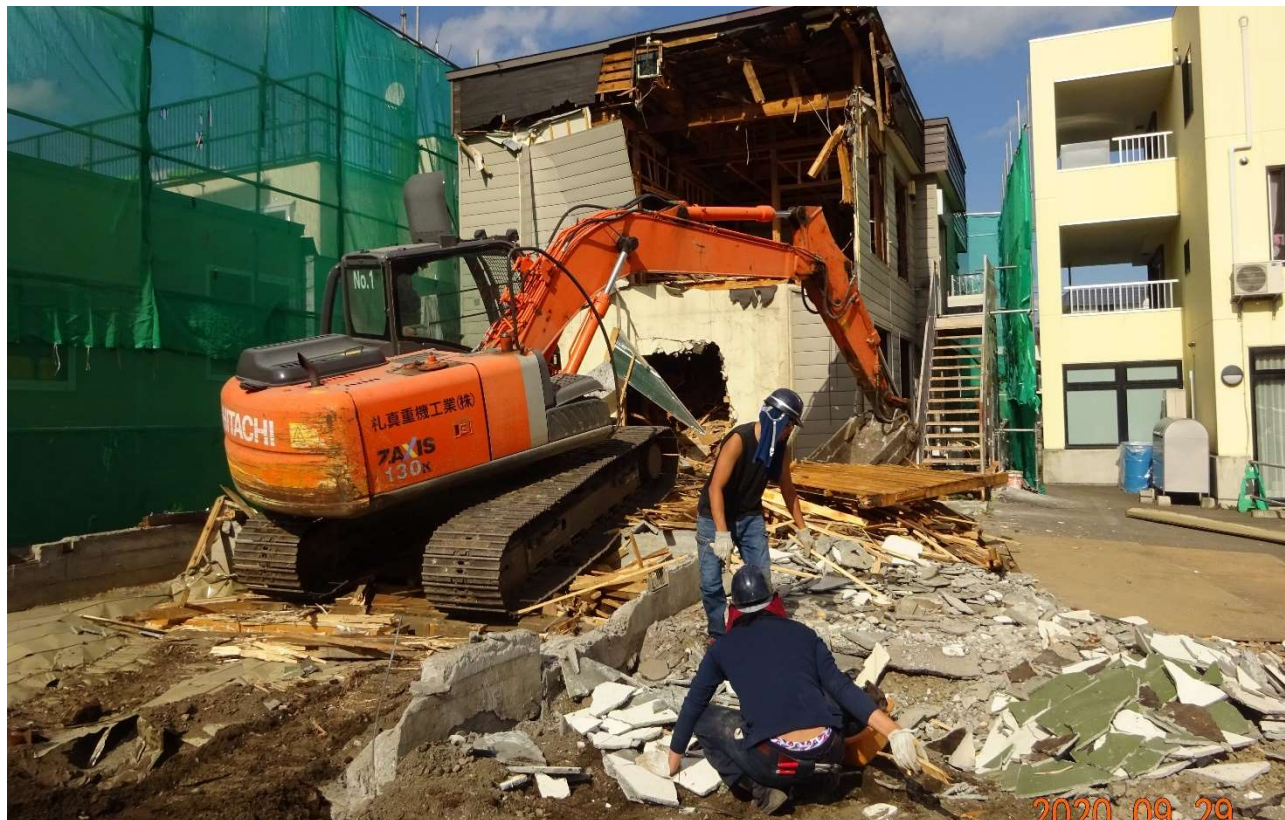
取り壊した瓦礫の中から、分別指定物は手作業で分別しています。
