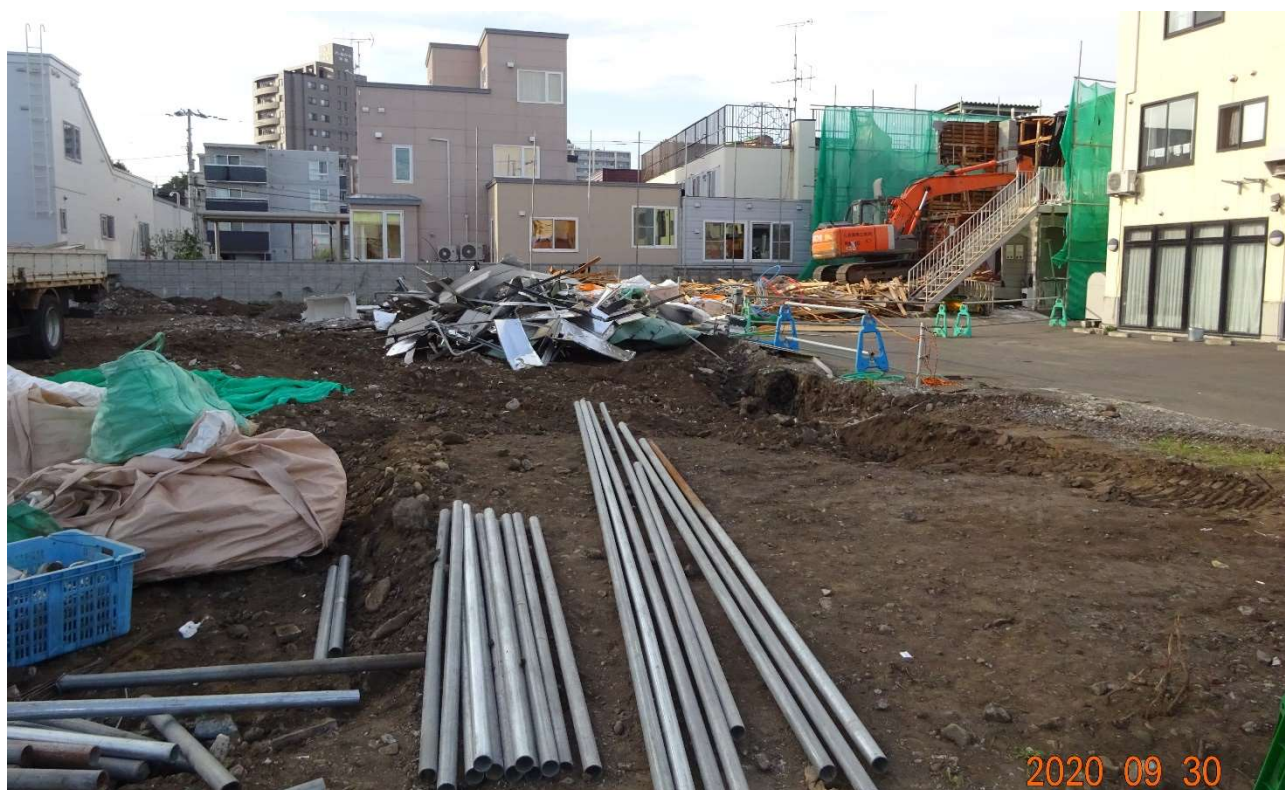
解体跡に分別された金属片と瓦礫等の状況です。
