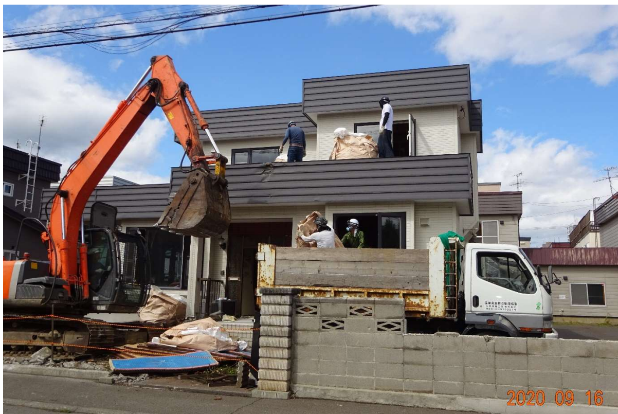
ショベルカー1台とダンプカーにより解体を開始しました。
