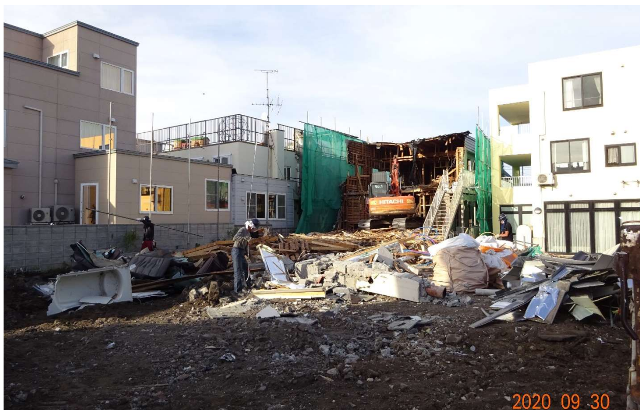
ゆうあい施設の解体状況です。
