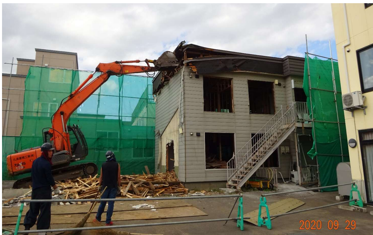
ゆうあい施設が、ショベルカーにより、解体されています。
