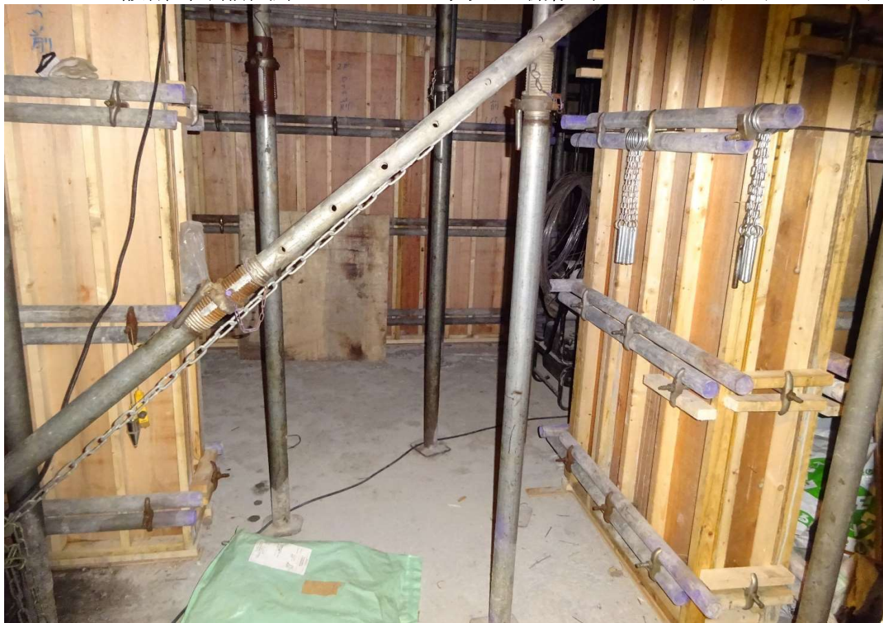
2階の壁柱の型枠施行の状況です。
