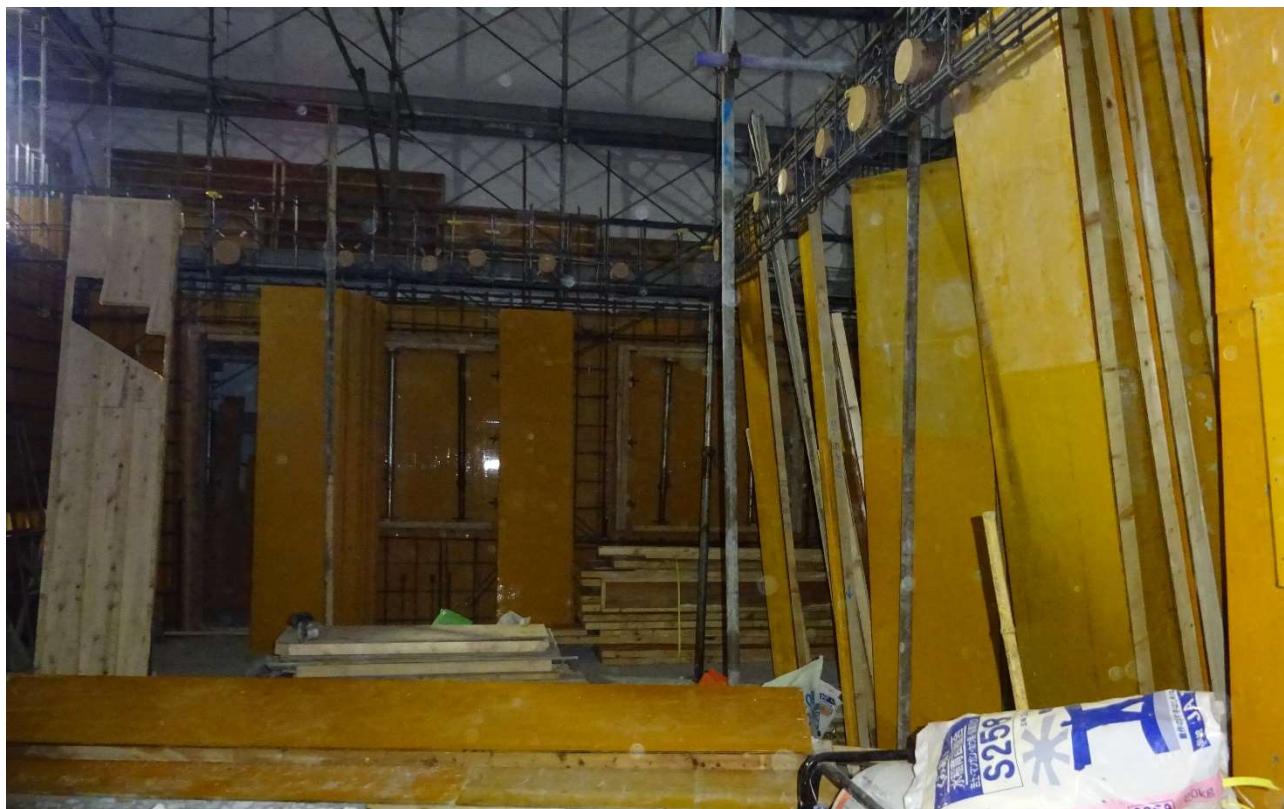
内側の型枠が並べられています。
