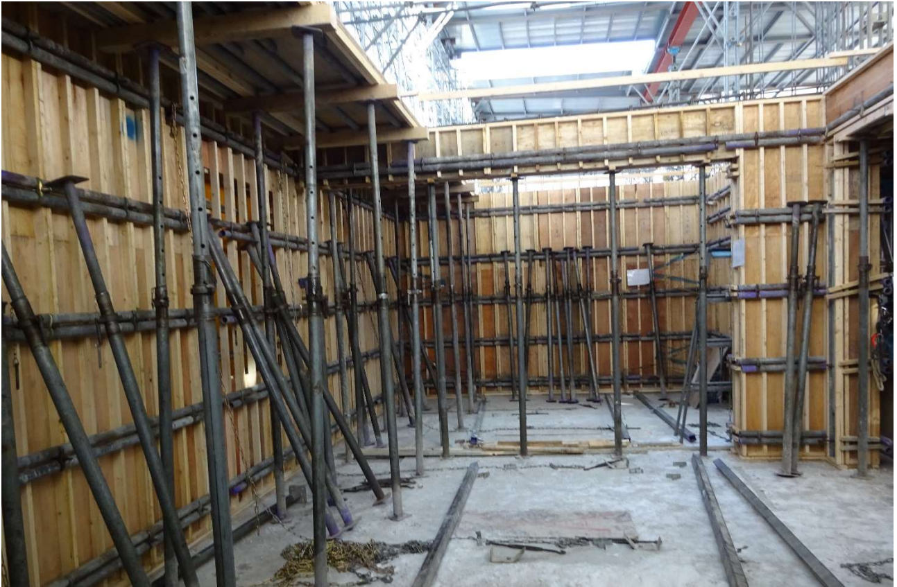
2階天井部に角材がかけられています。
