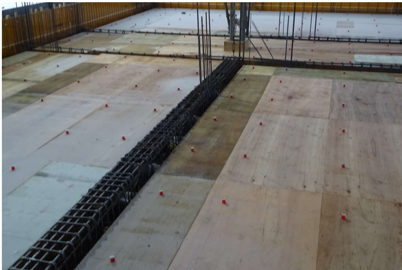
縦に走る鉄筋の中にも、生コンクリートが流れ込んで壁が出来ます。
