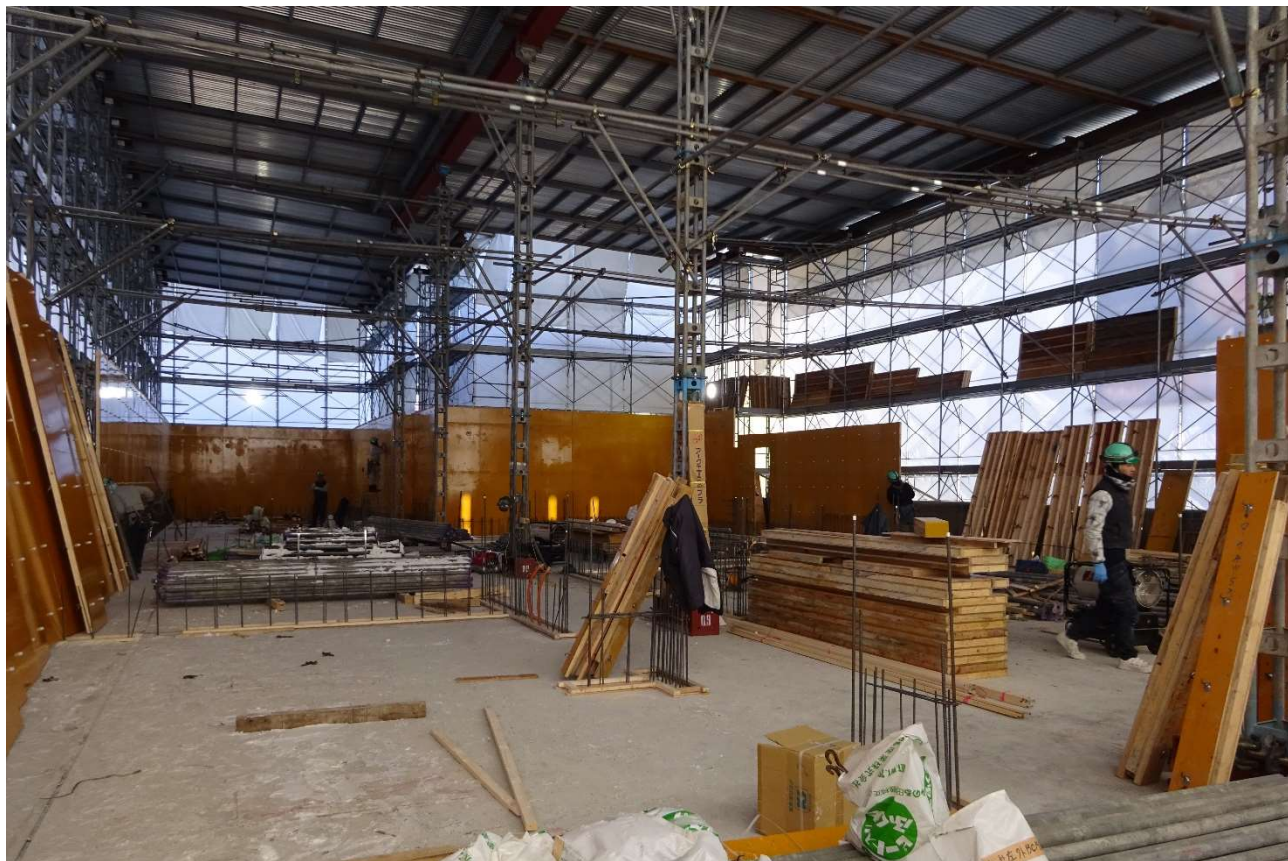
型枠作業の状態が確認できます。
