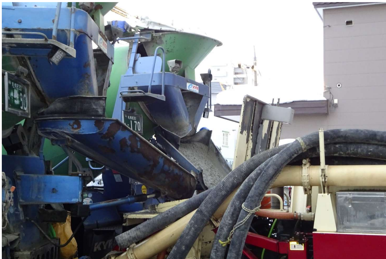
生コンクリートを補給しています。
