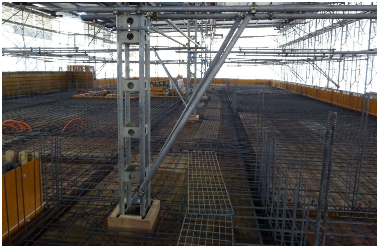
配筋の上に足場用の網が置かれています。
