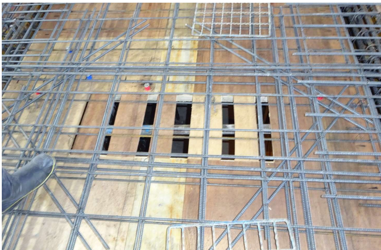
3階壁の型枠等を搬入する為のロットが設けられています。
