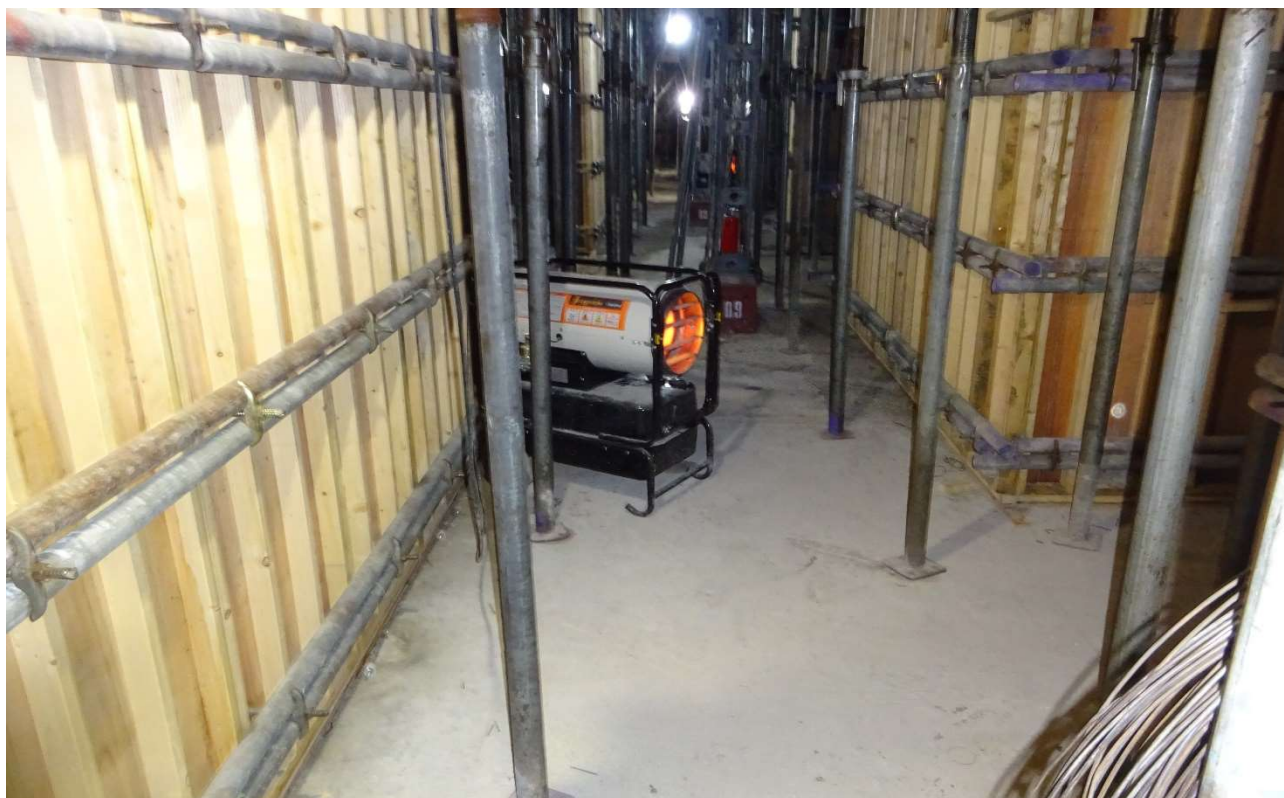
2階の廊下部分はジェットヒーターが複数配置されています。
