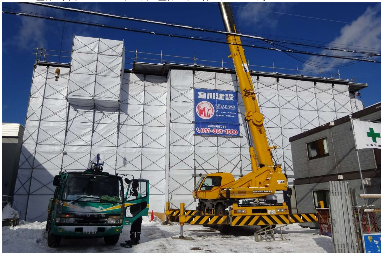
建築現場正面からの撮影です。型枠材の搬入が行われました。
