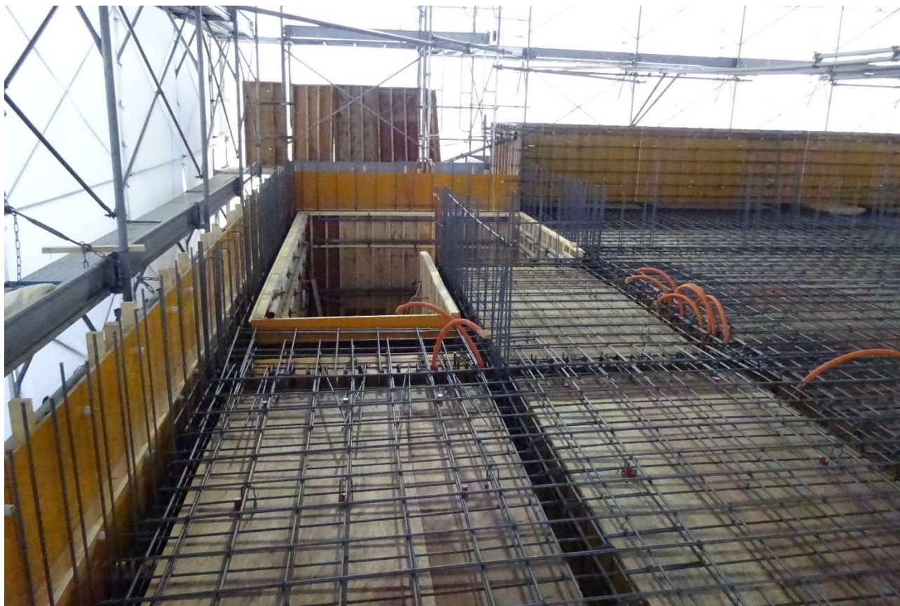
階段室付近の配筋の状況です。
