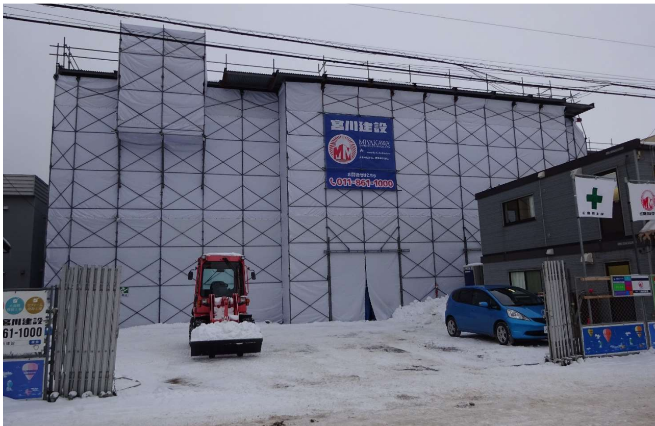
幕の上部の雪を丁寧に払い明日からの工事に備えます。
