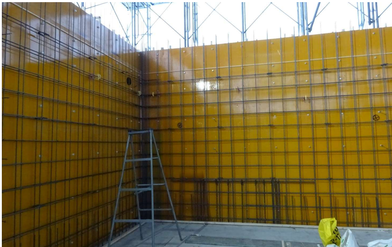
非常に高い配筋作業です。
