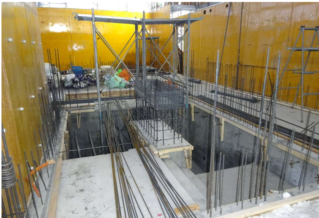
階段室の配筋の状況です。
