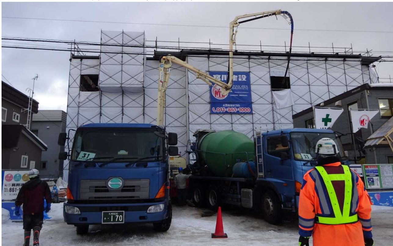
打設間はミキサー車が絶え間なく生コンを補給しています。
