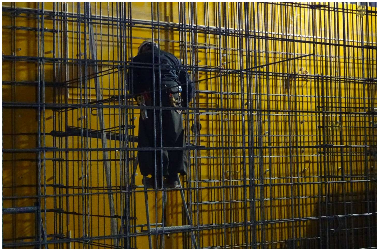
建物内部の配筋が進んでいます。
