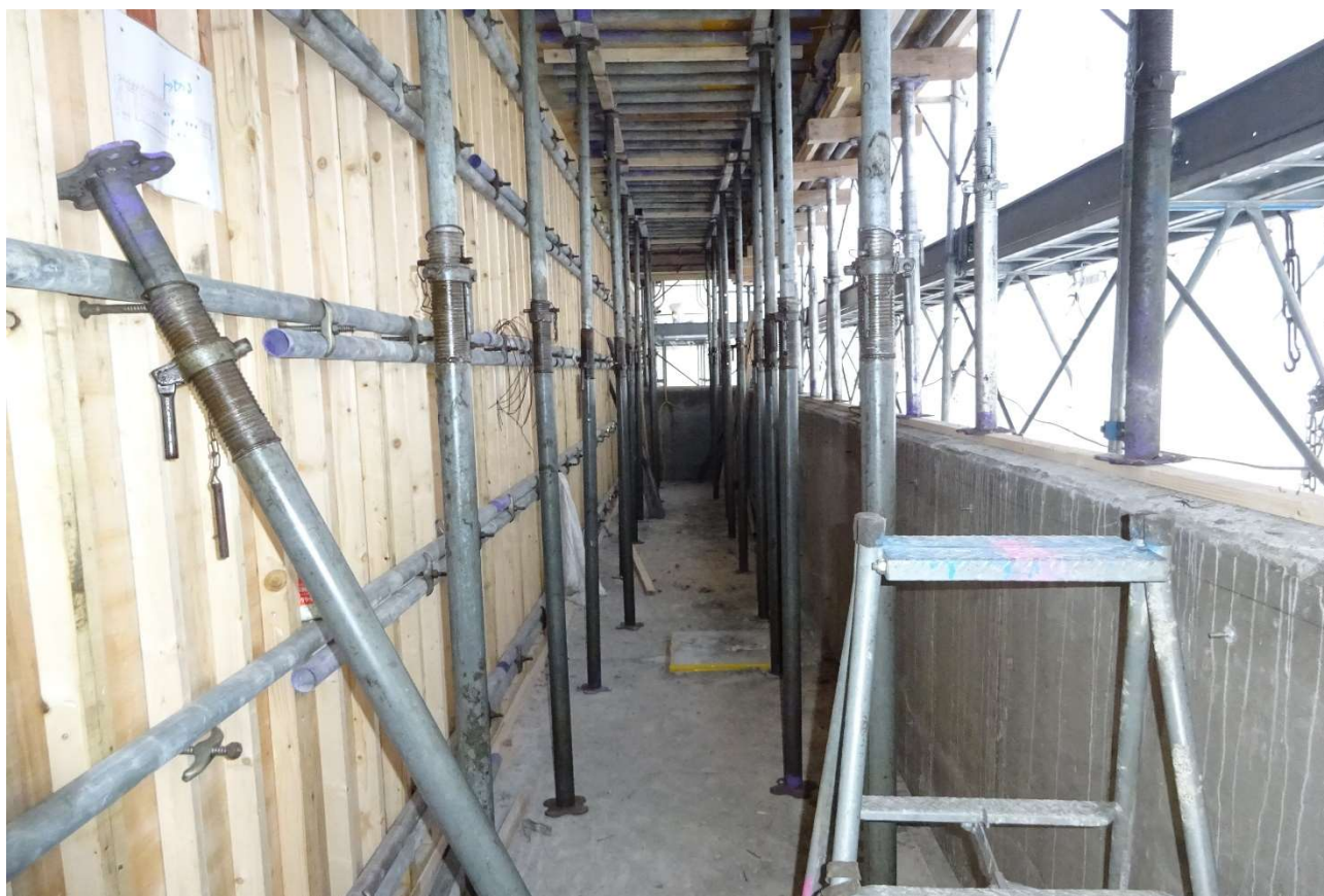
2階バルコニーの状況です。
