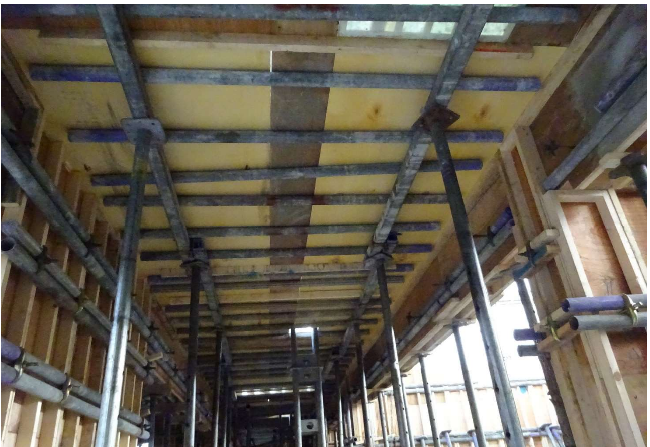
一部既にスラブがかけられた箇所があります。
