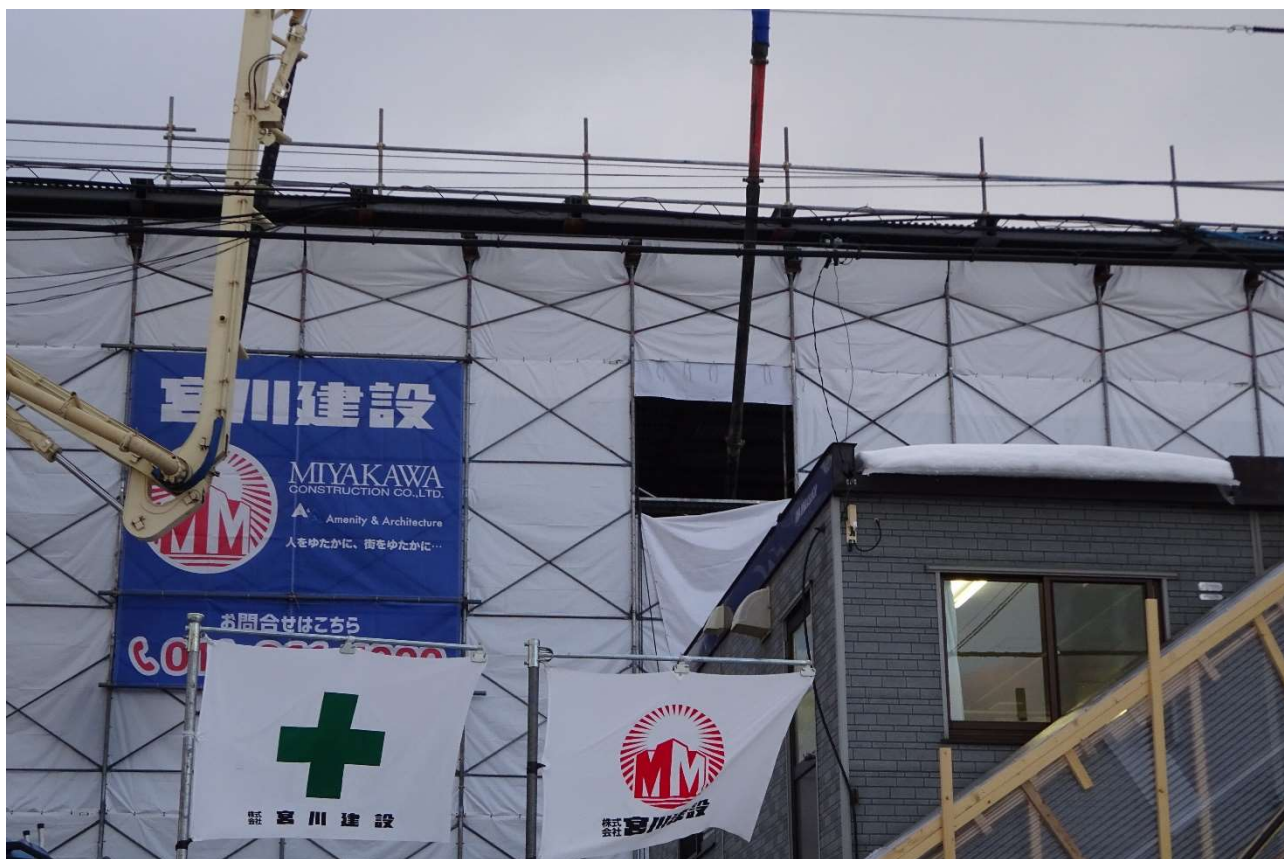
生コンクリートを注入するパイプを通す枠です。
