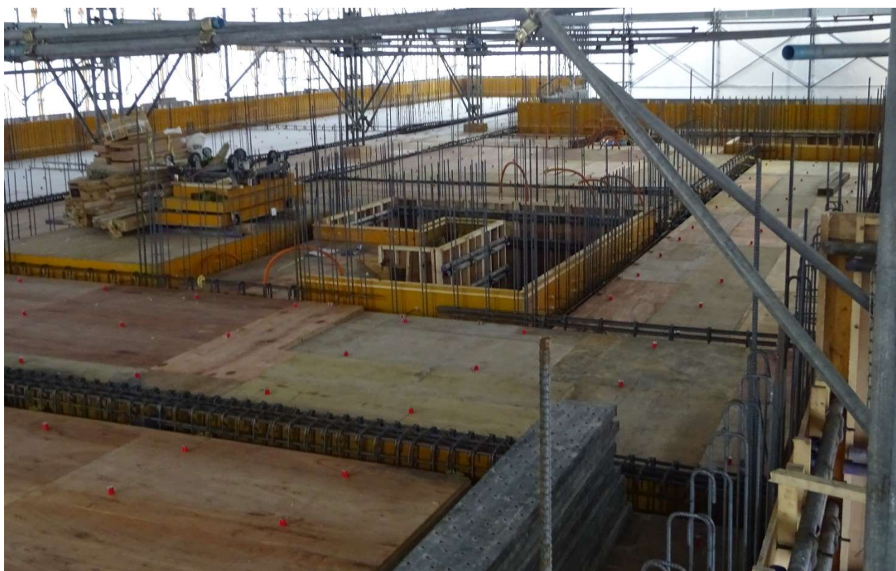
3階エレベータと階段室付近の写真です。
