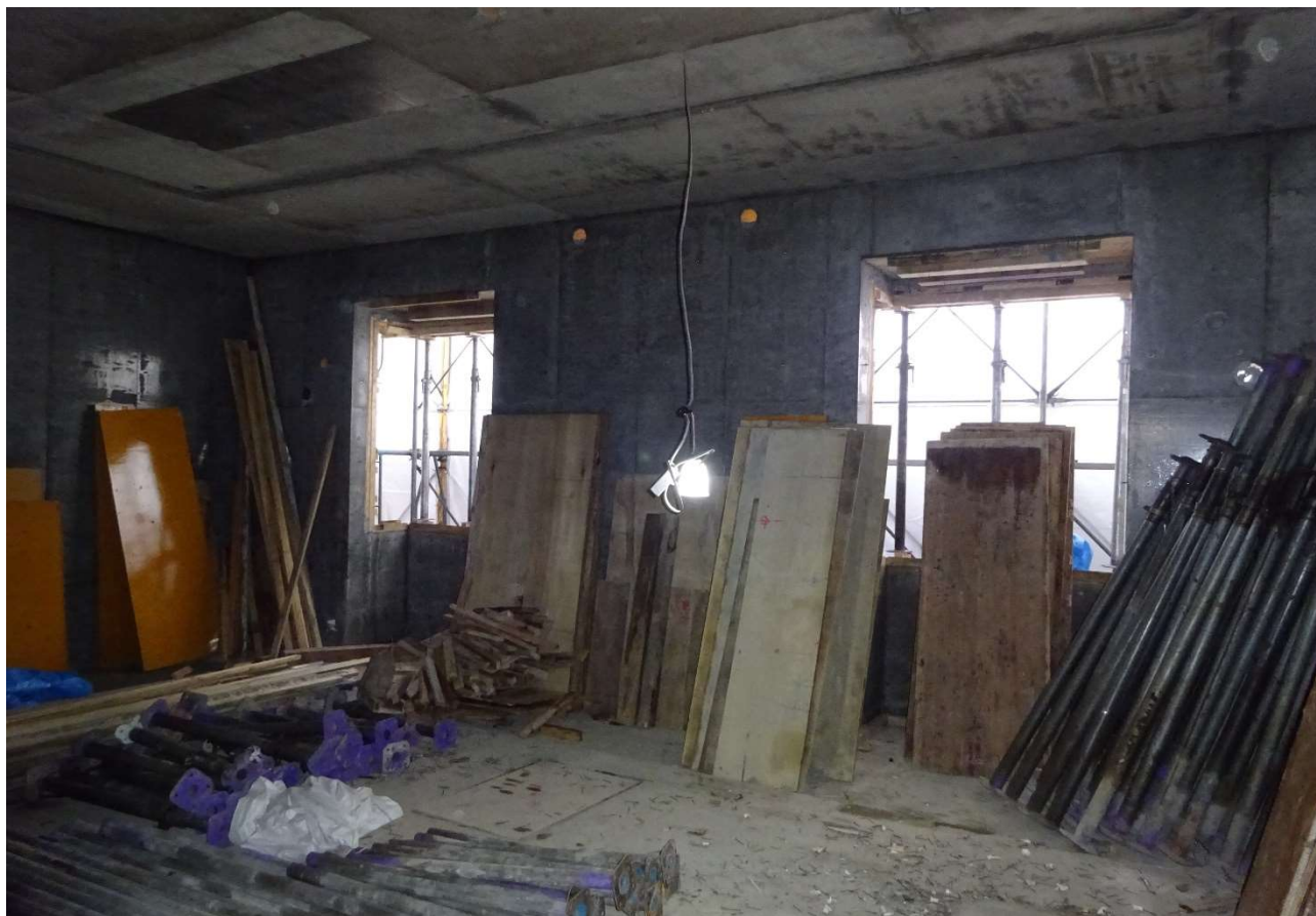
2階内部の型枠の解体状況です。
