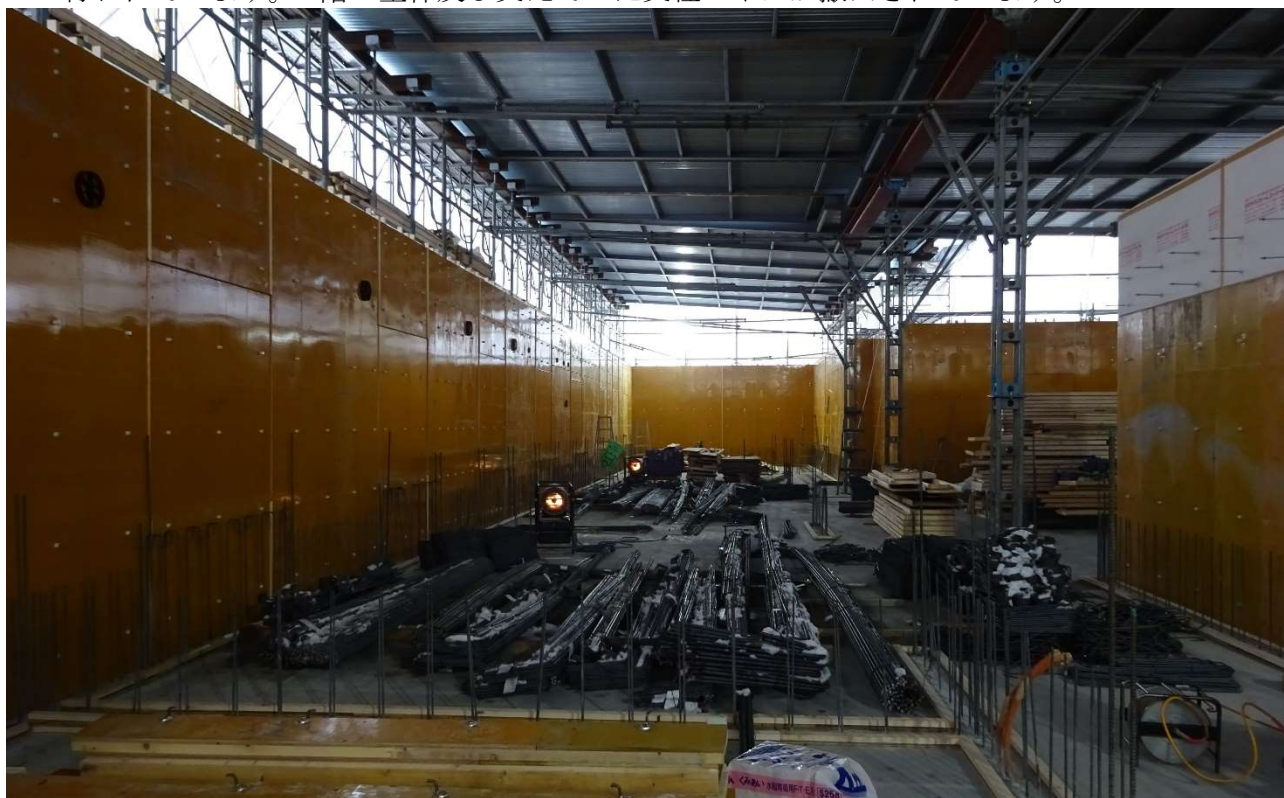
3階の外部枠取付と大量の鉄筋が運ばれています。
