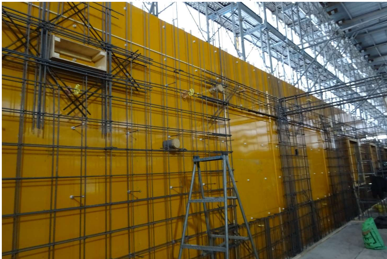
2階厨房予定位置から撮影しました。
