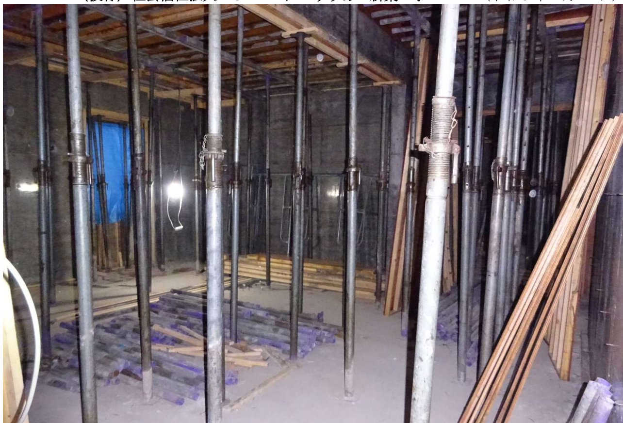
1階内部の状況です。
