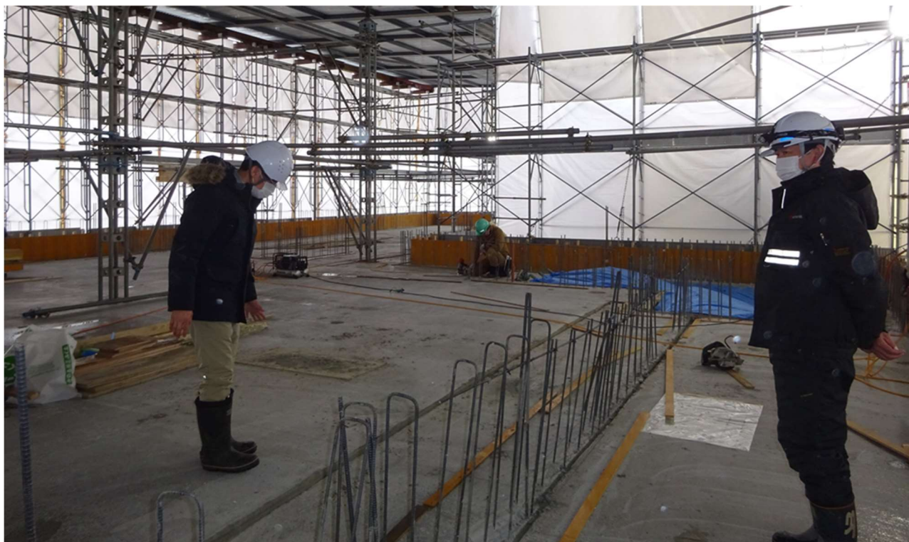
工事現場の所長とコンクリートの状況を確認しています。
