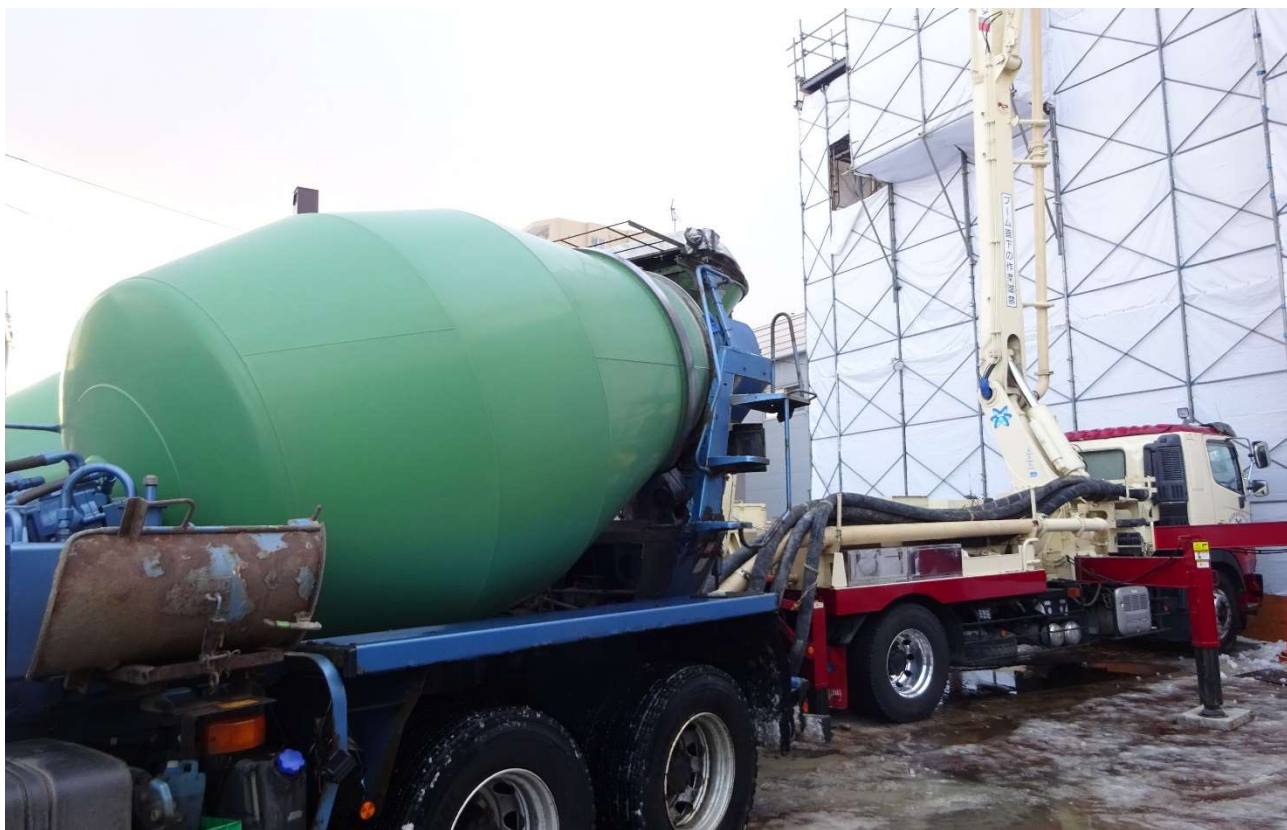
生コンクリートを高所に押し上げるポンプ車です。
