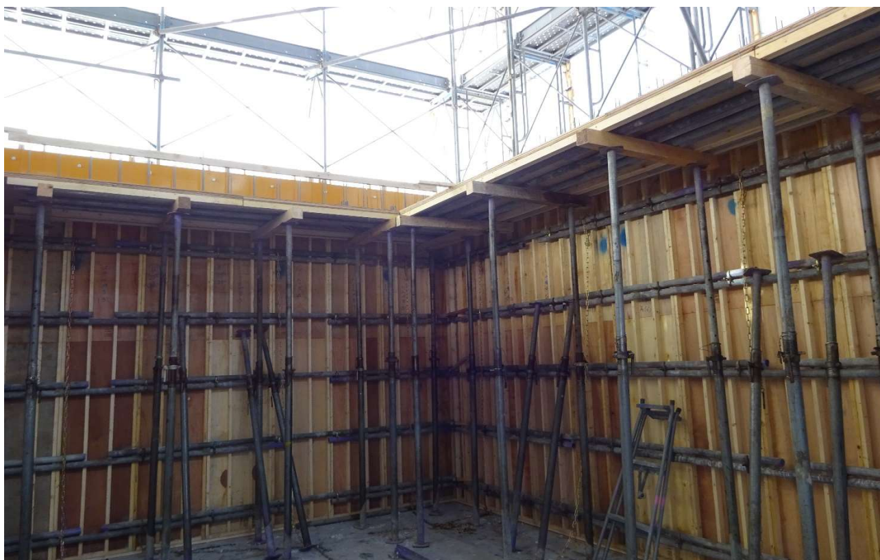
3階スラブ（床）を作る為の型枠工事が始まりました
