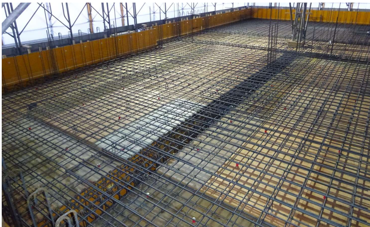
3階スラブ配筋の状態です。
