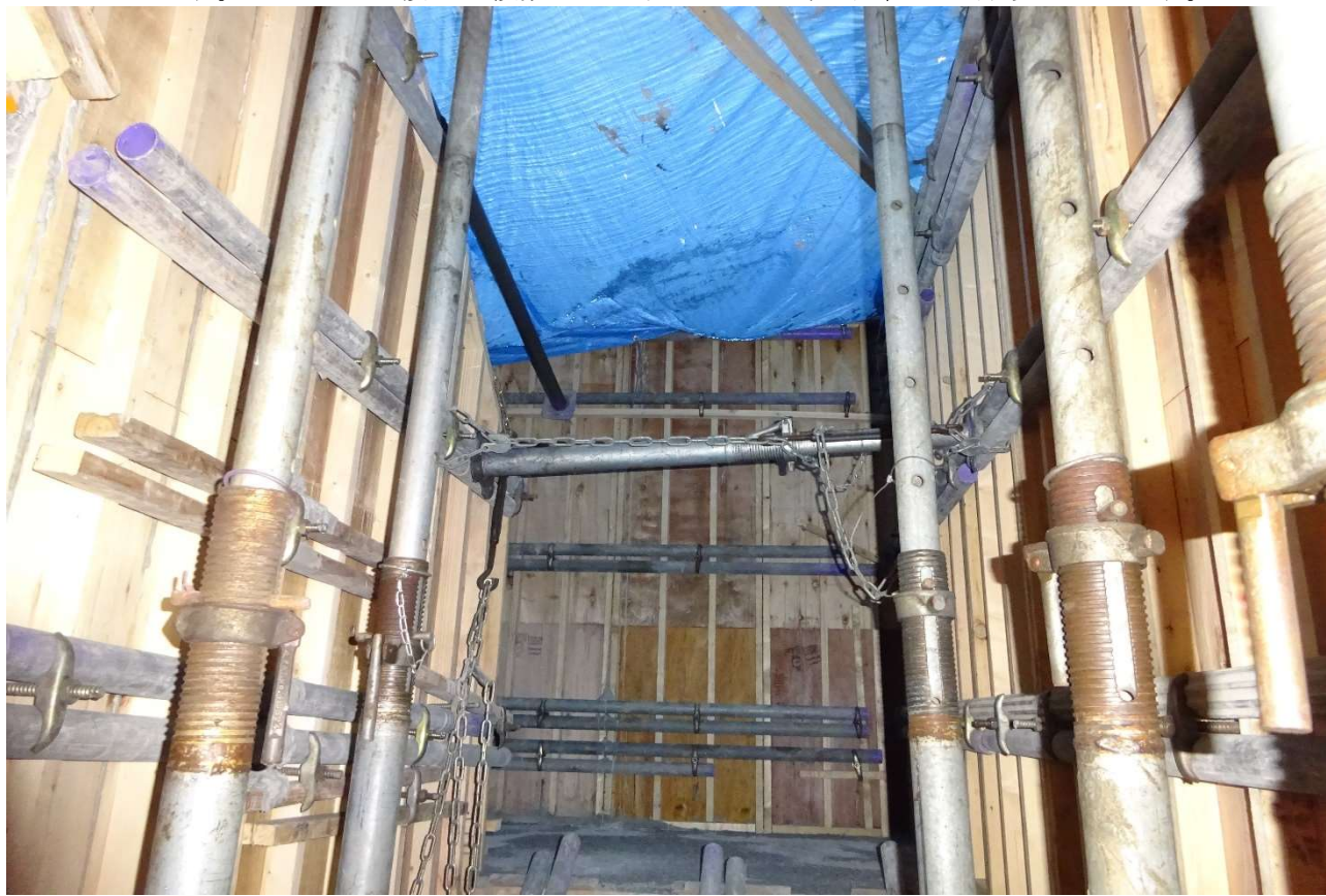
階段部など要所にはビニールで覆う等の処置がなされています。
