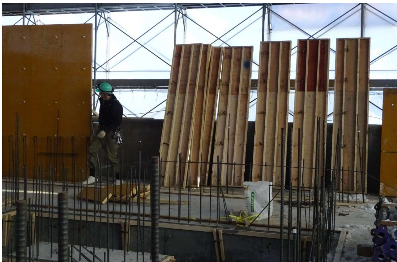
2階外部枠用の型枠を次々と組み上げています。
