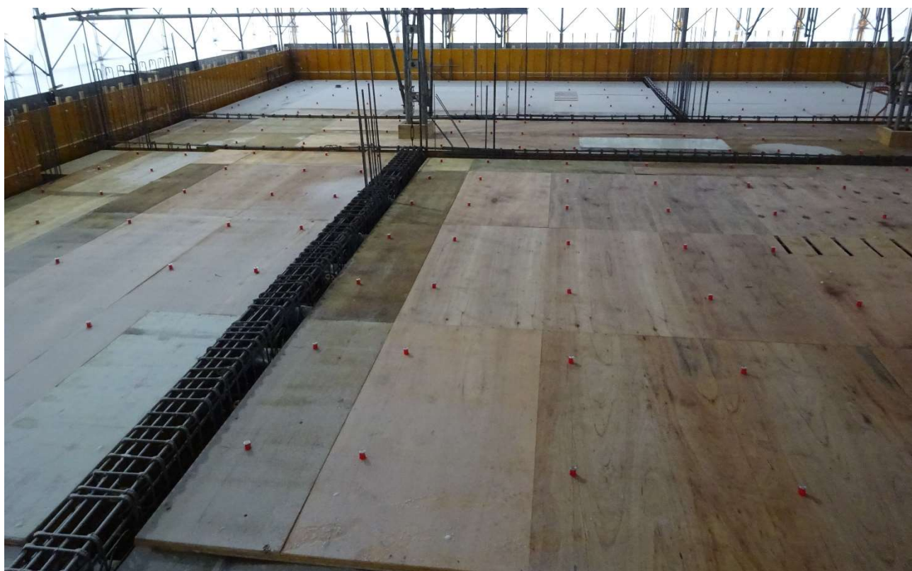
建物の外周には生コンクリートが漏れないように高くなっています。
