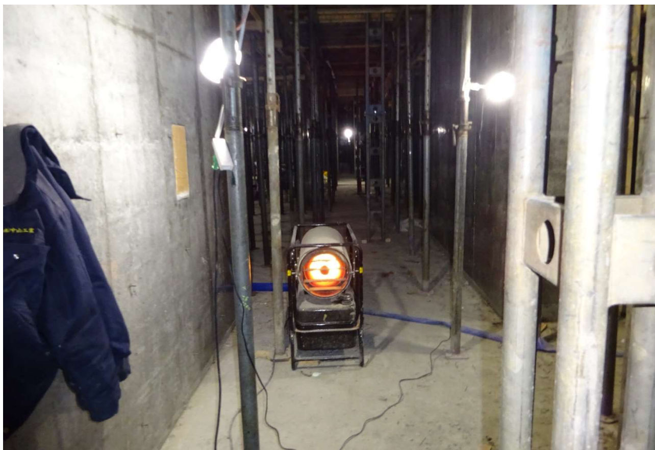
3階部分は採暖養生が行われています。
