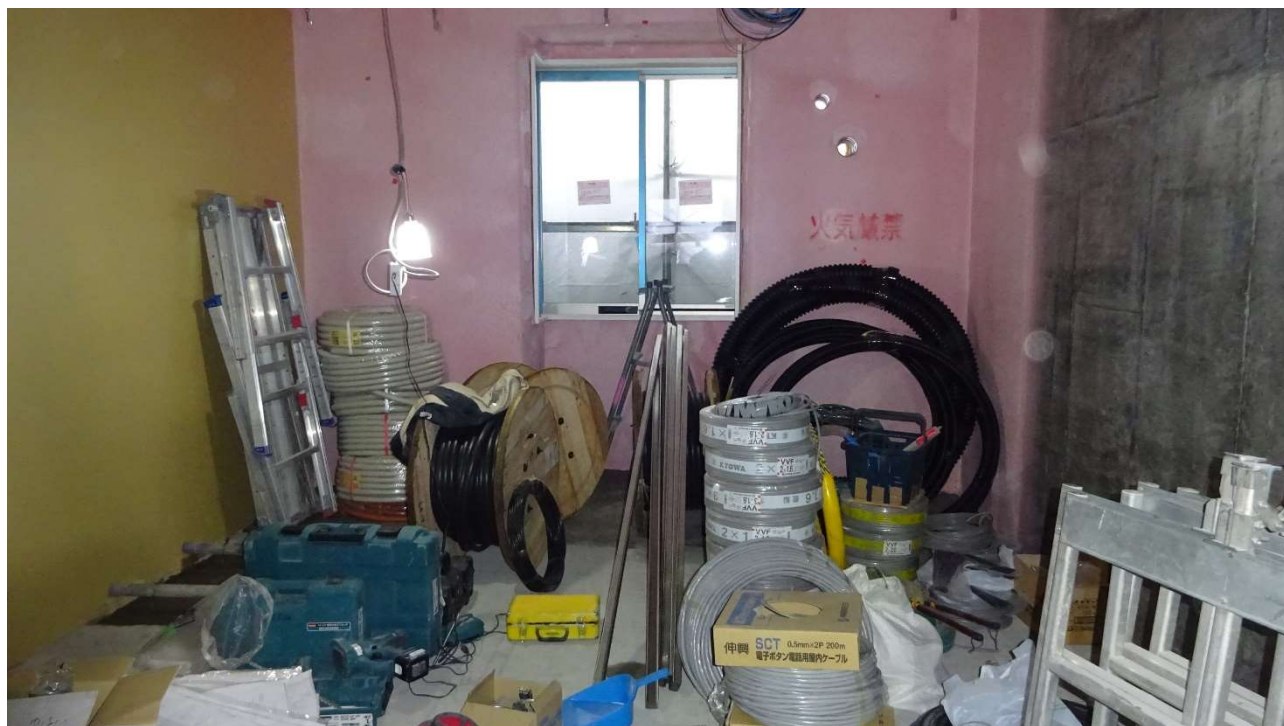
天井に張り巡らすケーブルです。
