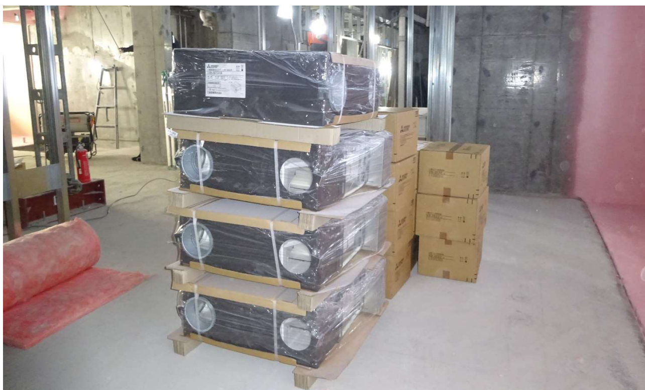
1階グループホームの空調とケーブル類です。
