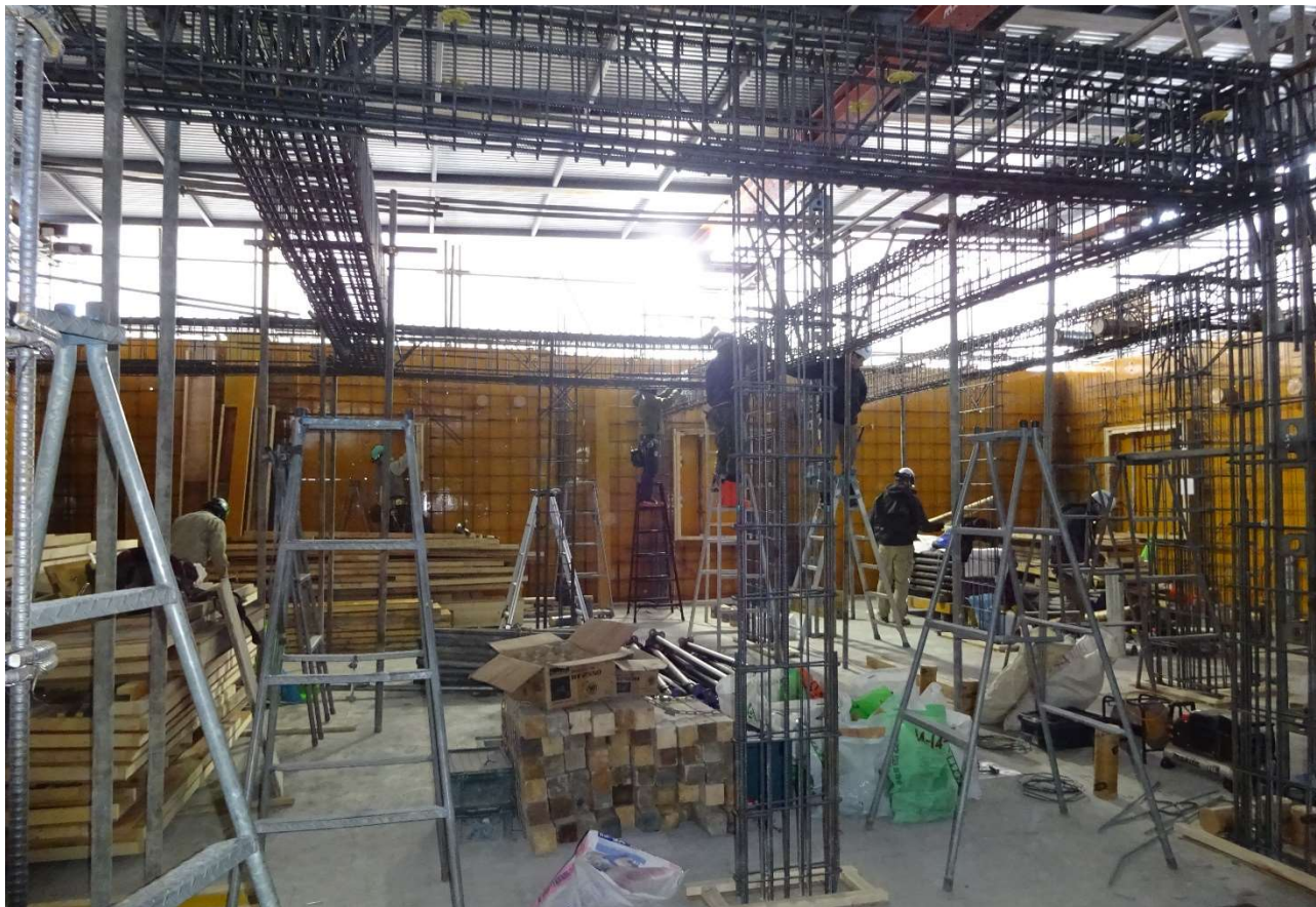
梁の配筋工事の状況です。
