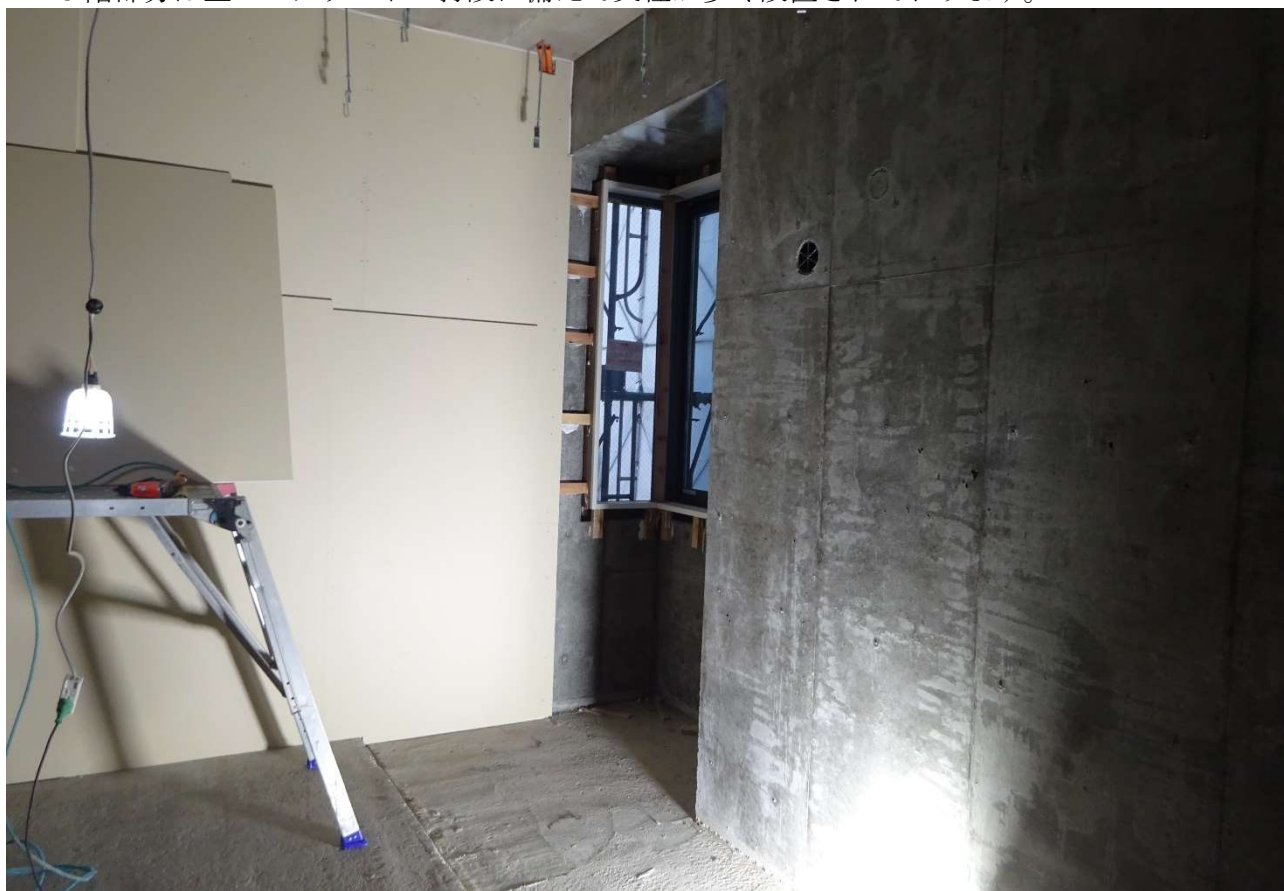
1階の個室への石膏ボード取り付け、右は出窓です。
