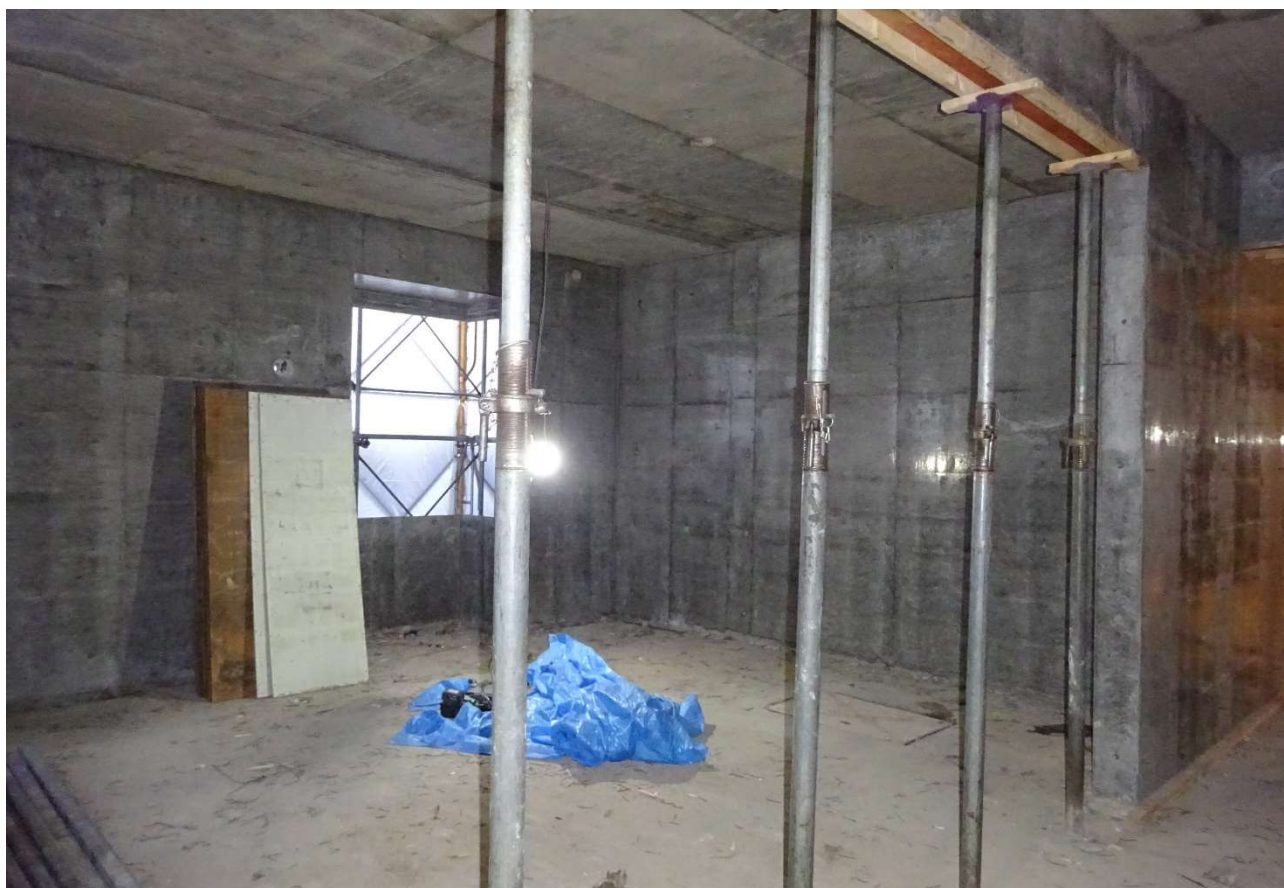
1階壁の個室部分の型枠は取り省かれています。
