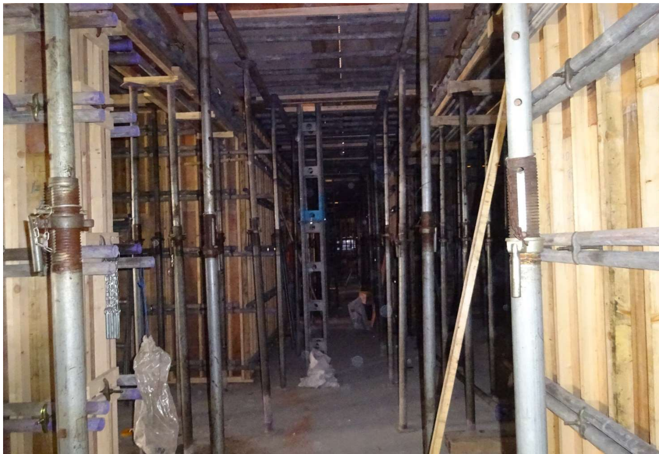
スラブ(屋上)を支える支柱類。
