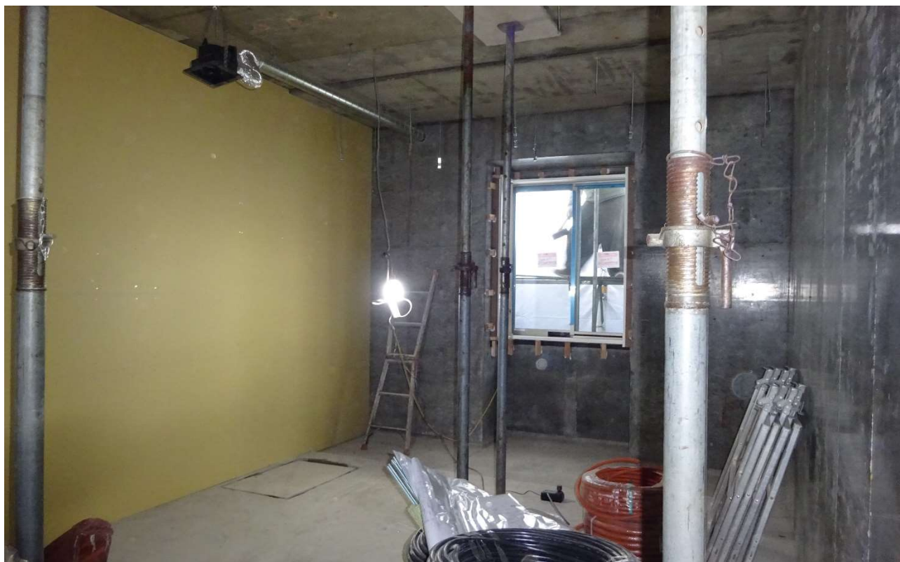
窓、壁の取り付けが順次行われています。
