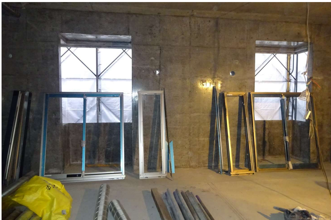
1階個室の出窓の3枚のサッシのセットです。
