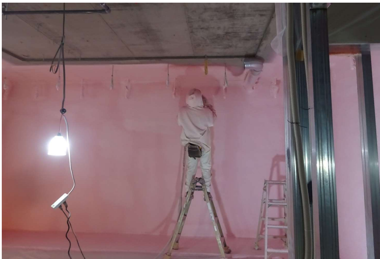
2階では発泡スチロール吹付け作業が行われています。
