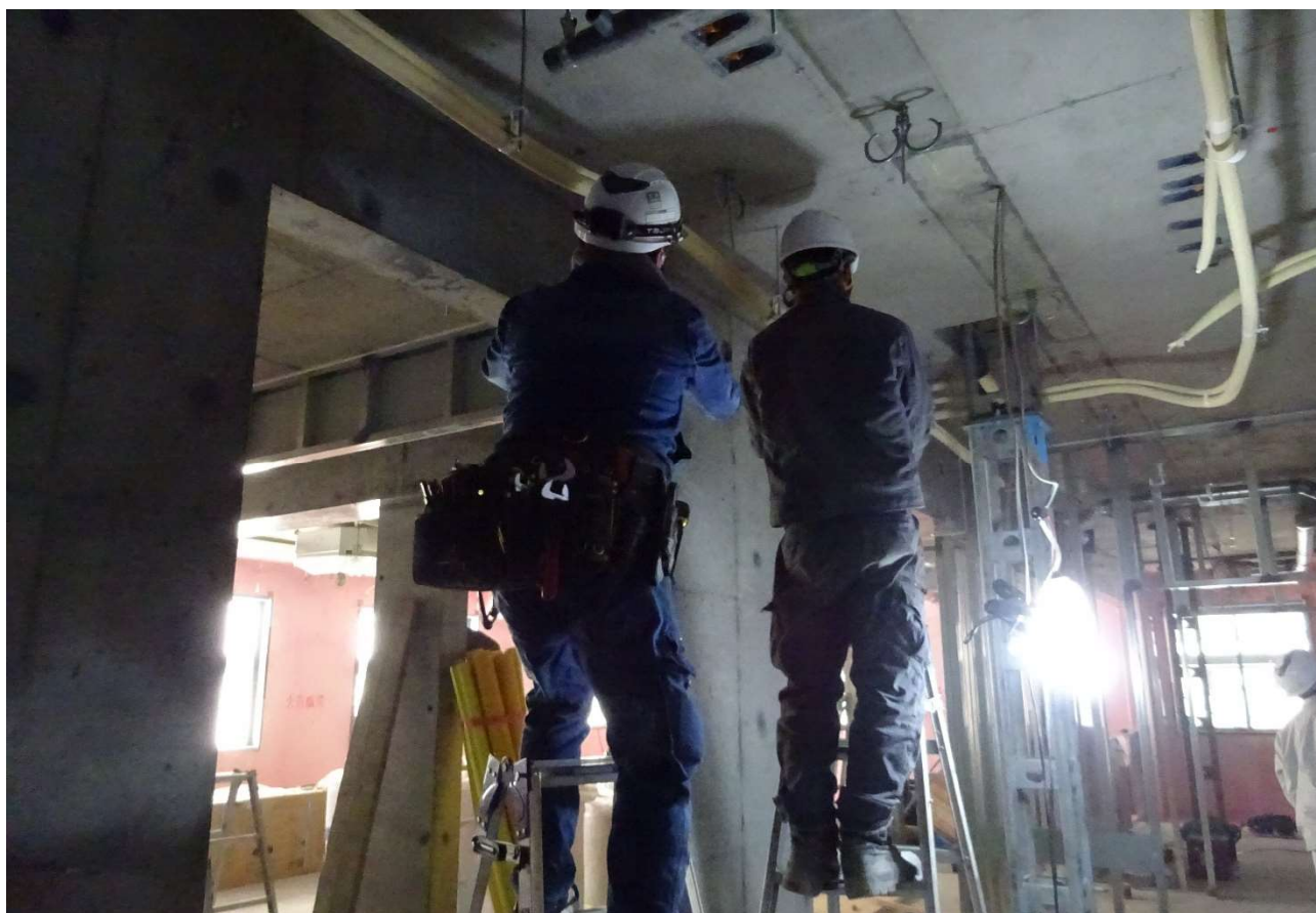
2階相談事務室付近の天井用各種ケーブル作業を行っています。
