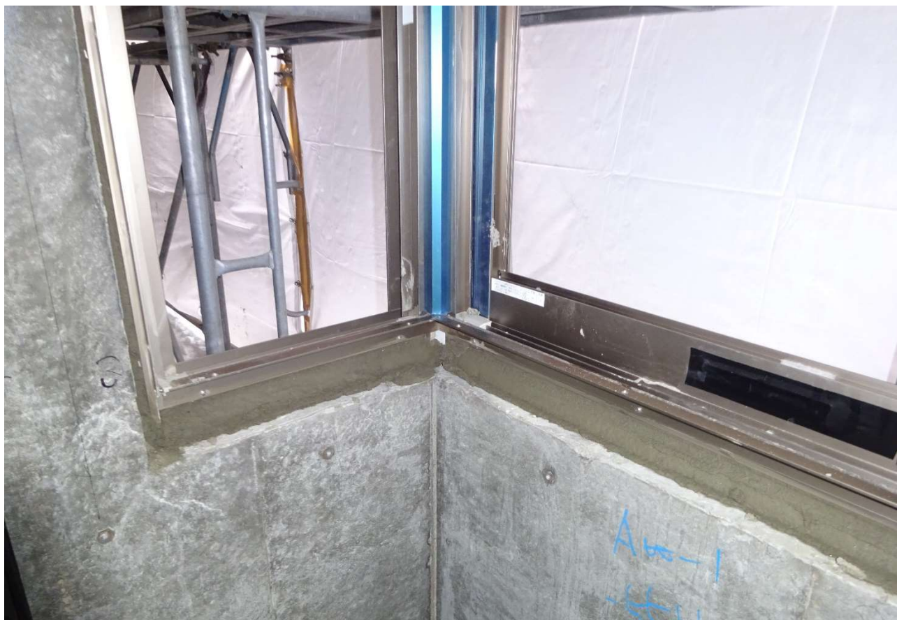
1階個室の出窓部分の窓枠サッシです。
