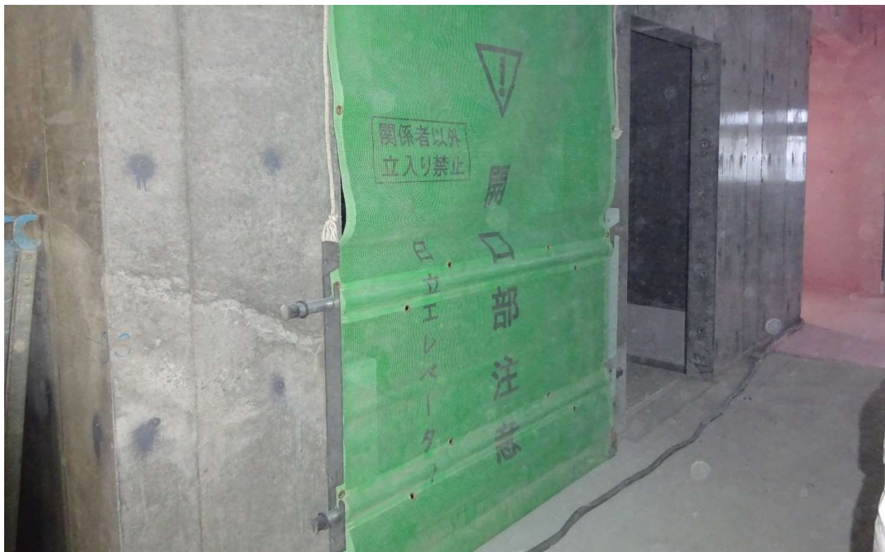
1階のエレベーター入り口です。
