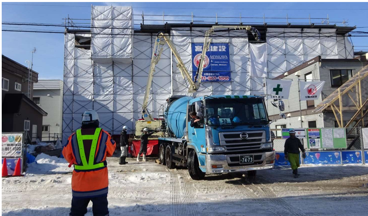
ミキサー車から生コンクリートの供給を受けて屋上迄上げています。
