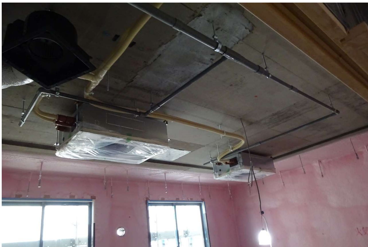
2階にも空調の設置が開始されました。
