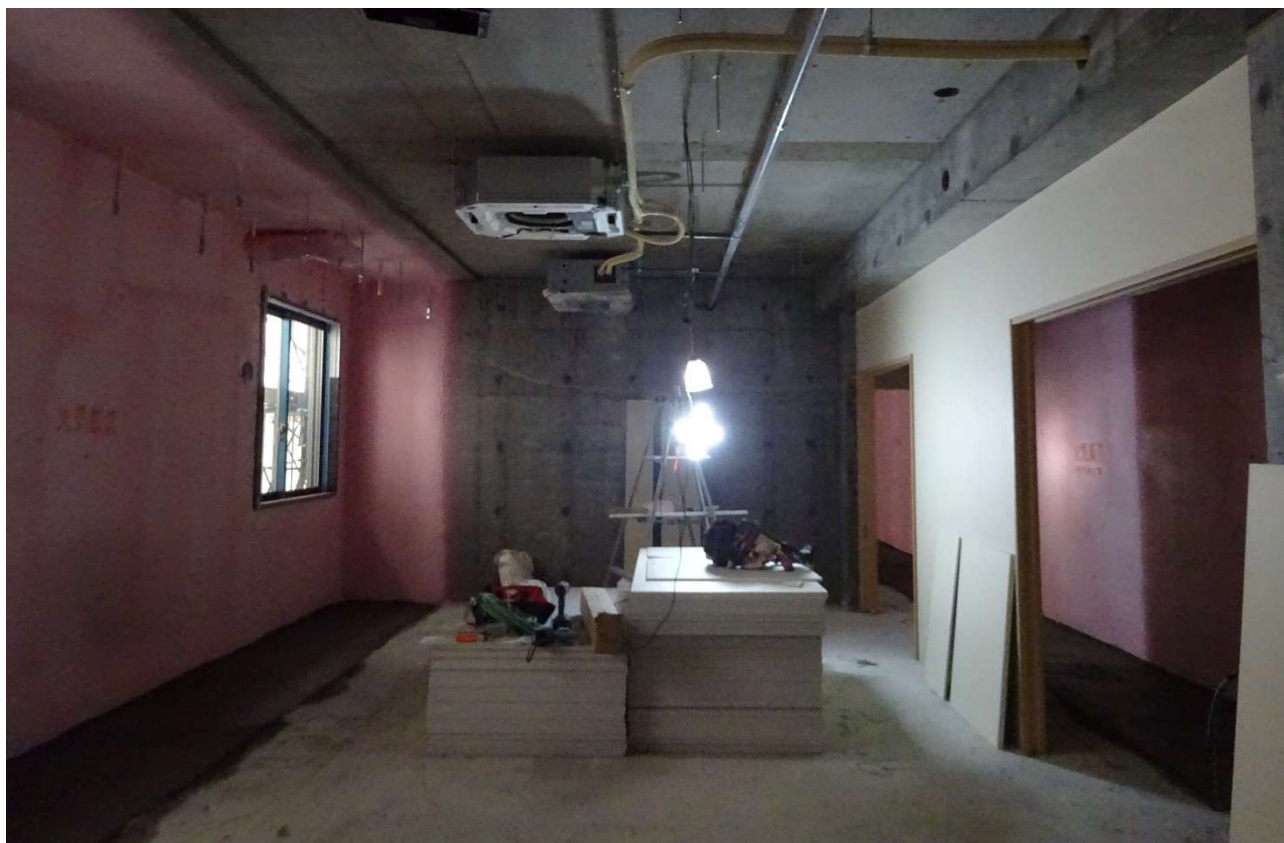
2階の石膏ボード貼り作業の準備が行われています。
