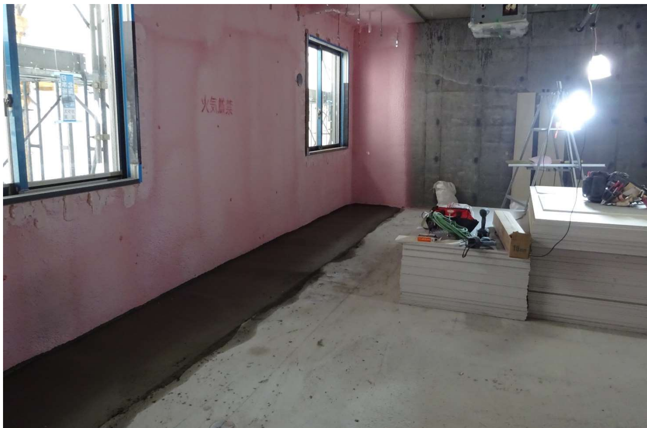
同上の施行を床に施行しました。
