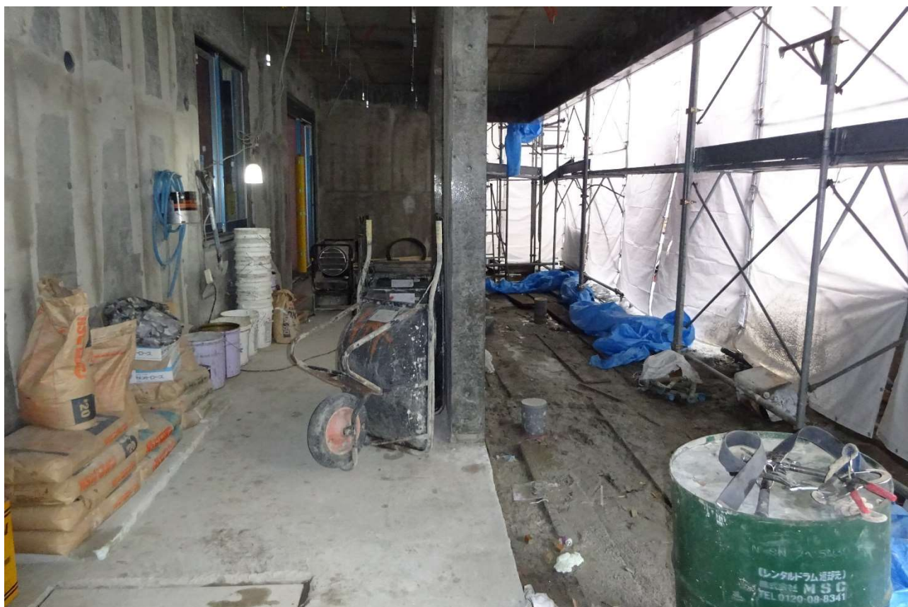
1階玄関の状況です。
