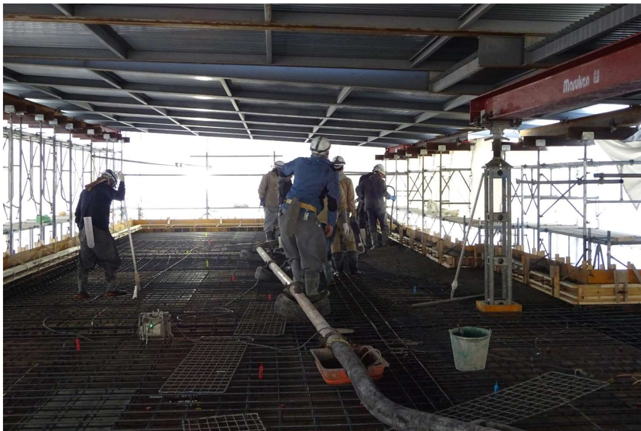
生コンクリート注入用のホースを数人で保持しています。
