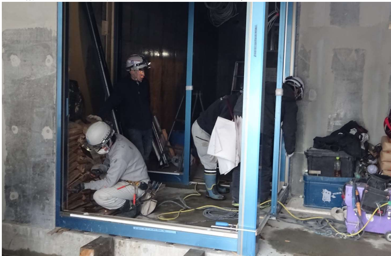
左側玄関の風除室部のサッシです。
