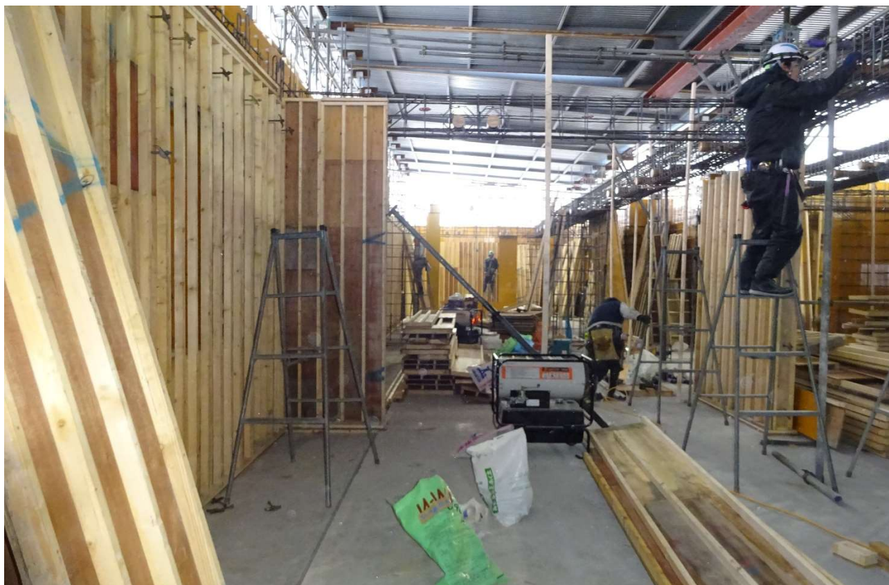
梁の配筋作業が続いています。
