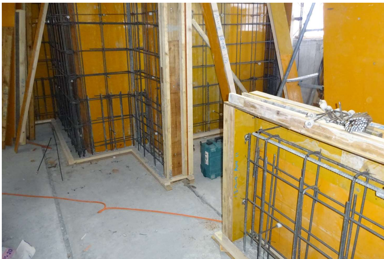
3階バルコニー入り口の型枠状況です。
