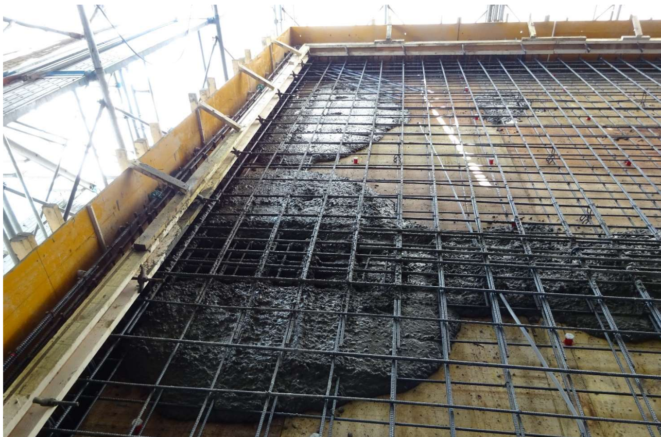
最初に3階の壁になる部分に生コンクリートを充填します。
