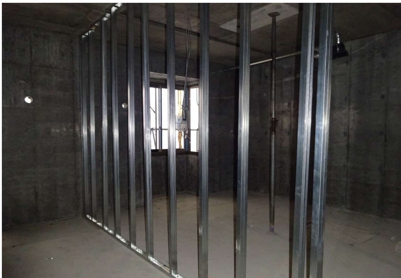
間仕切り用の軽量鉄骨が組み立てられています。
