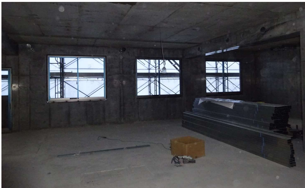
2階食堂部に軽量鉄骨が搬入されました。
