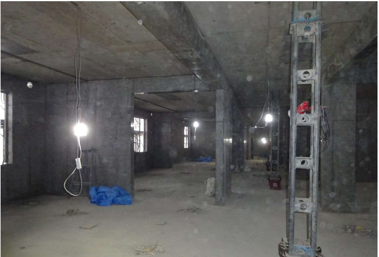
2階は型枠取り外し作業が進んでいます。
