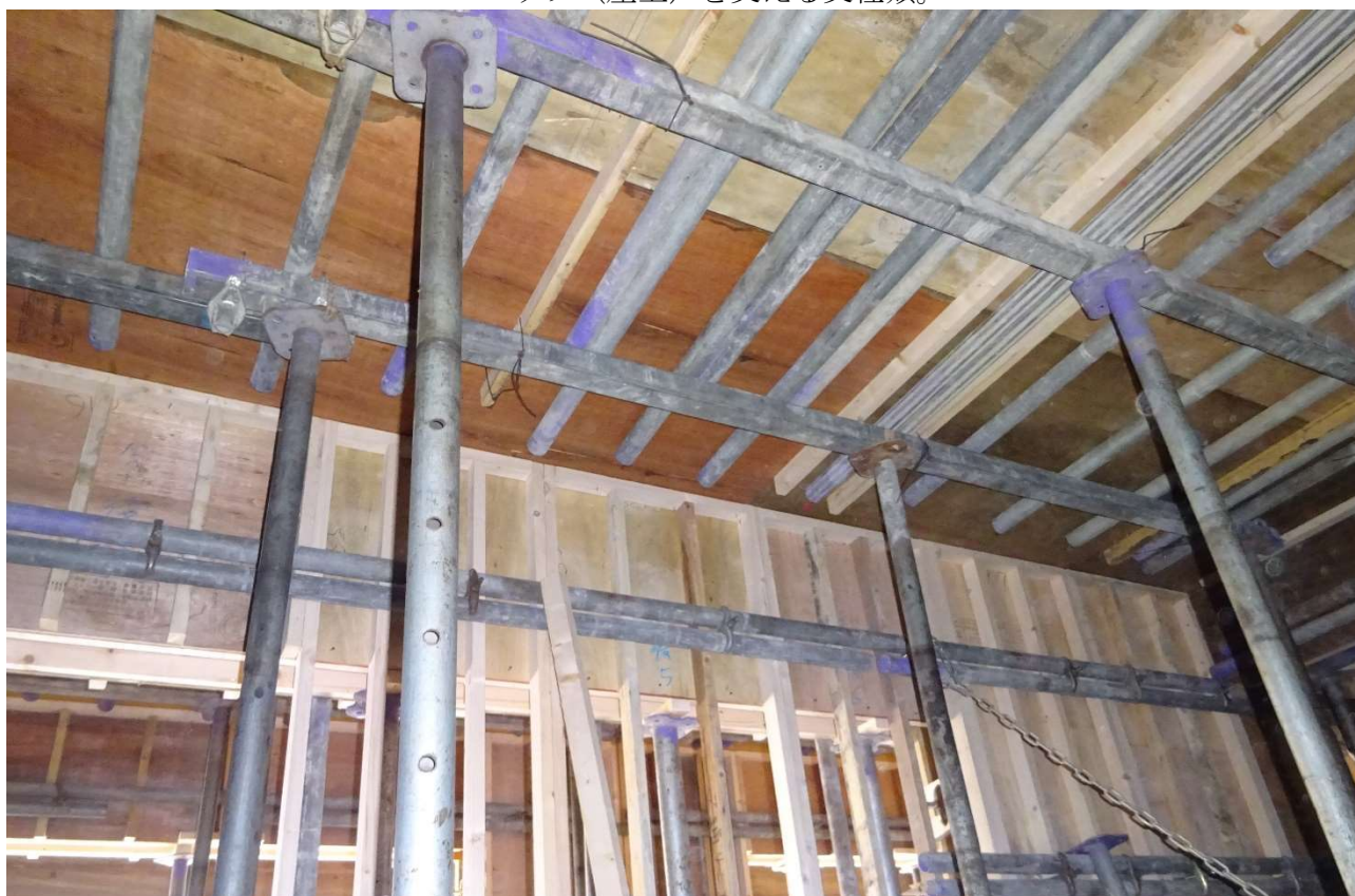
生コンクリートの重さに耐えられる様に支柱が組まれています。
