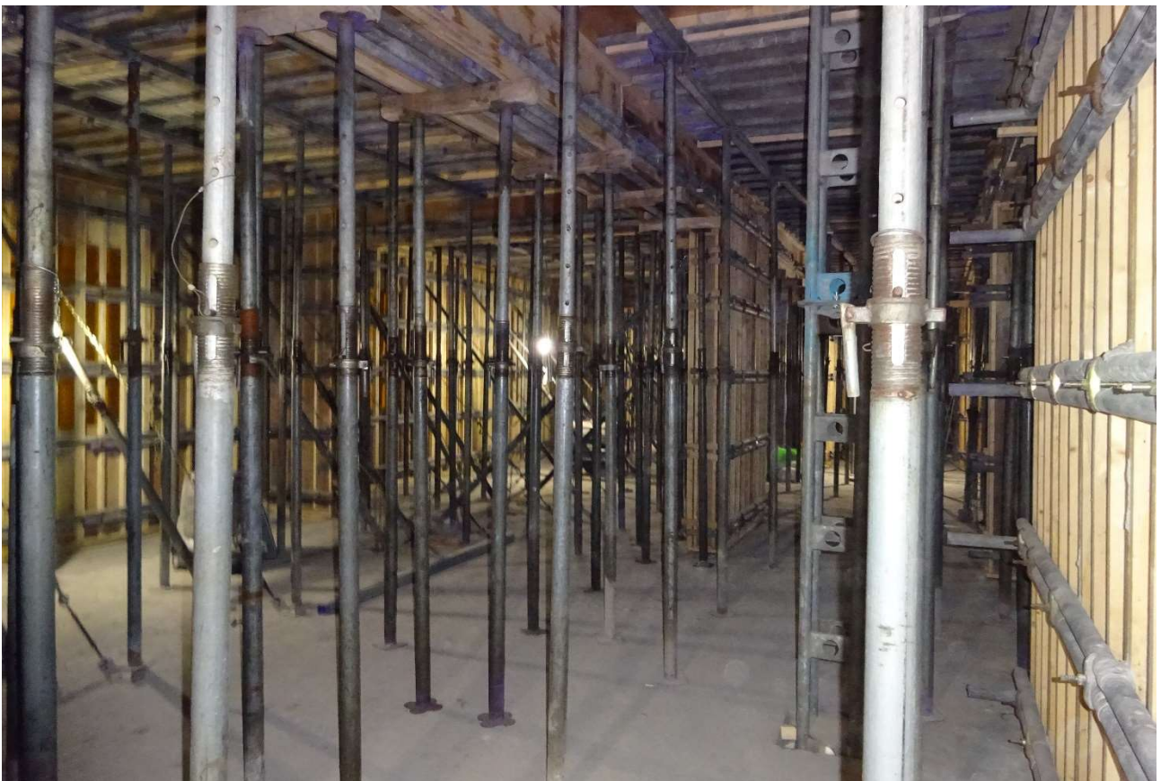
3階の部分は養生が引き続き行われています。
