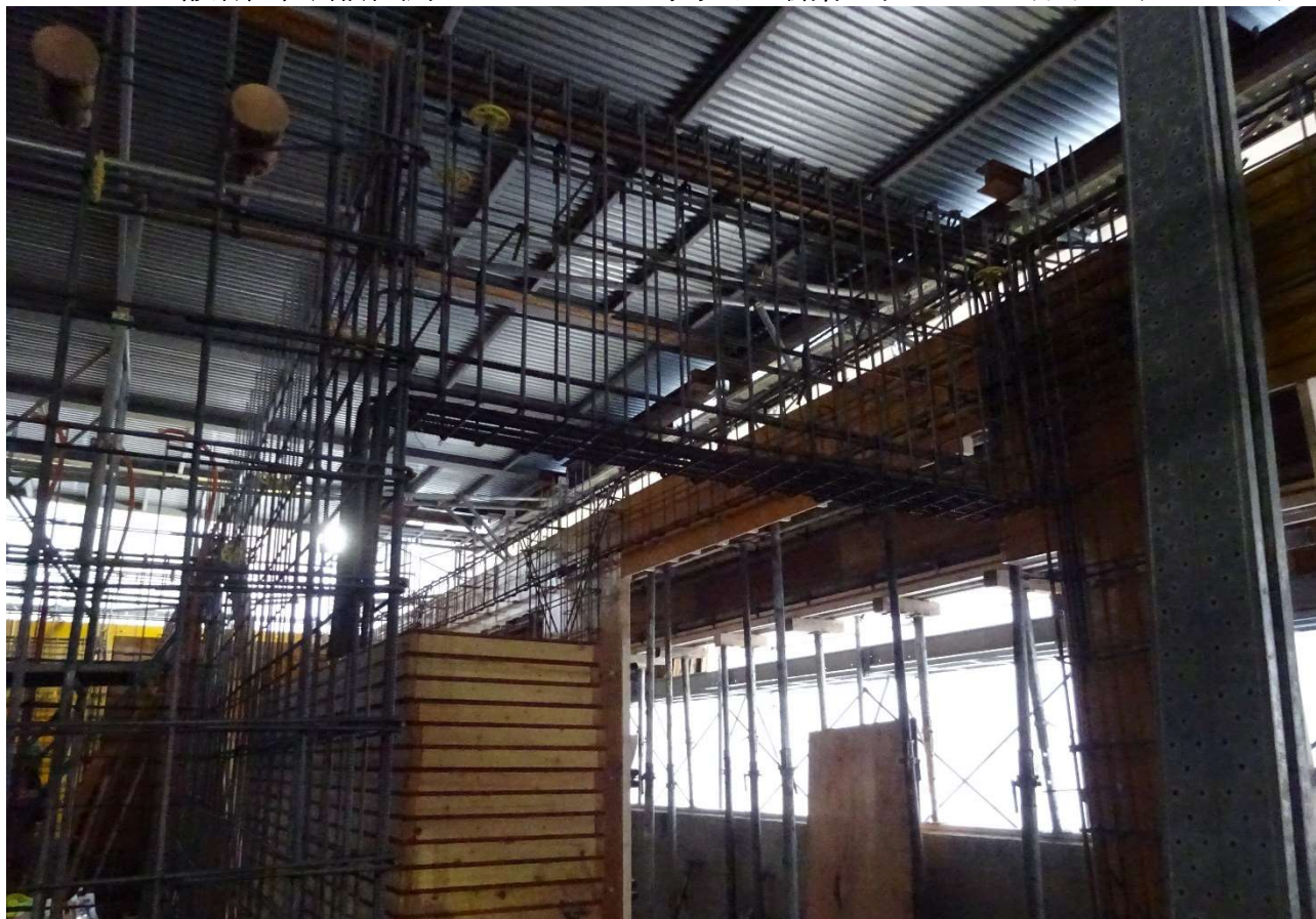
3階の梁の配筋状態です。
