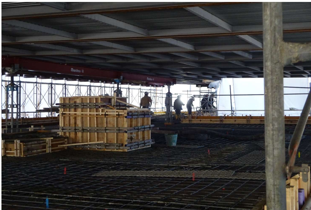
屋上の全般状況です。
