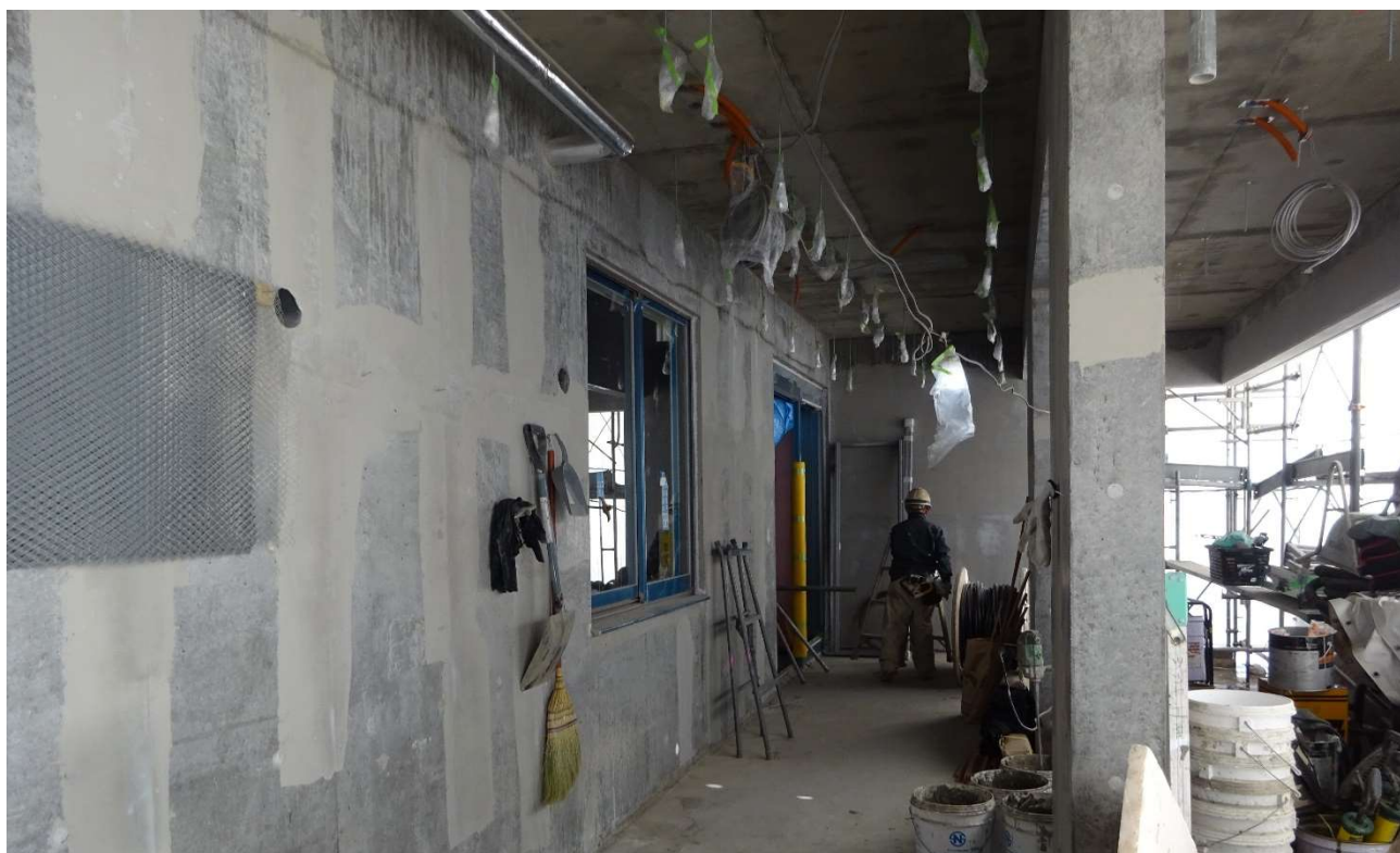
1階玄関部の前部分です、コンクリートの表面を一部研磨しています。
