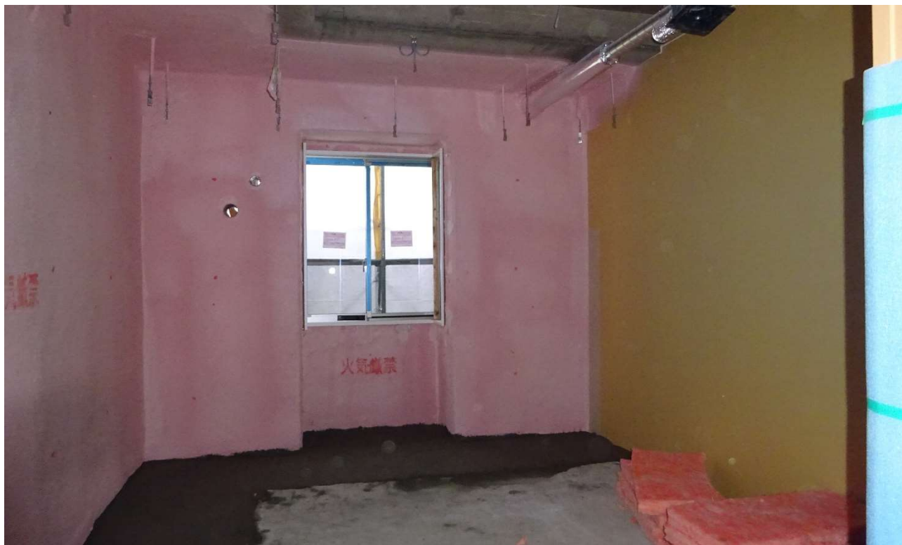
1階の個室の外壁部には、桃色の吹付け発泡スチロールが吹き付けられています。
