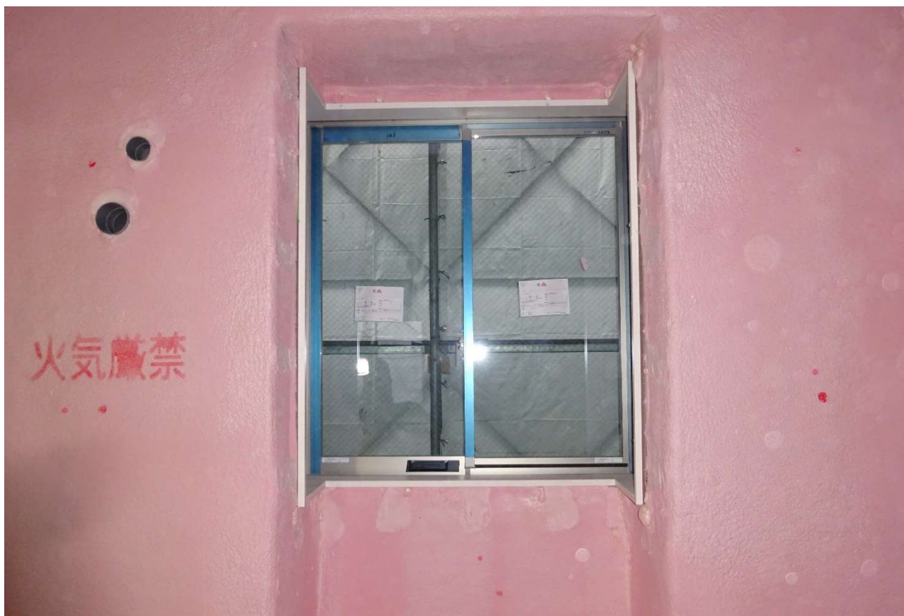
1階個室の出窓が完成しています。
