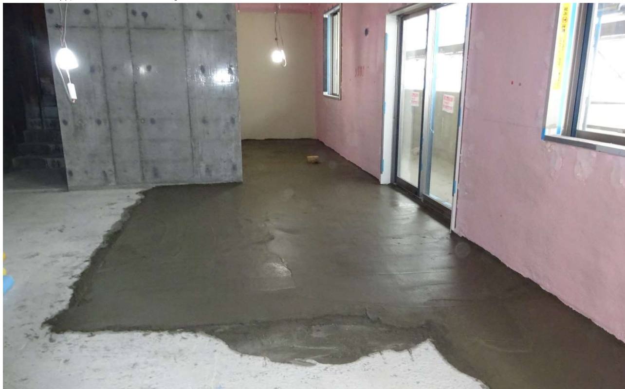
床に吹付けた発泡スチロール（ピンク色）の上にコンクリートで蓋を行いました。
