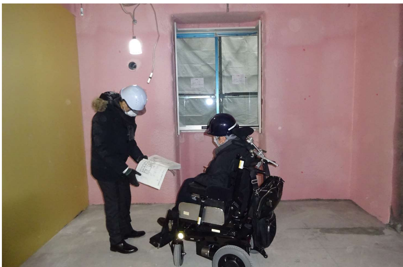
1階個室の状況を確認しています。
