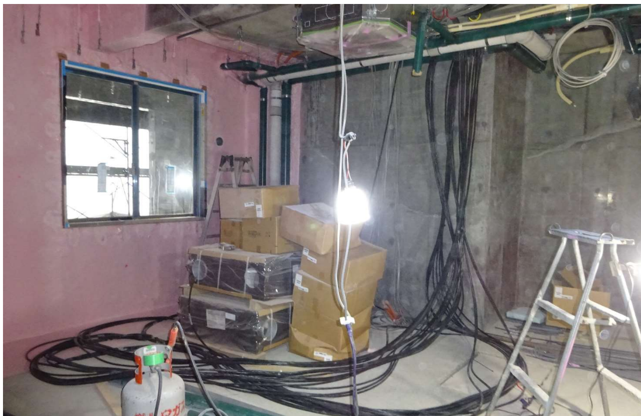
1階への設備工事が始まっています。
