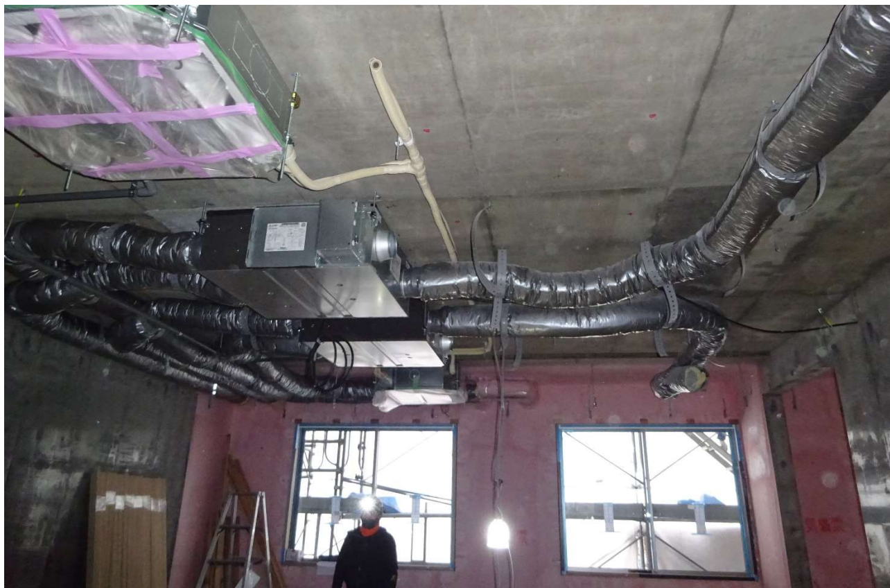
1階食堂兼居間の空調装置（エアコン）です。
