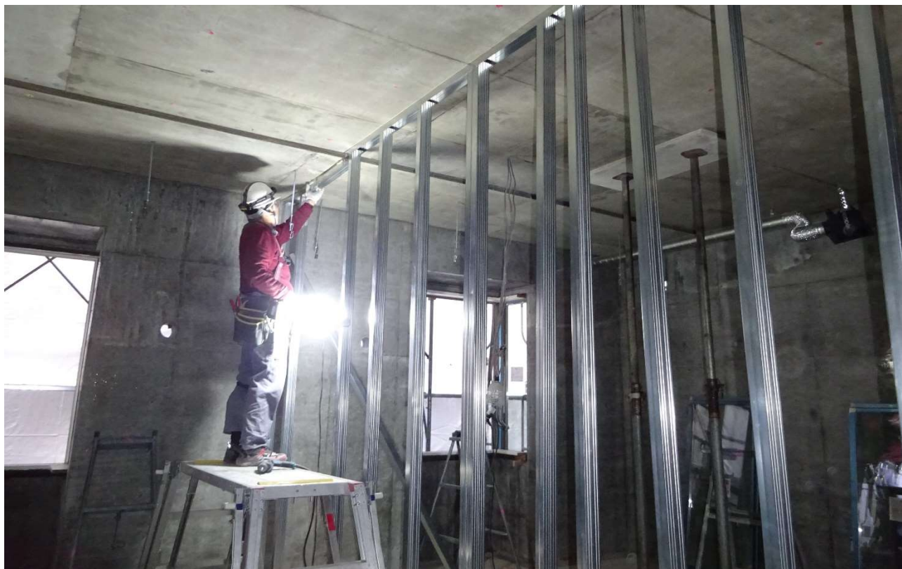
1階の個室部分に軽量鉄骨による仕切りを行っています。
