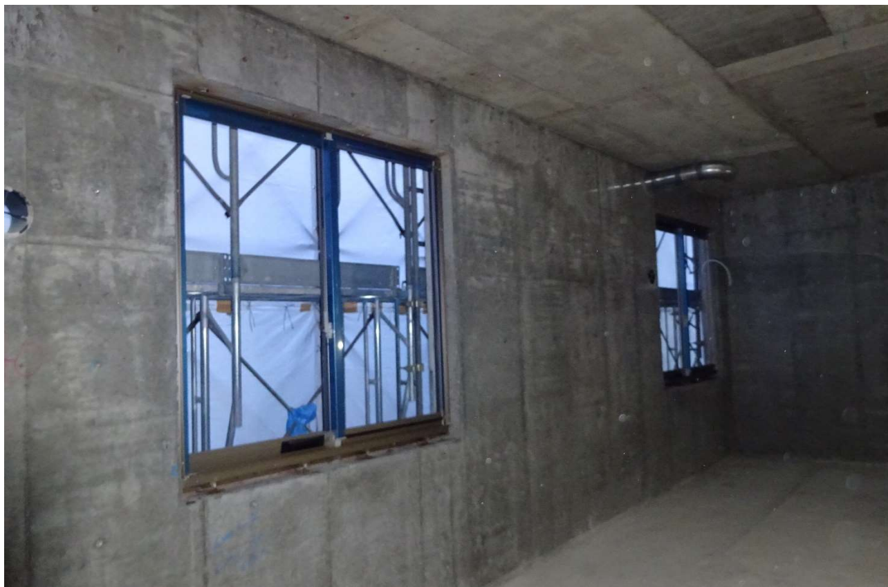
2階の窓にはガラスも入っています。
