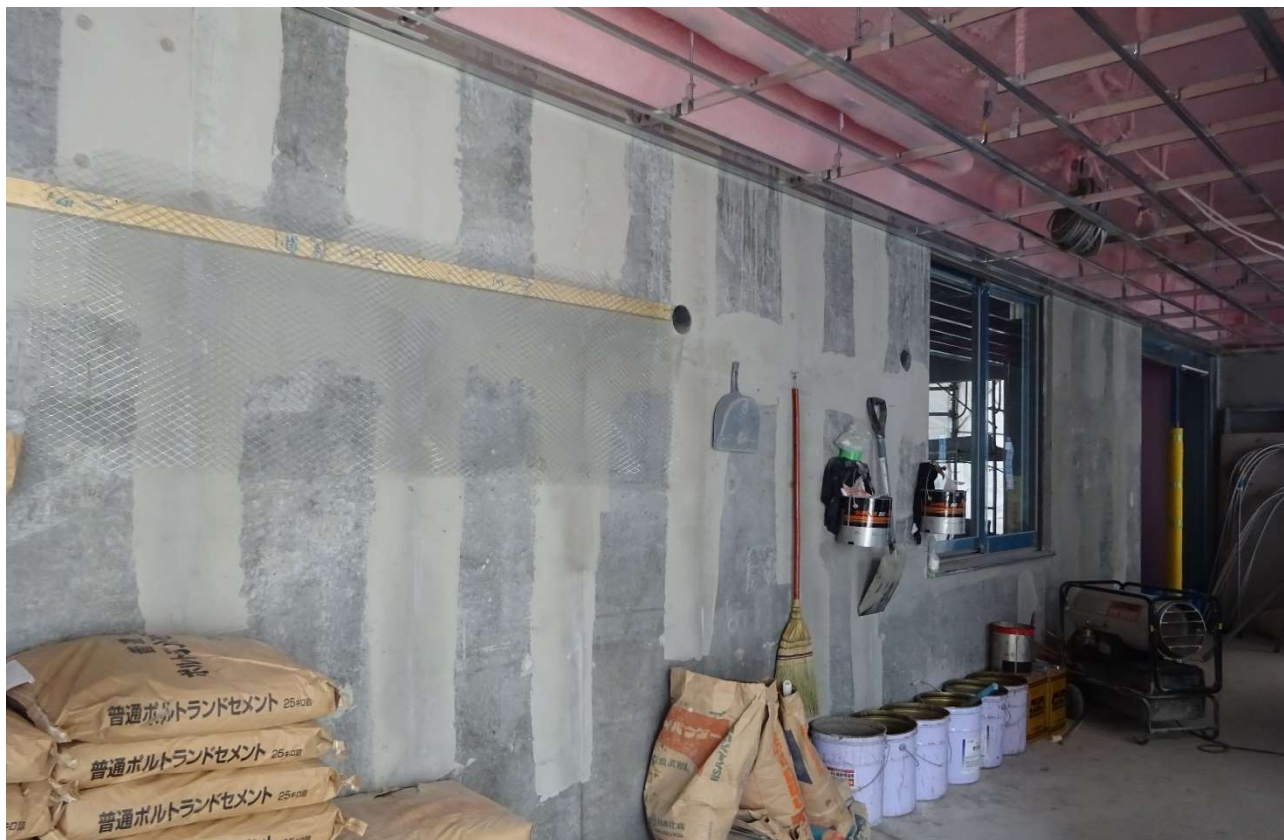
1階玄関部の前部分のコンクリートの表面は綺麗に研磨されています。
