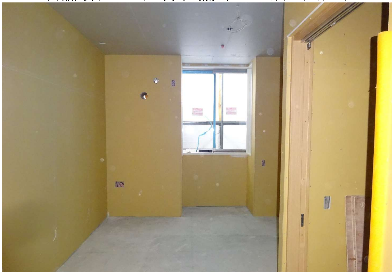
1階の個室に石膏ボードが丁寧に張り付けられました。
