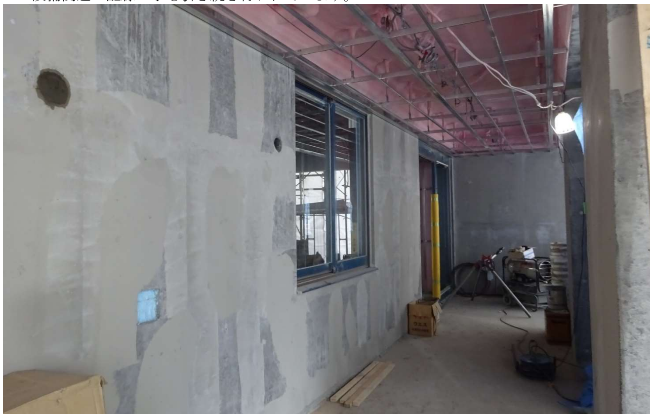
1階玄関部の前部分のコンクリートの表面は綺麗に研磨されています。
