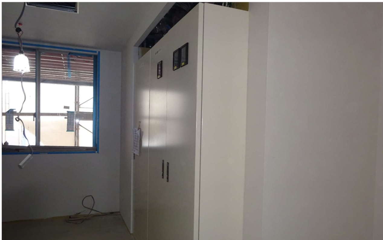
ケアホームゆうあい事務室の電源盤です。
