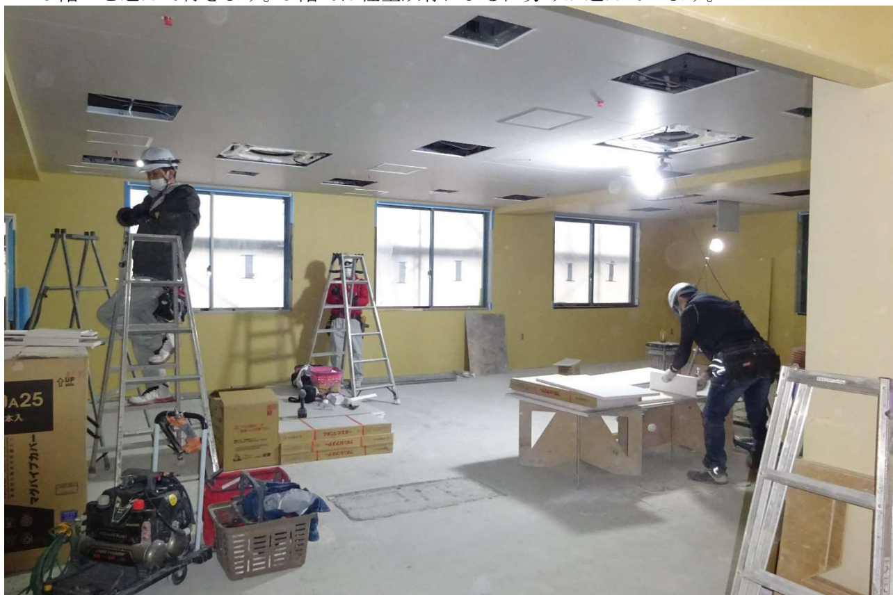
2階の食堂の作業の様子です。
