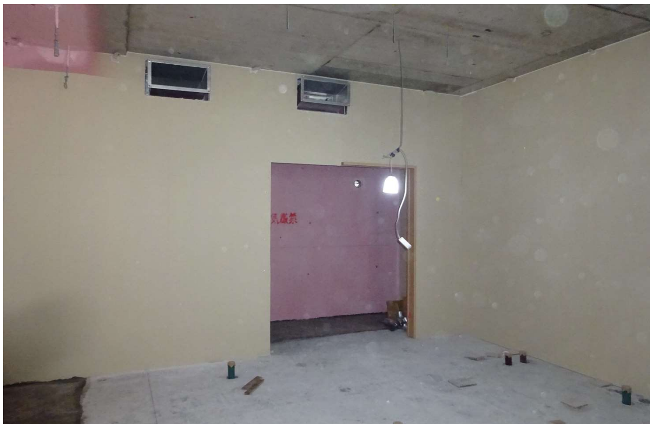
2階厨房の石膏ボード貼り状況です。奥は倉庫になります。
