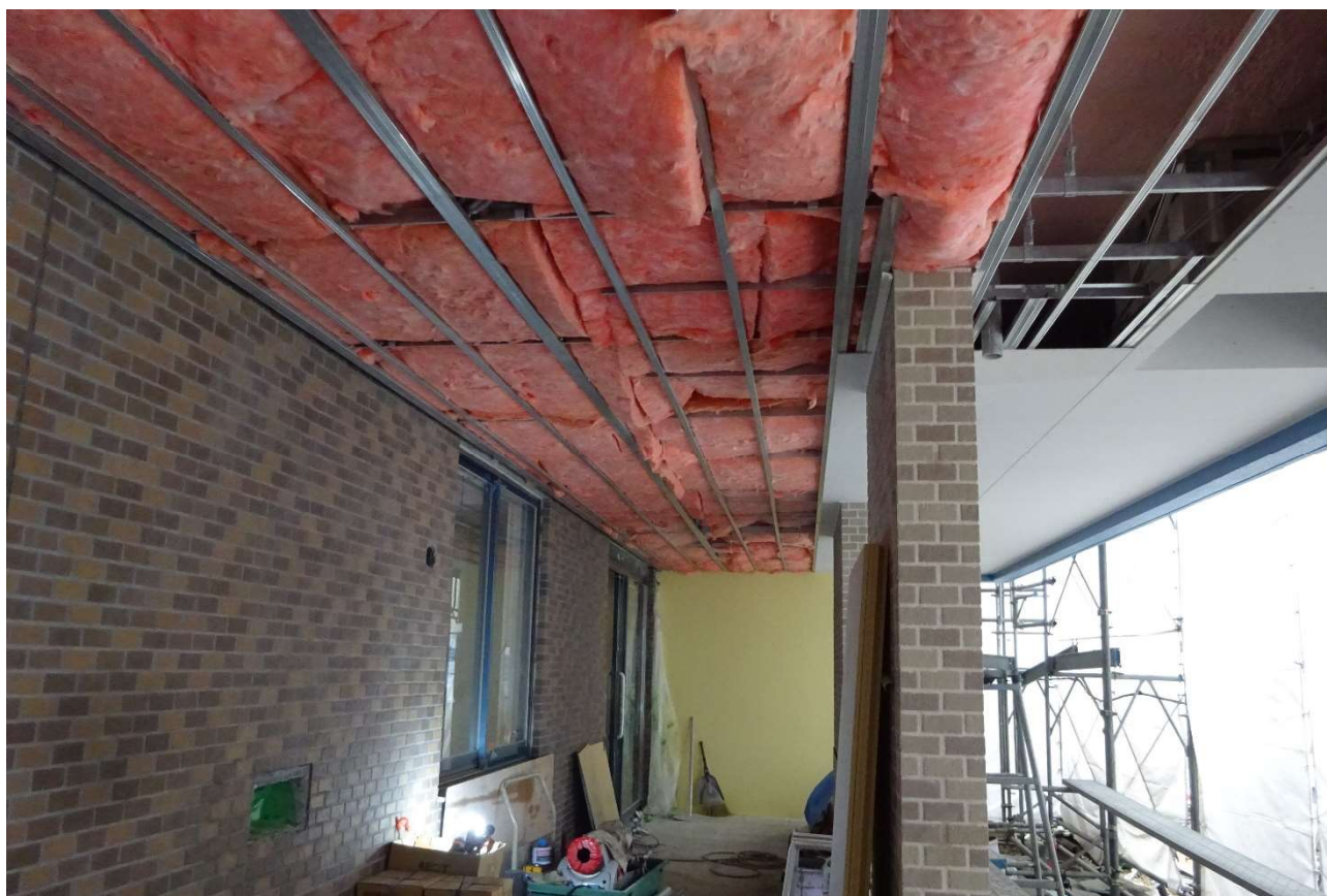
ポーチの天井を貼る前に断熱材が入られました。
