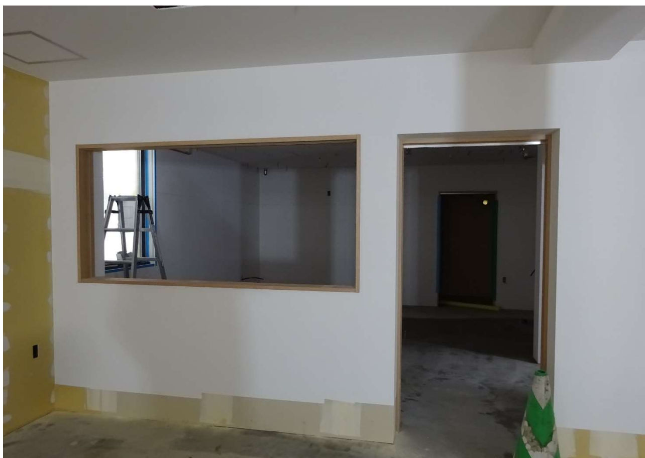
2階の厨房部も下地整備が終了しました。
