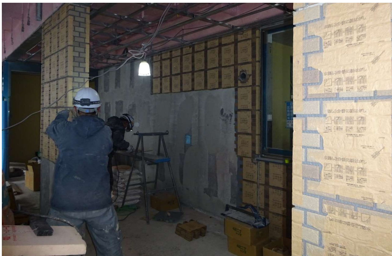
1階の玄関部へタイル工事が貼られています。
