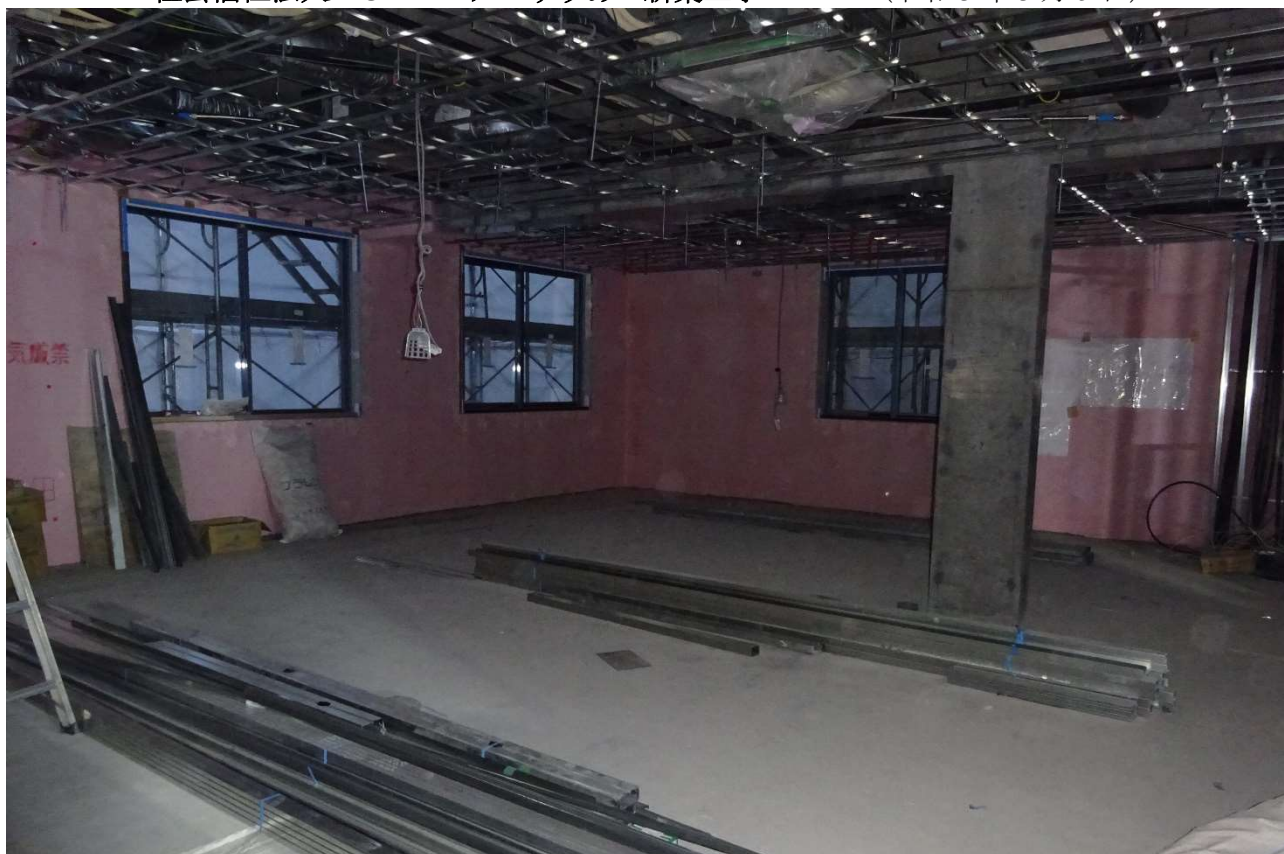
3階も軽量鉄骨組の設置が開始されました。
