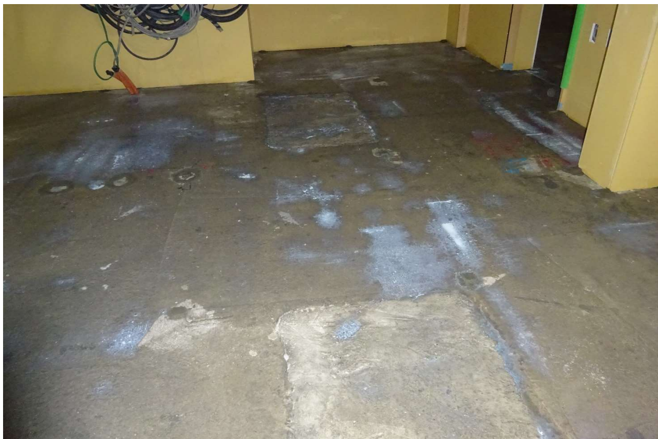
ホップ側の玄関から床モルタル施行後の状況を撮影しています。
