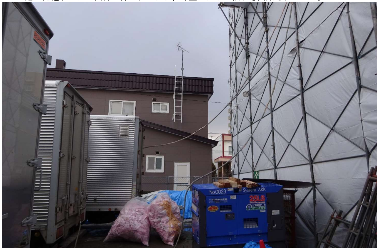
3階へのウレタン吹付用の専用車両3台がフルに作業中です。
