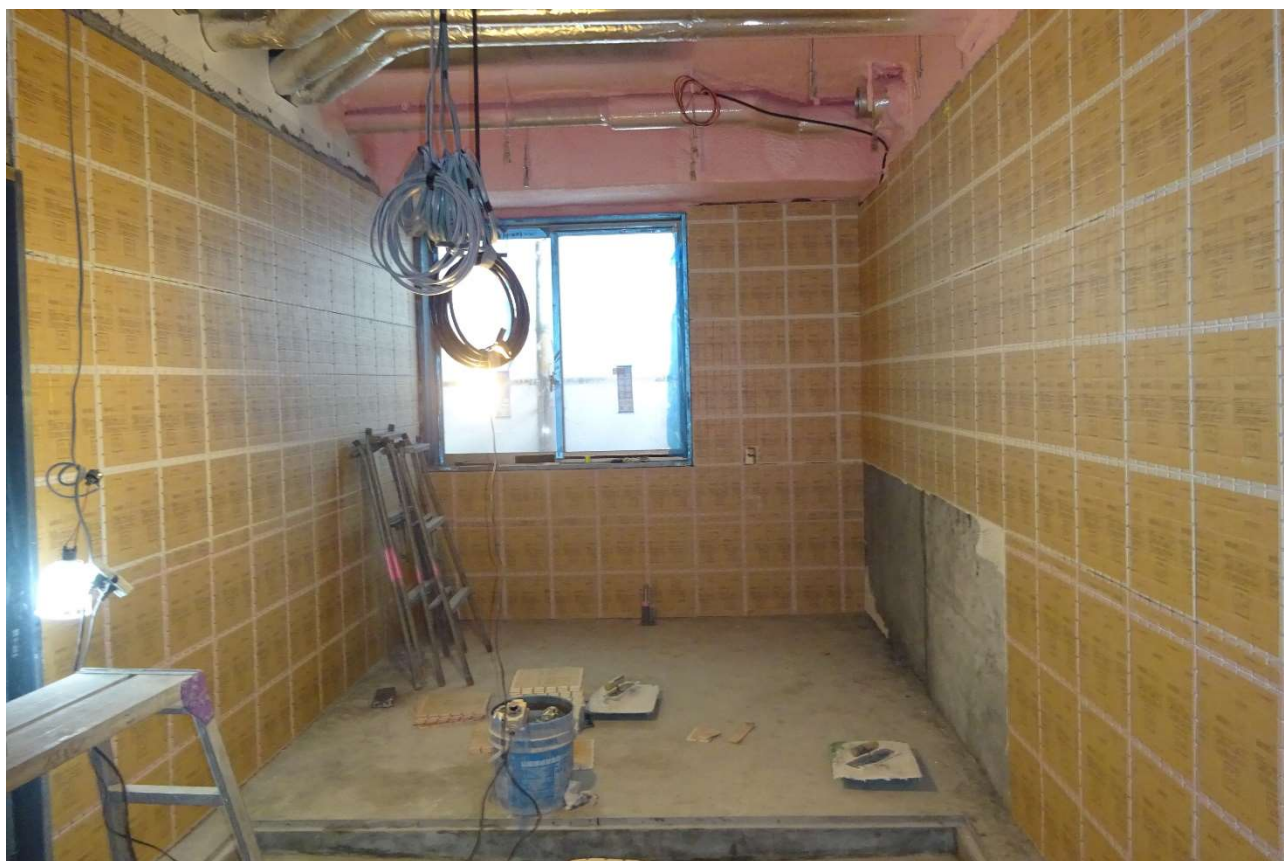
機械浴室の壁にタイルが貼られました。
