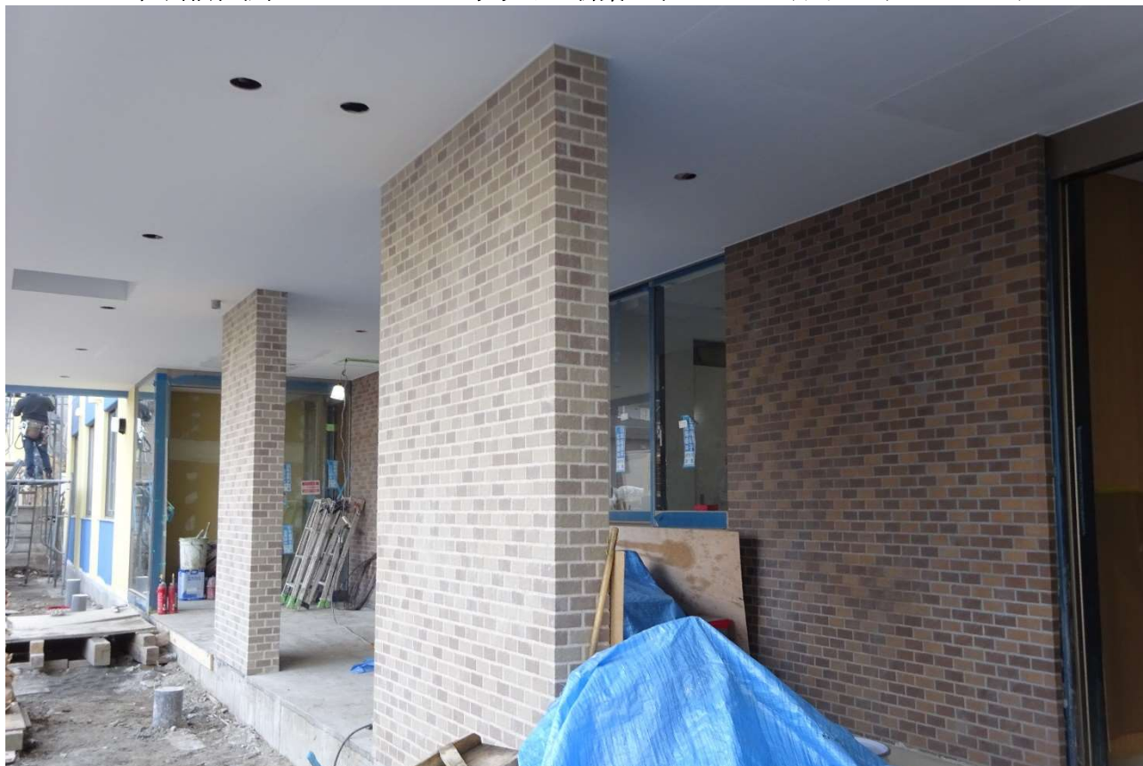
グループホーム（ケアホームゆうあい）の玄関と窓です。
