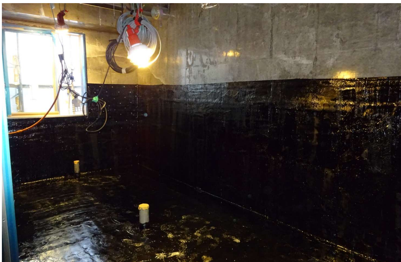
1階機械浴の防水は2日をかけて施行されました。
