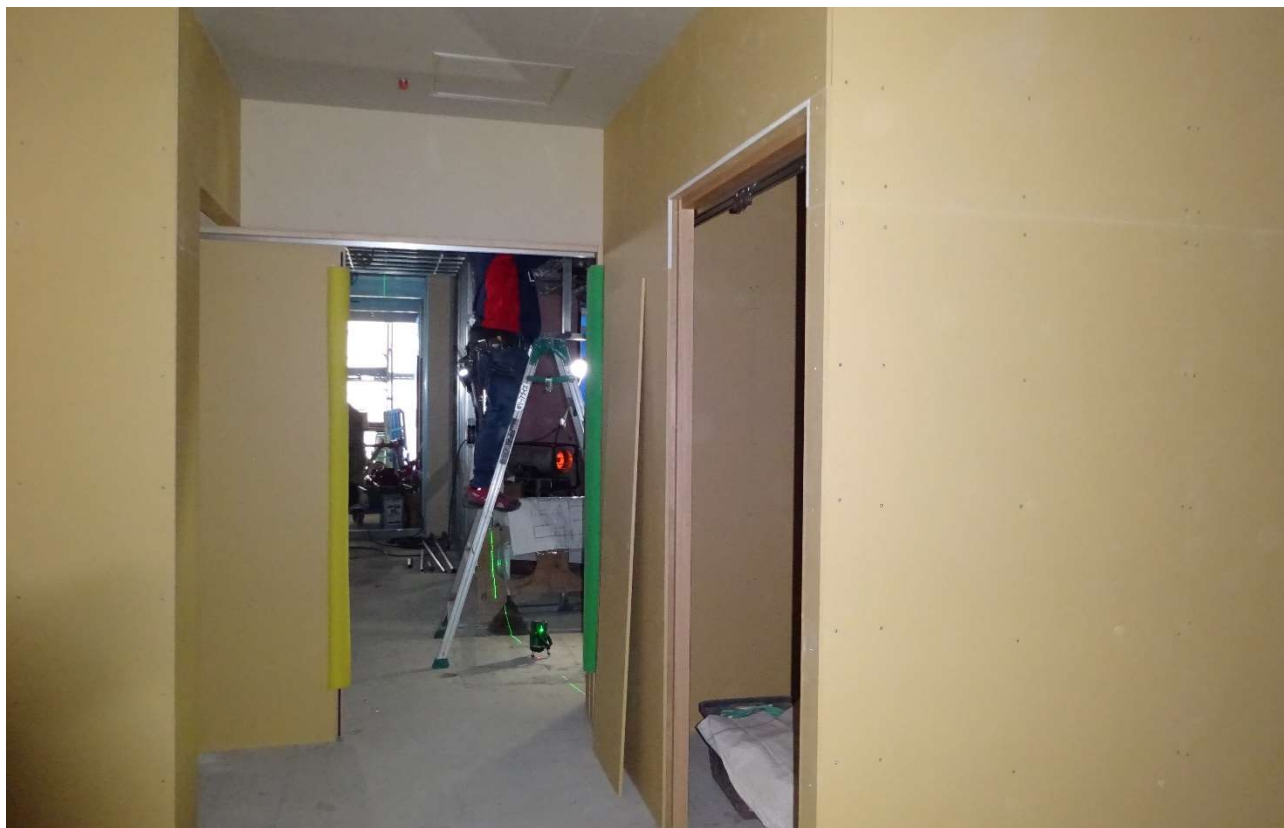
1階個室の内装の様子。
