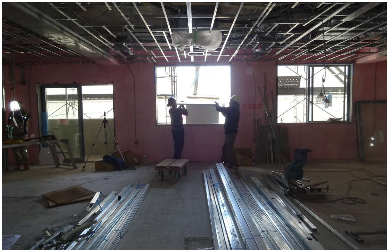
2階窓から石膏ボードが搬入されます。
