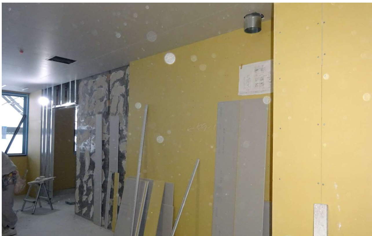
石膏ボードを貼る為の接着材を施行している状態です。
