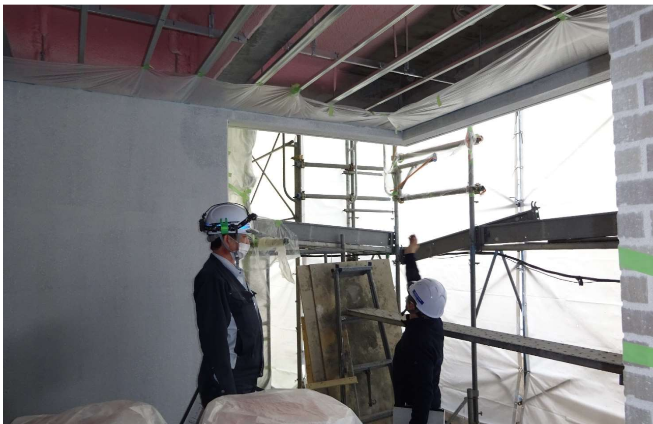
バルコニーの塗装仕上げの状態を確認しています。
