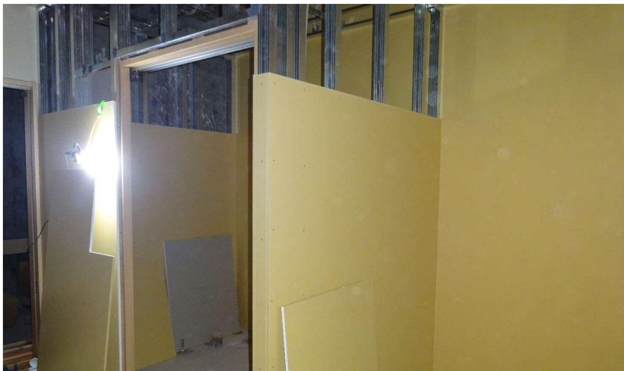
1階グループホームの個室トイレ石膏ボード施行状態です。
