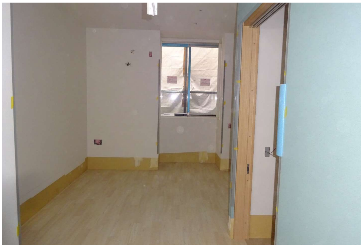
上記作業が終了した個室です。
