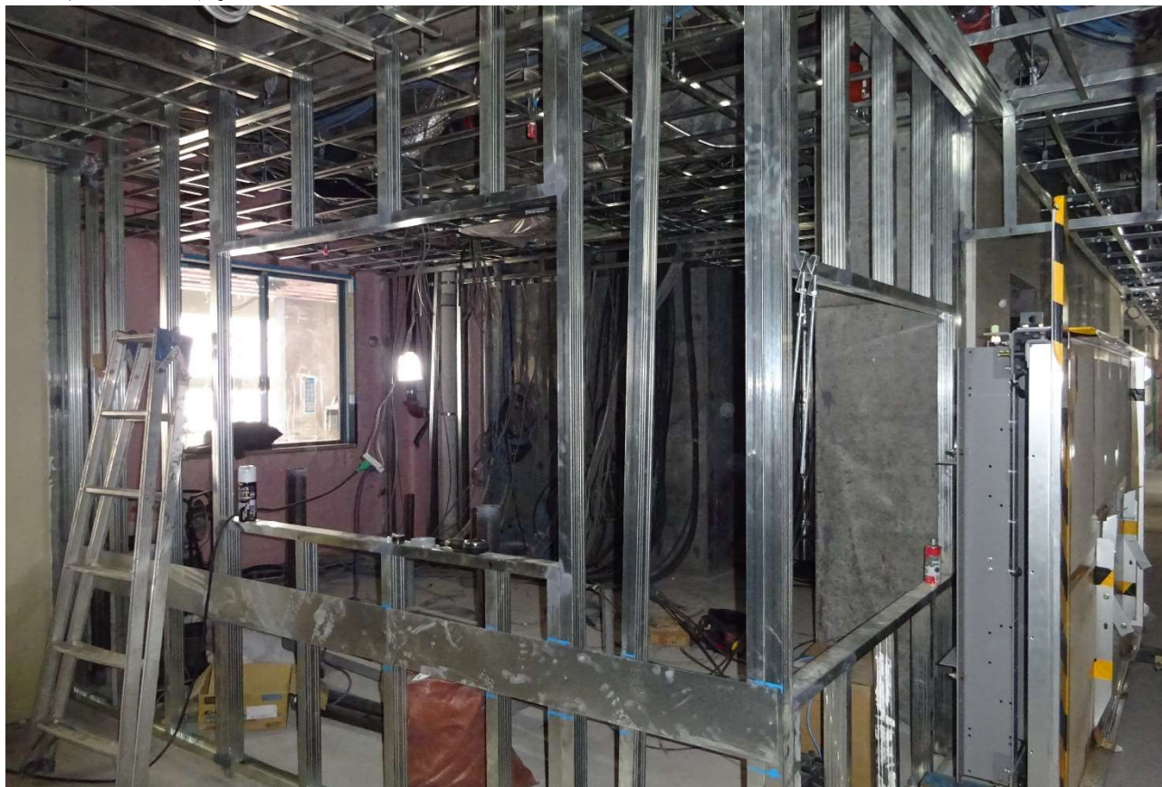
右側玄関にあるグループホーム事務室の受付カウンターの骨組です。
