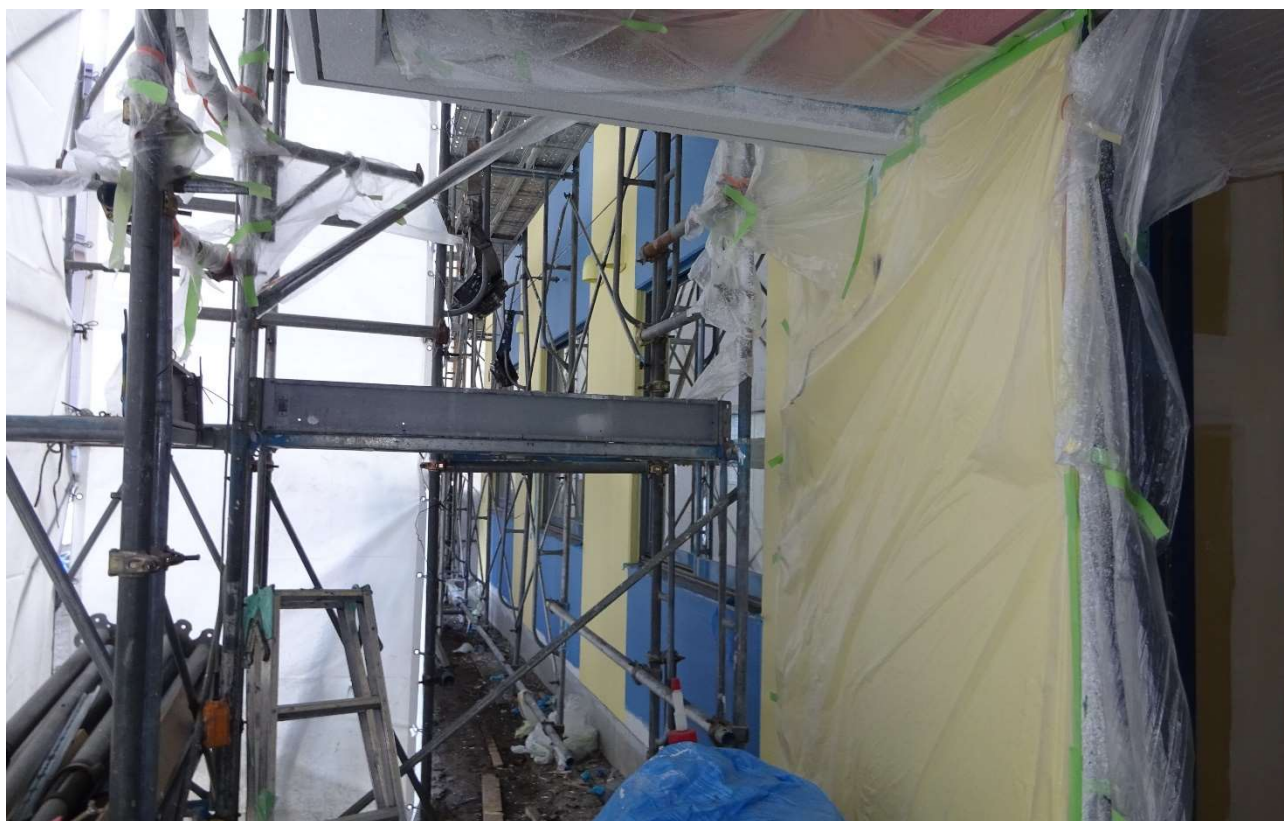
外壁塗装が終了しています。
