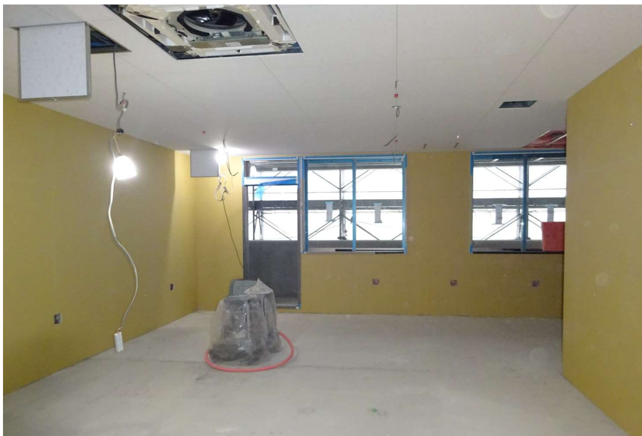
2階の相談事務室に石膏ボードが丁寧に張り付けられました。
