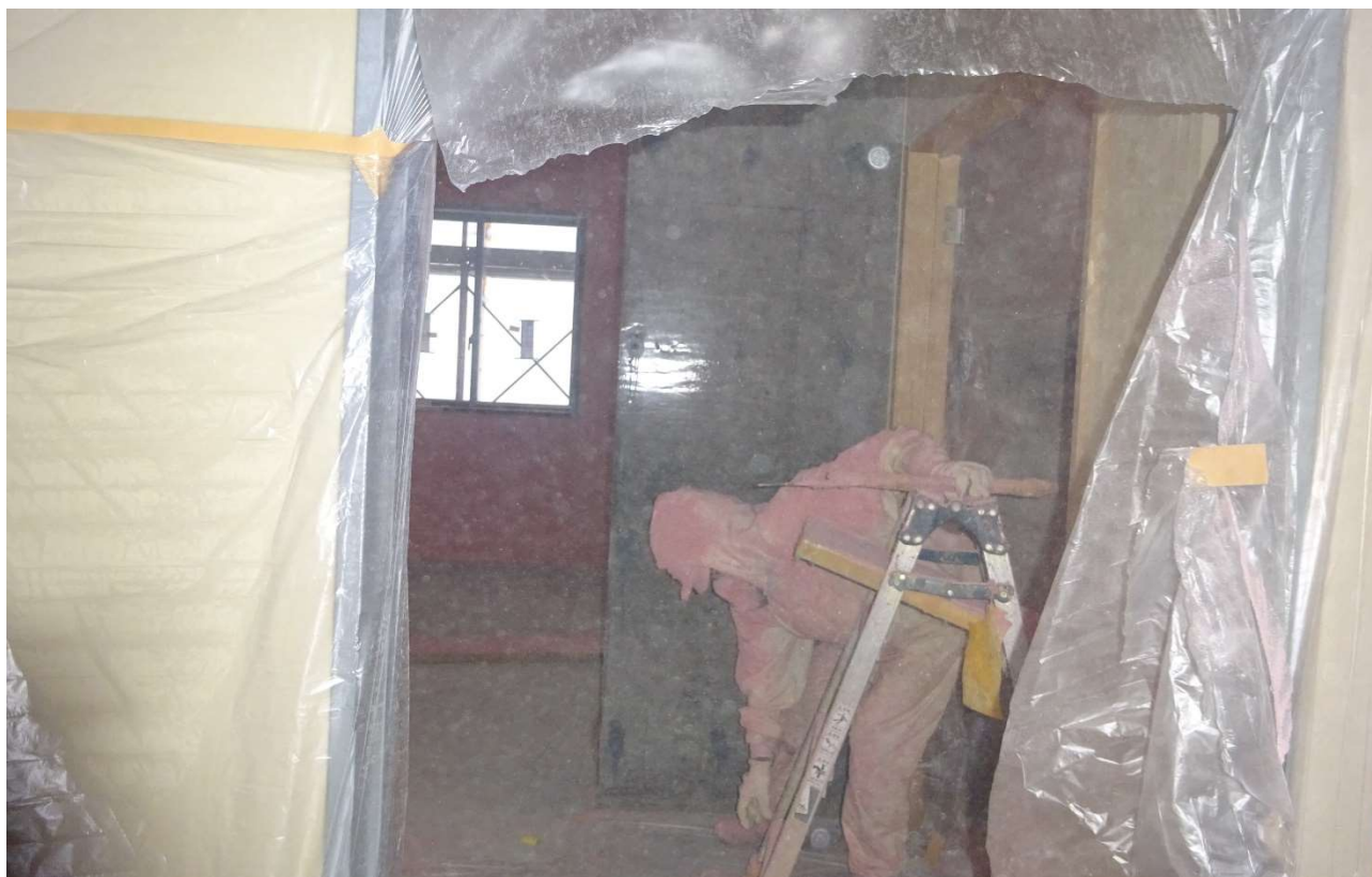
3階の発泡ウレタン吹付作業にて隅々まで断熱材を充填しています。
