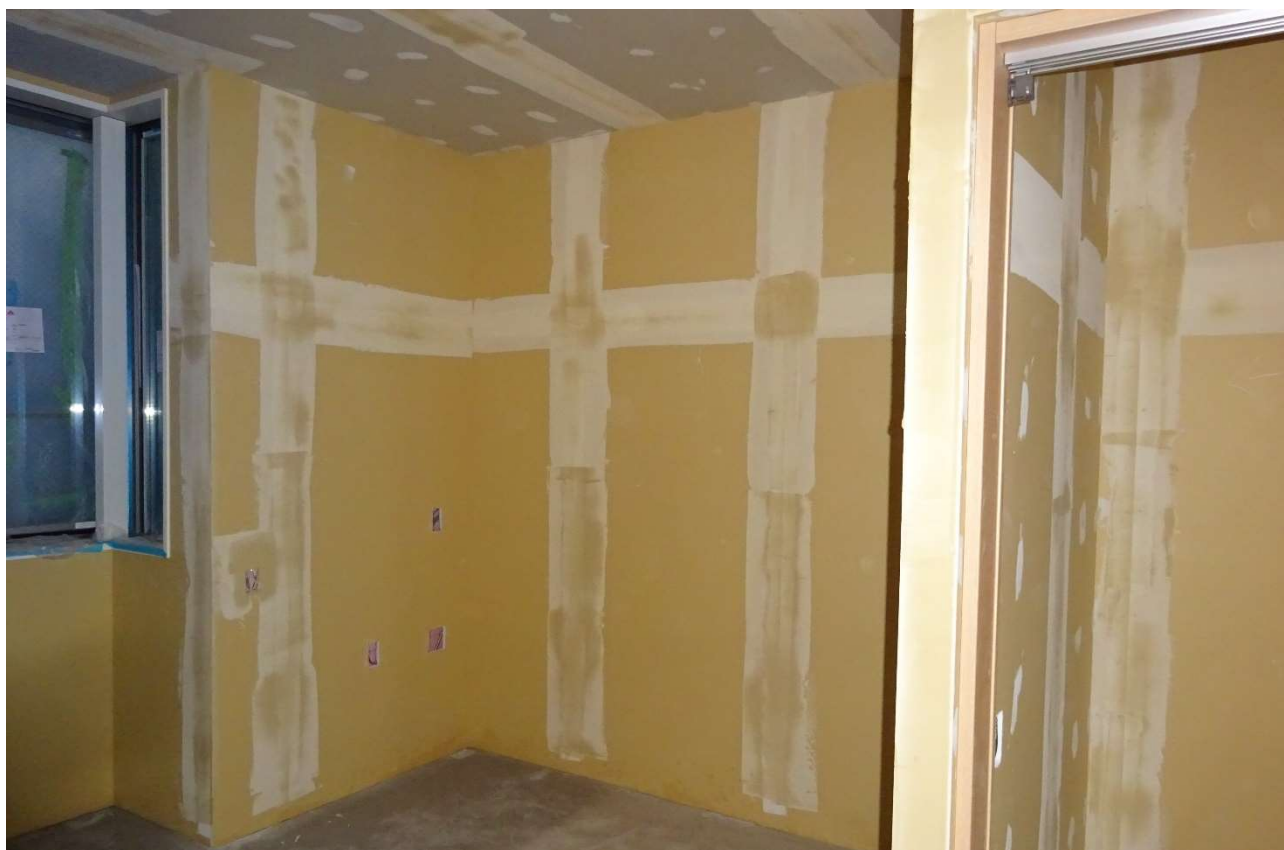
下地処理の状況が確認できています。
