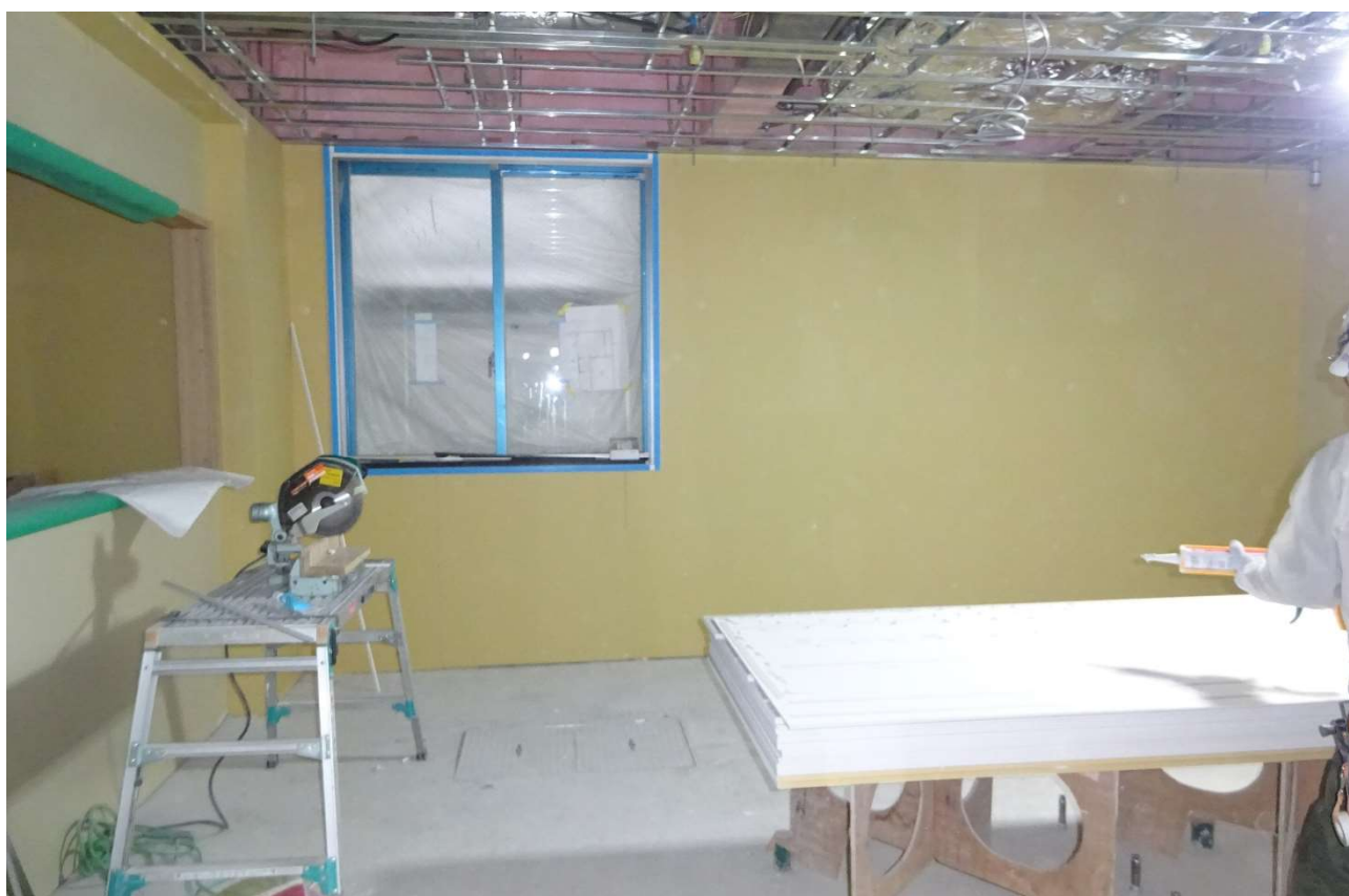
厨房内の石膏ボードを貼る準備を行っている状態です。
