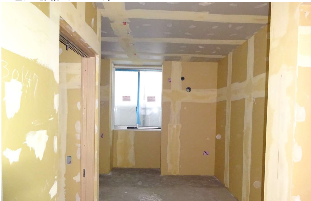
1階の個室の壁紙を貼る為の下地作業が終わった部屋です。
