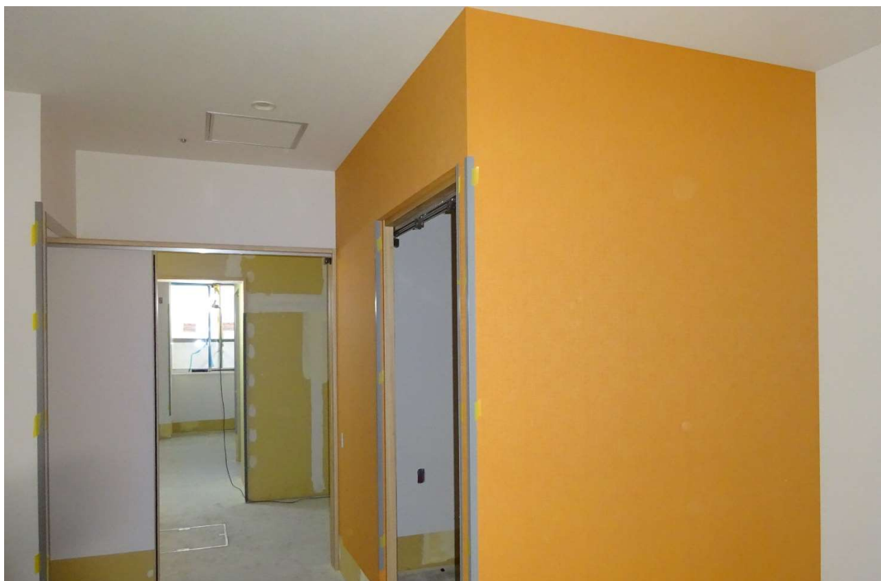
1階個室の壁紙が貼られた状況です。
