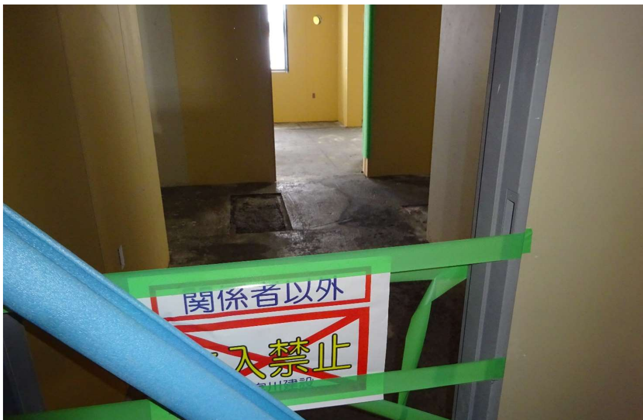
2階は床がモルタル仕上げで立ち入り制限されています。
