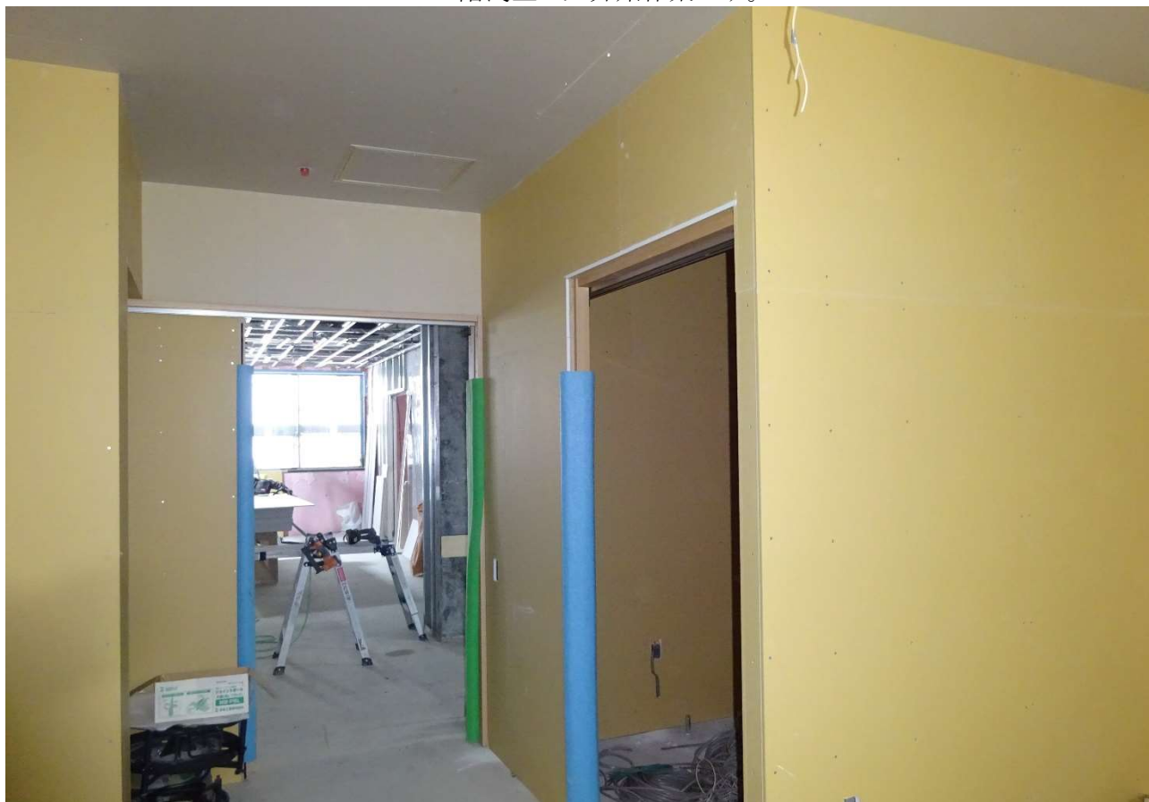
1階個室トイレのドア枠も取り付けられました。
