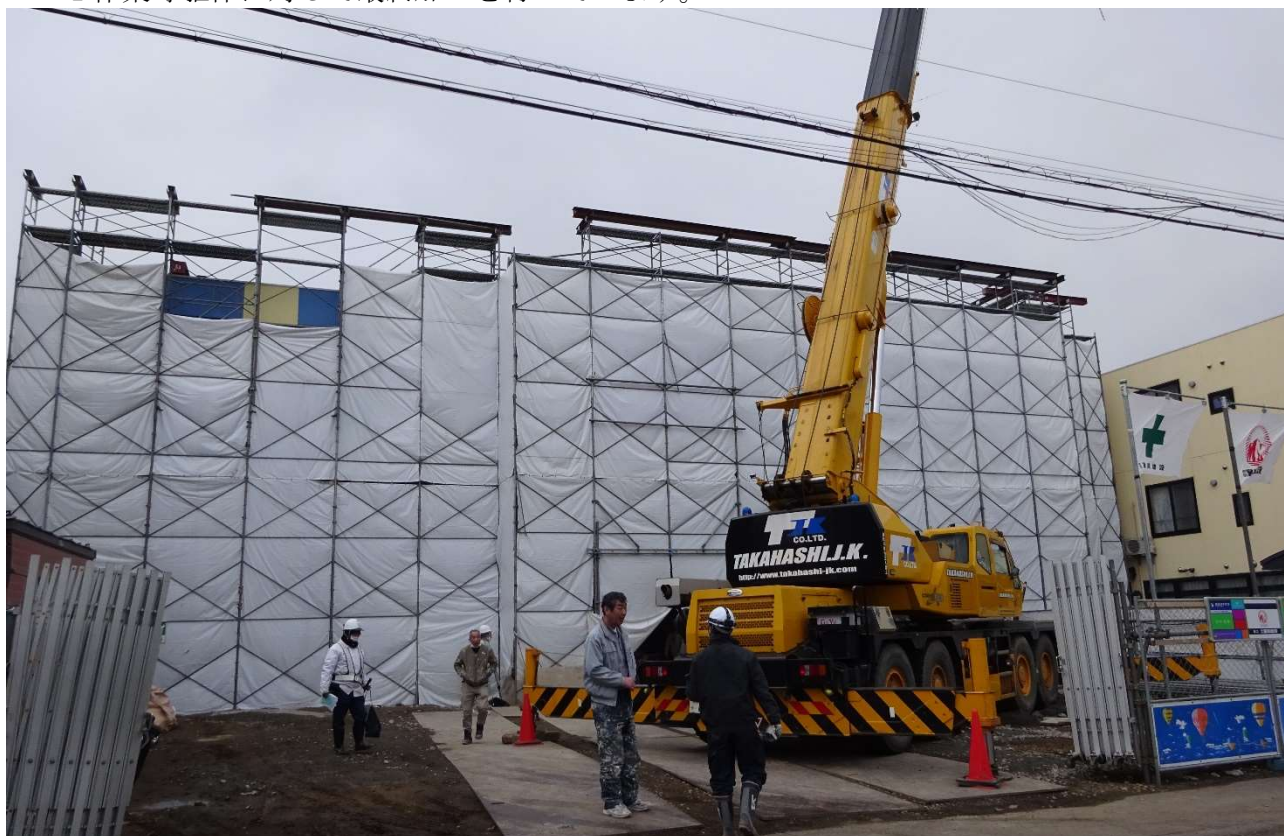
クレーンで建物を覆っていた屋根の部分が撤去されました。
