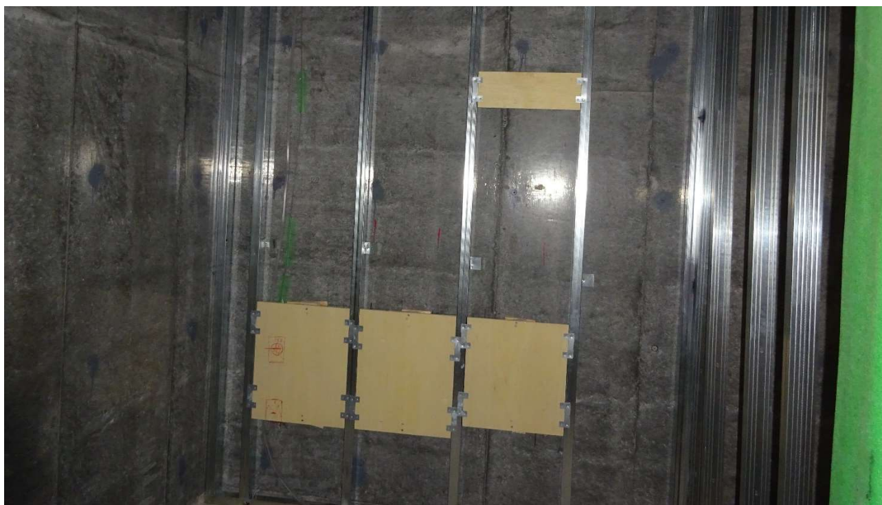
個室トイレの手摺の補強板です。
