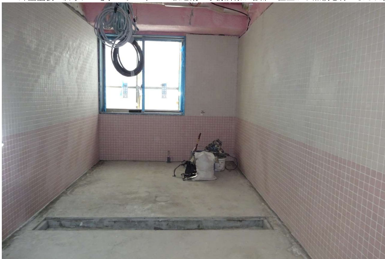
機械浴室のタイルが完成しました。
