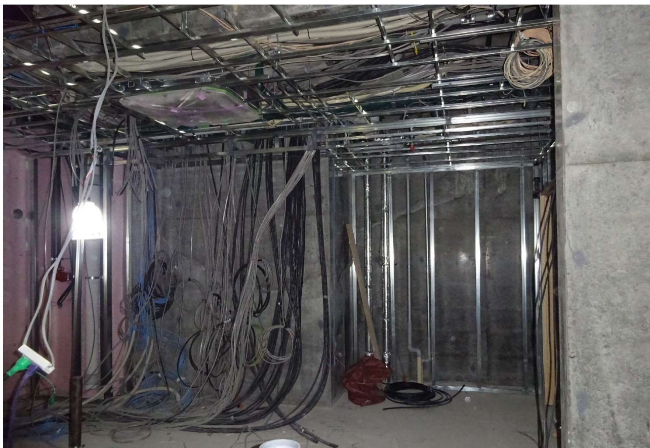
グループホーム事務室の天井の配線状況が確認できます。
