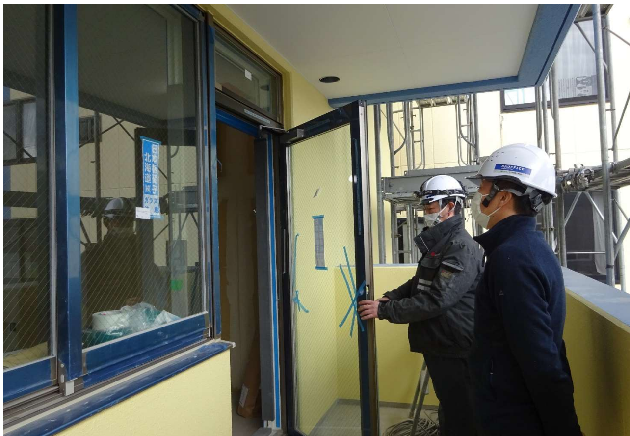
設計事務所と工事現場の所長が調整を行っています。
