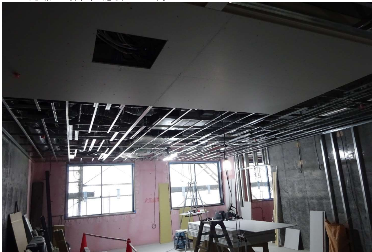
2階食堂の天井貼作業です。
