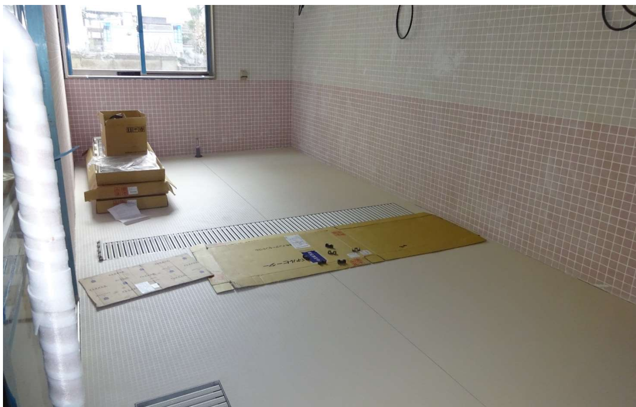
機械浴室の床材とグレーチング（排水施設）が整備されました。
