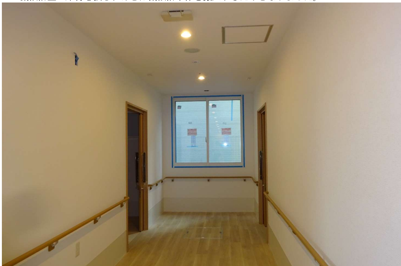
1階の廊下の手すりの状態です。
