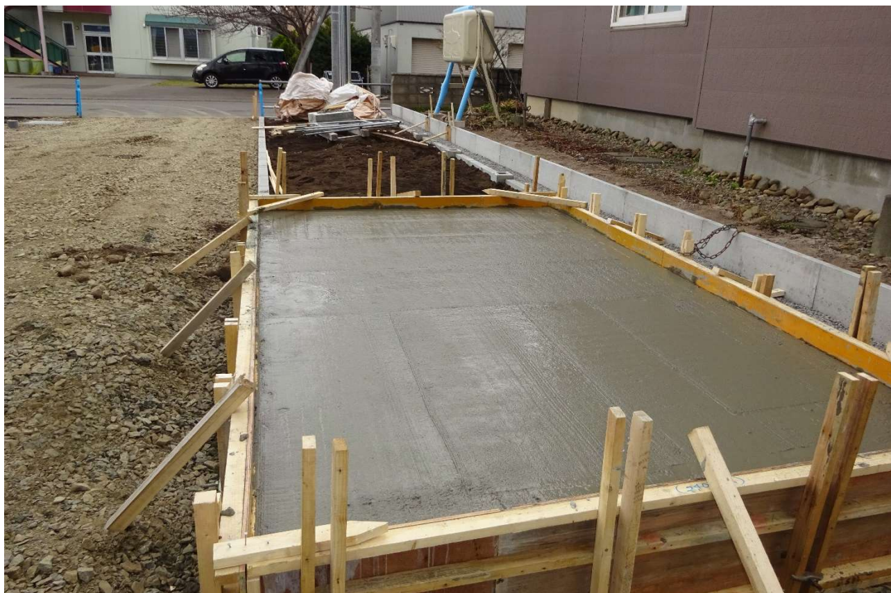
北側から撮影しています。
