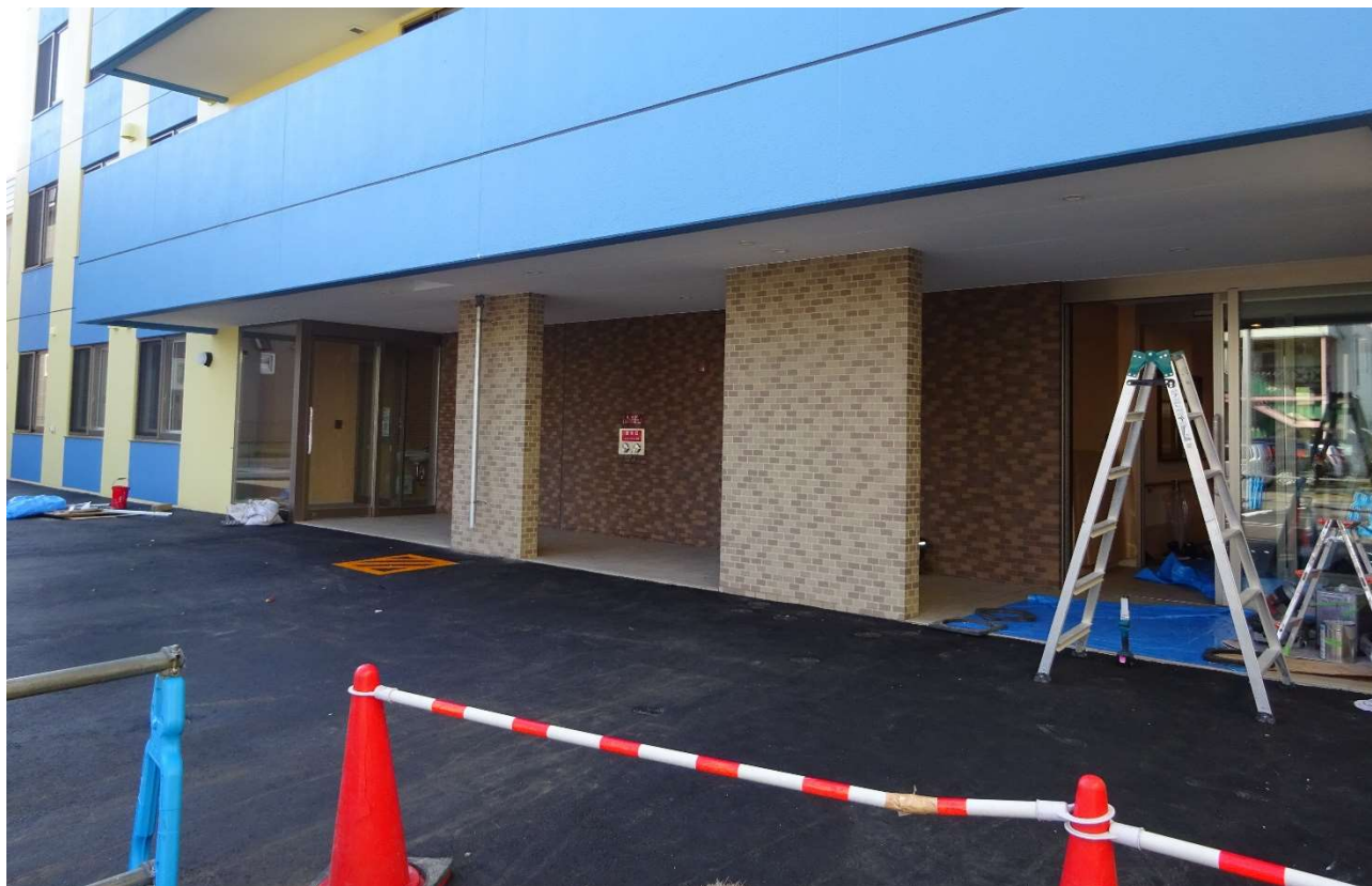
玄関前のアスファルト舗装も綺麗に仕上がりました。
