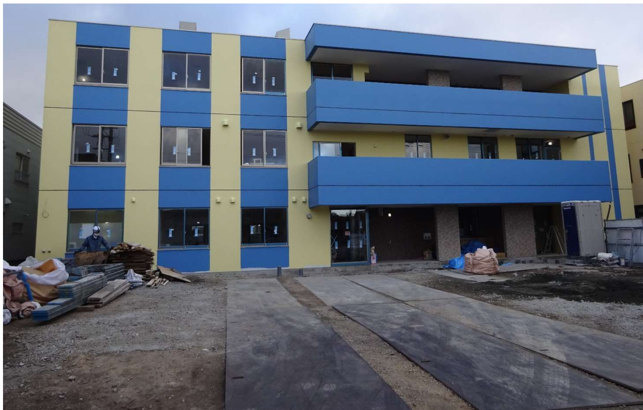
外構工事の準備で建物前面も整備されてきました。
