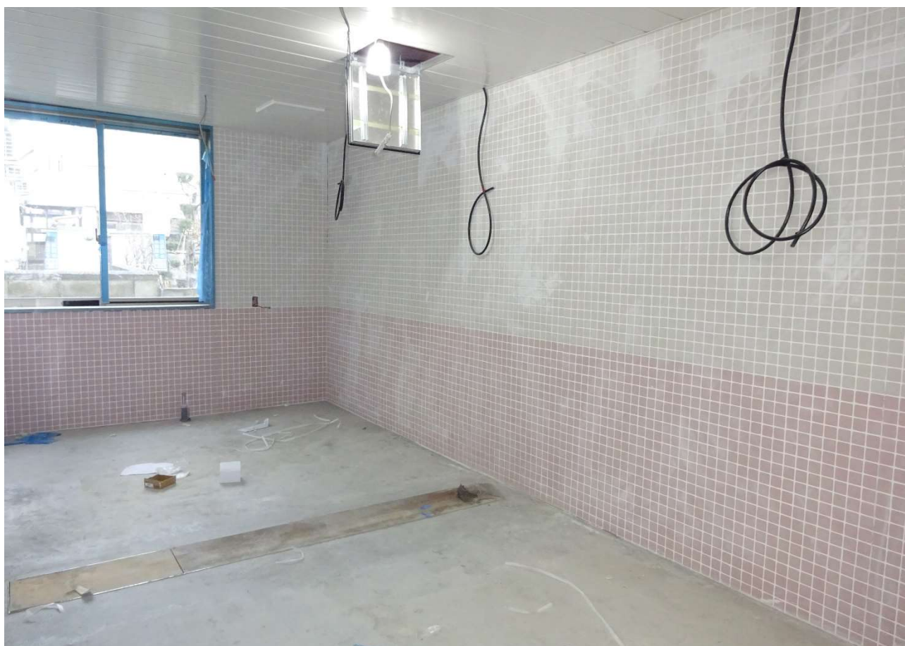
ケアホームゆうあいの機械浴室は広く明るいです。
