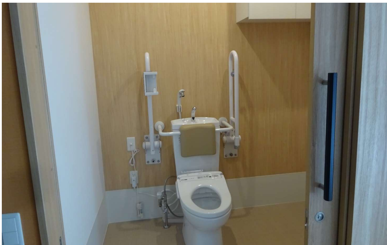
1階の個室トイレの便器中央置きタイプです
