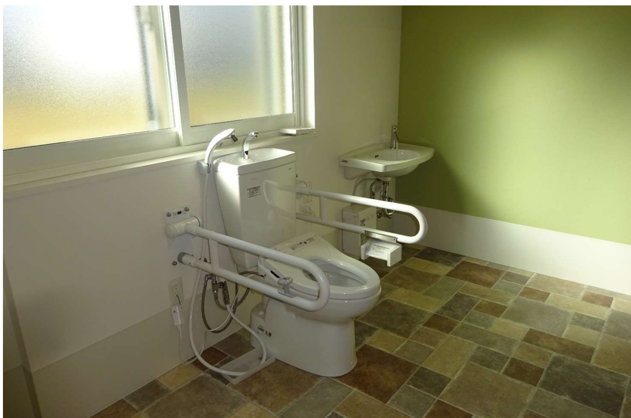
2階の多目的トイレです。
