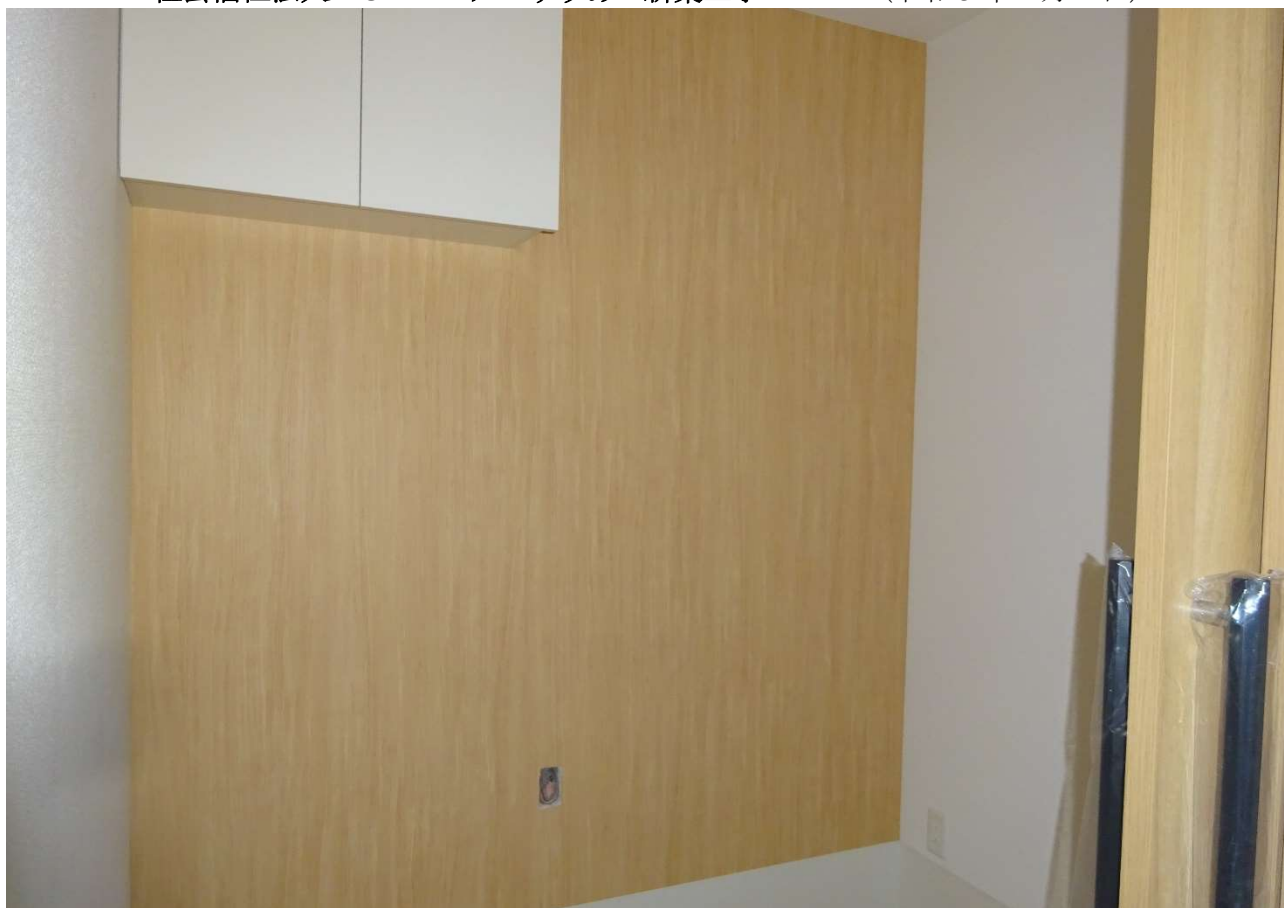
ケアホームゆうあいの個室のトイレ内部の壁です。
